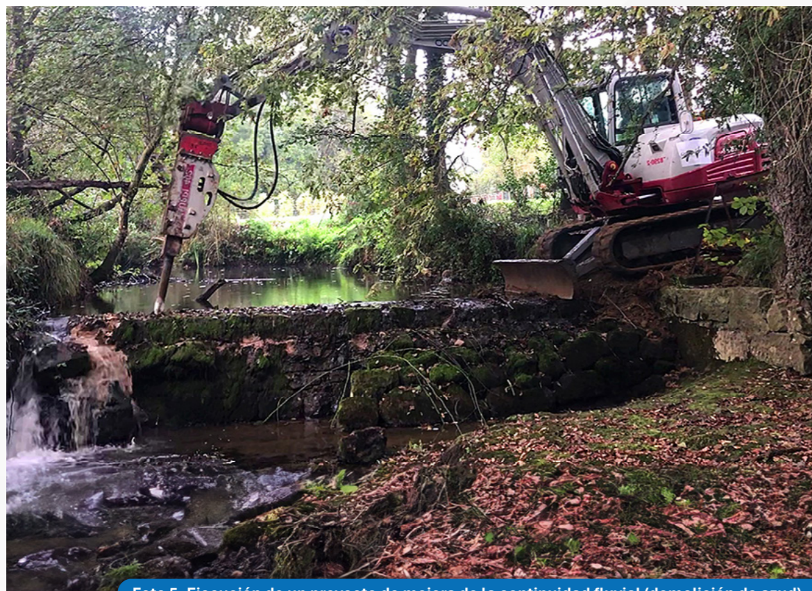
Foto 5. Ejecución de un proyecto de mejora de la continuidad fluvial (demolición de azud)
