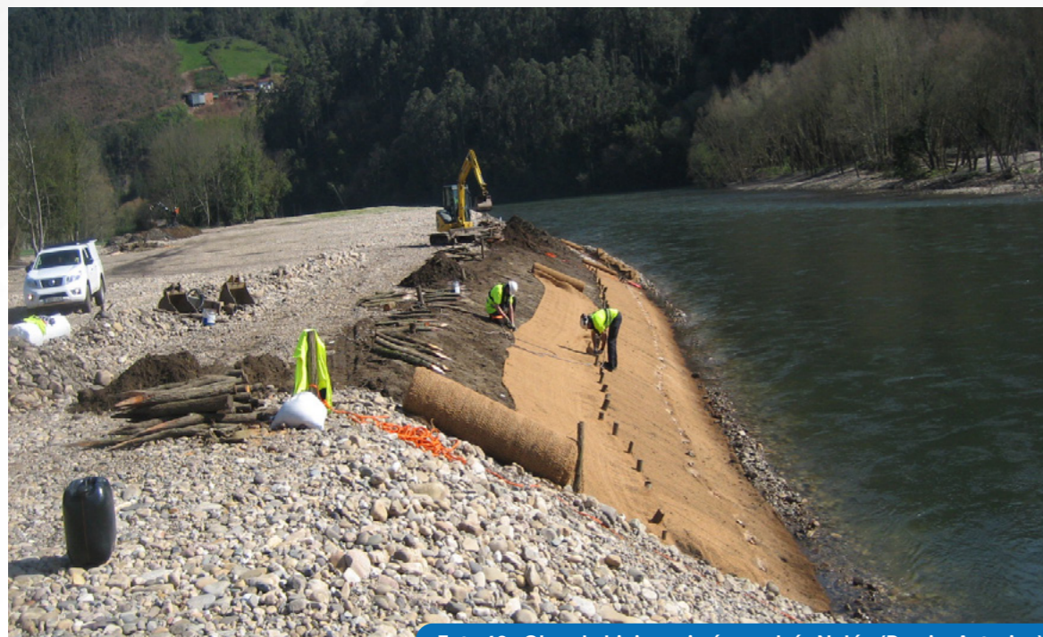
Foto 12. Obra de bioingeniería en el río Nalón (Pravia, Asturias)
