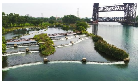
Estación de aireación de piscina elevada lateral (SEPA nº 1). Fuente: (MWRD, Chicago)
