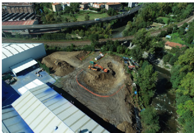
Excavación bombeo Llodio.
