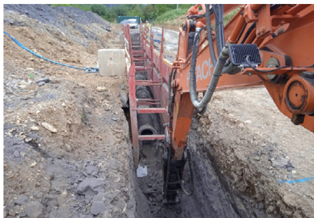
Colocación de la tubería.
