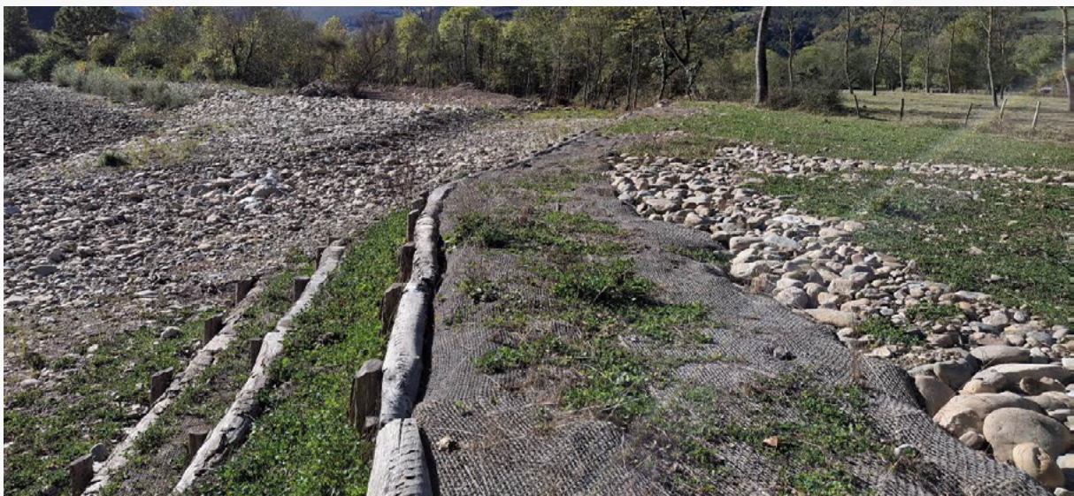
Actuaciones en el entorno del río Saja en Terán, T. M. de Cabuérniga (Cantabria).
