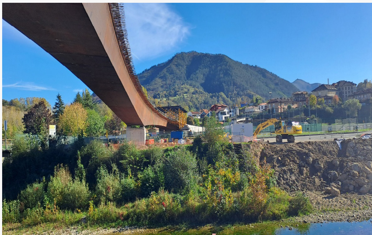
Ejecución del nuevo puente.
