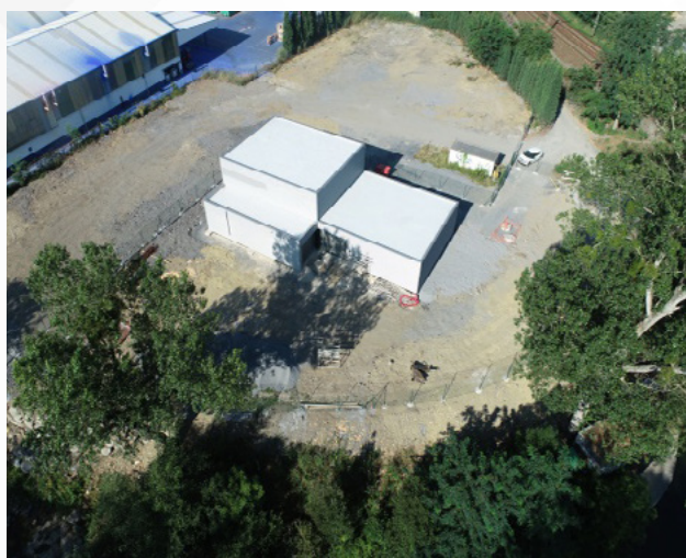
Estación de bombeo de Llodio.
