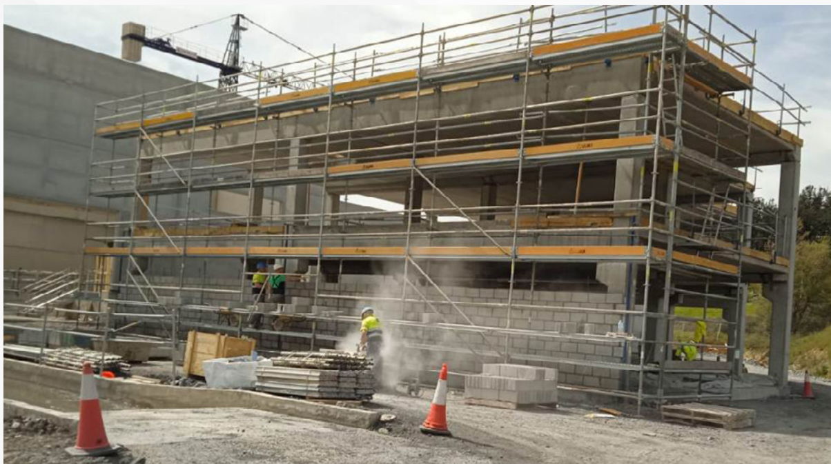
Construcción del edificio de control de la EDAR de Markijana.
