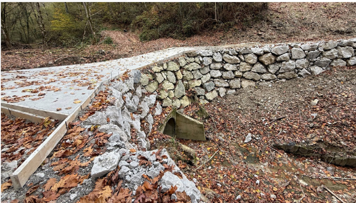
Obras accesorias en el entorno de la presa de Ibiur.
