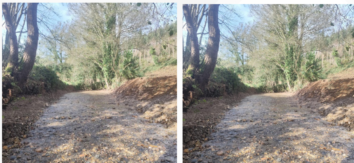
Figura CA.11 Demolición del azud río Cabo en San Agustín en Tapia de Casariego (Asturias)
