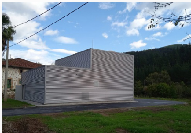
Estación de bombeo Luandio.
