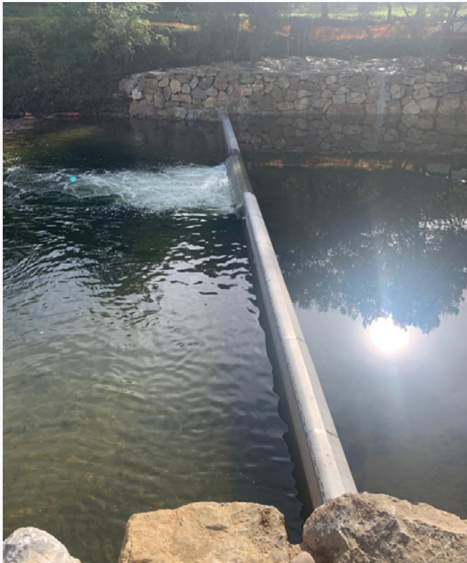
Figura CA.8 Estación 1256 del río Nansa en Rábago – Dispositivo de aforos
