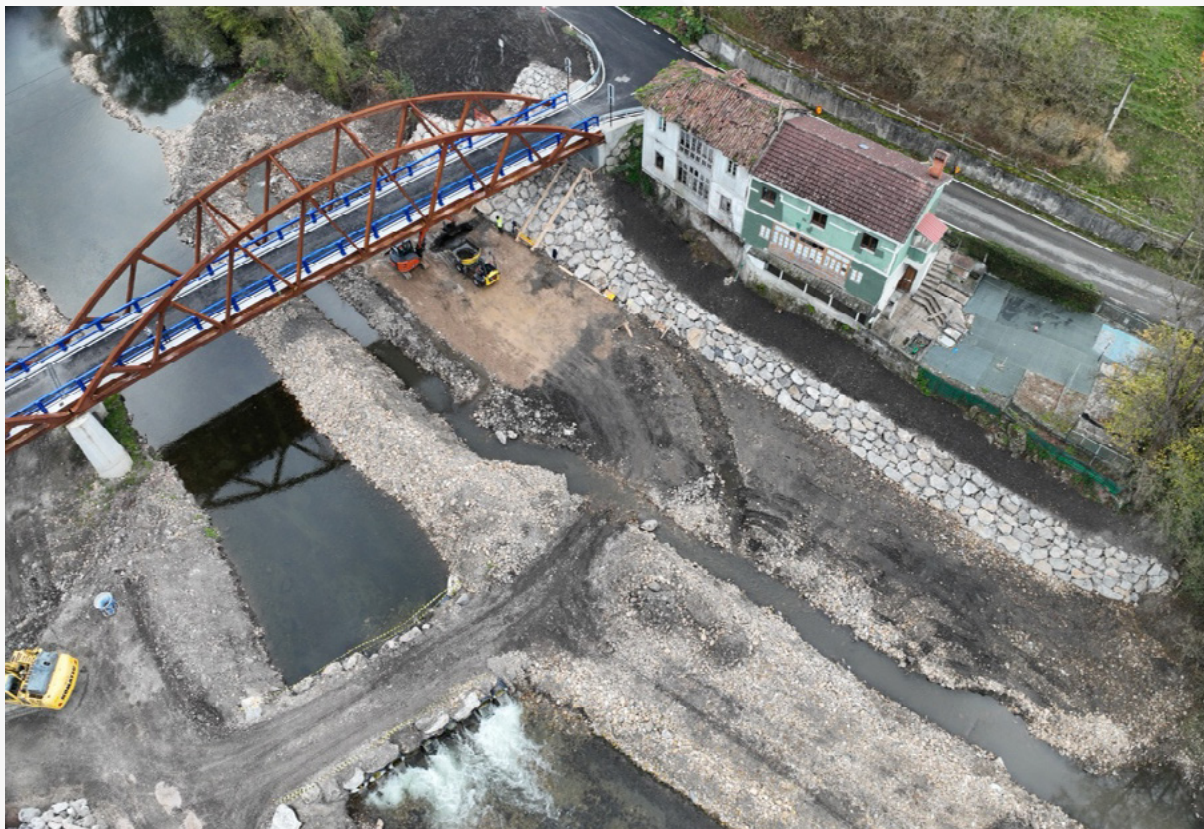
Figura CA.14 Obras de la nueva estación SAI del río Nalón en Olloniego (Oviedo, Asturias)
