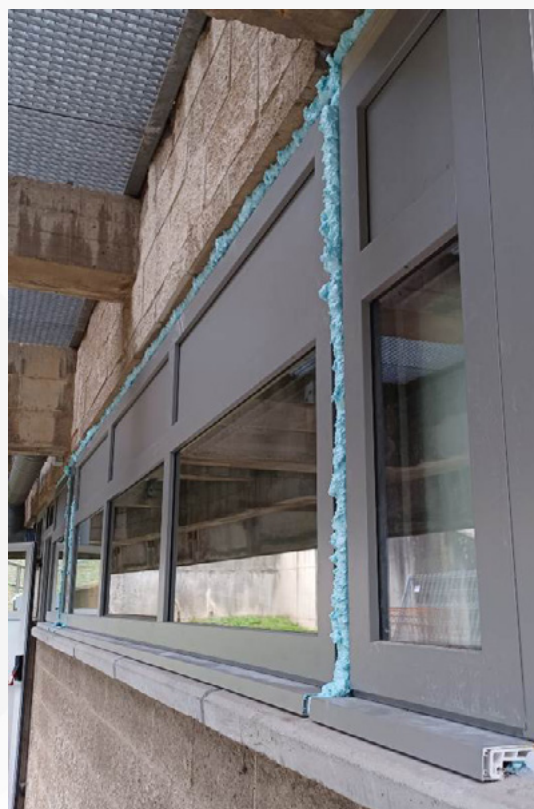
Ejecución de obras en el edificio de La Fresneda.
