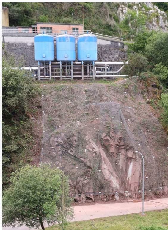
Talud situado en la margen izquierda de la presa, ya estabilizado.
