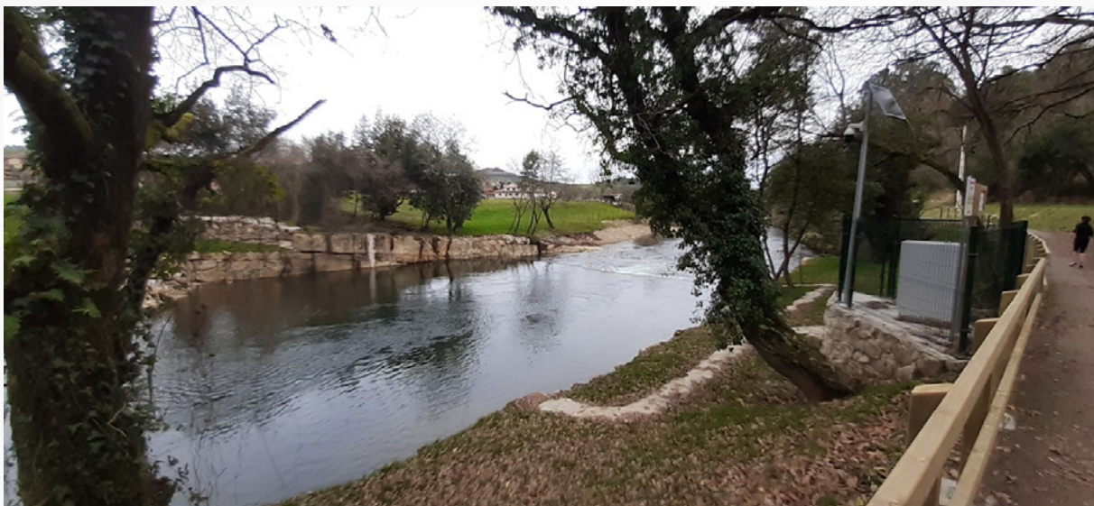
Figura CA.7 Estación 1243 del río Saja en Villapresente (Reocín – Cantabria) – Armario de señales
