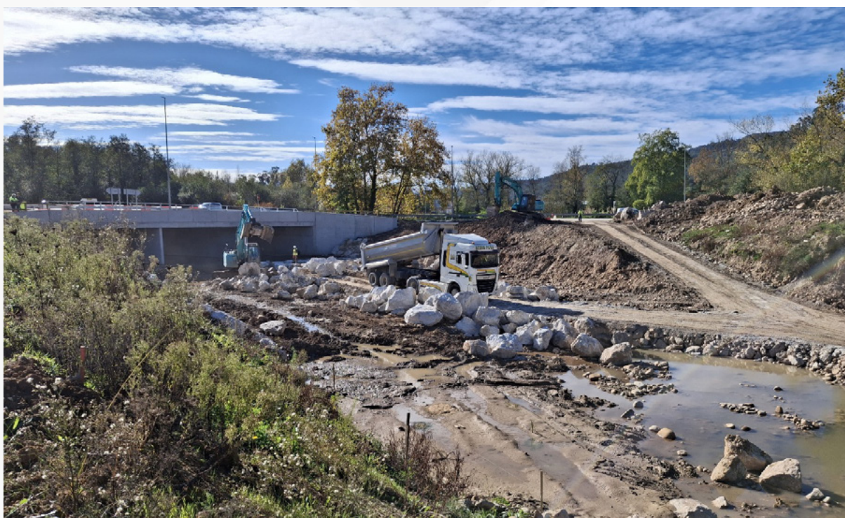
Ejecución de las obras.
