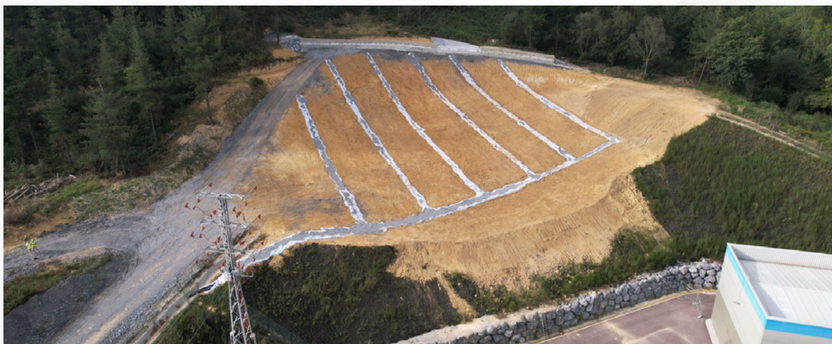
Adecuación del talud.
