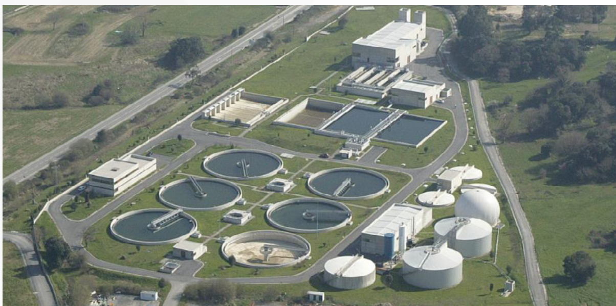
Vista actual de la EDAR de San Pantaleón
