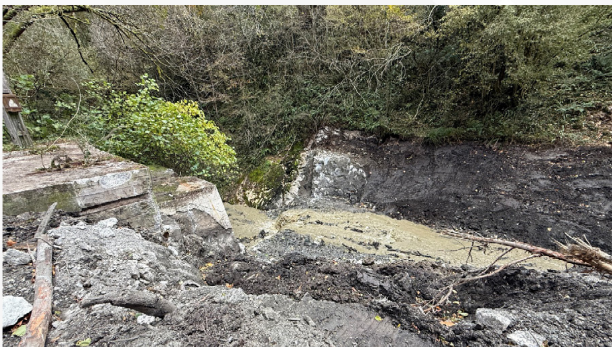
Eliminación de azud en la regata Latsa.
