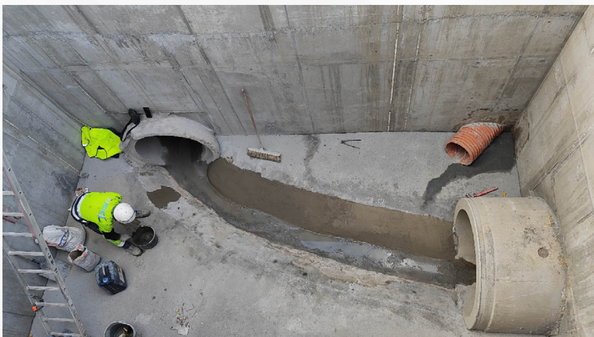
Ejecución de remates en pozo de salida.
