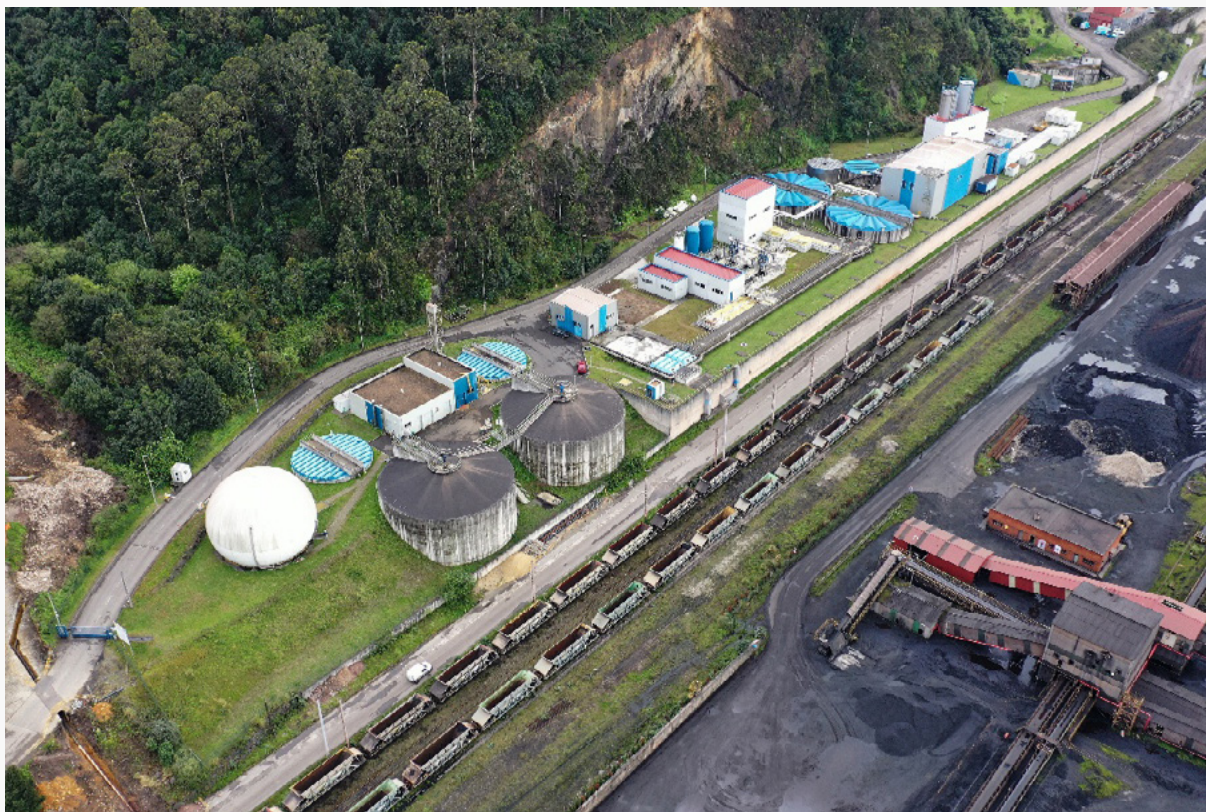
Vista de la EDAR de Gijón Oeste.
