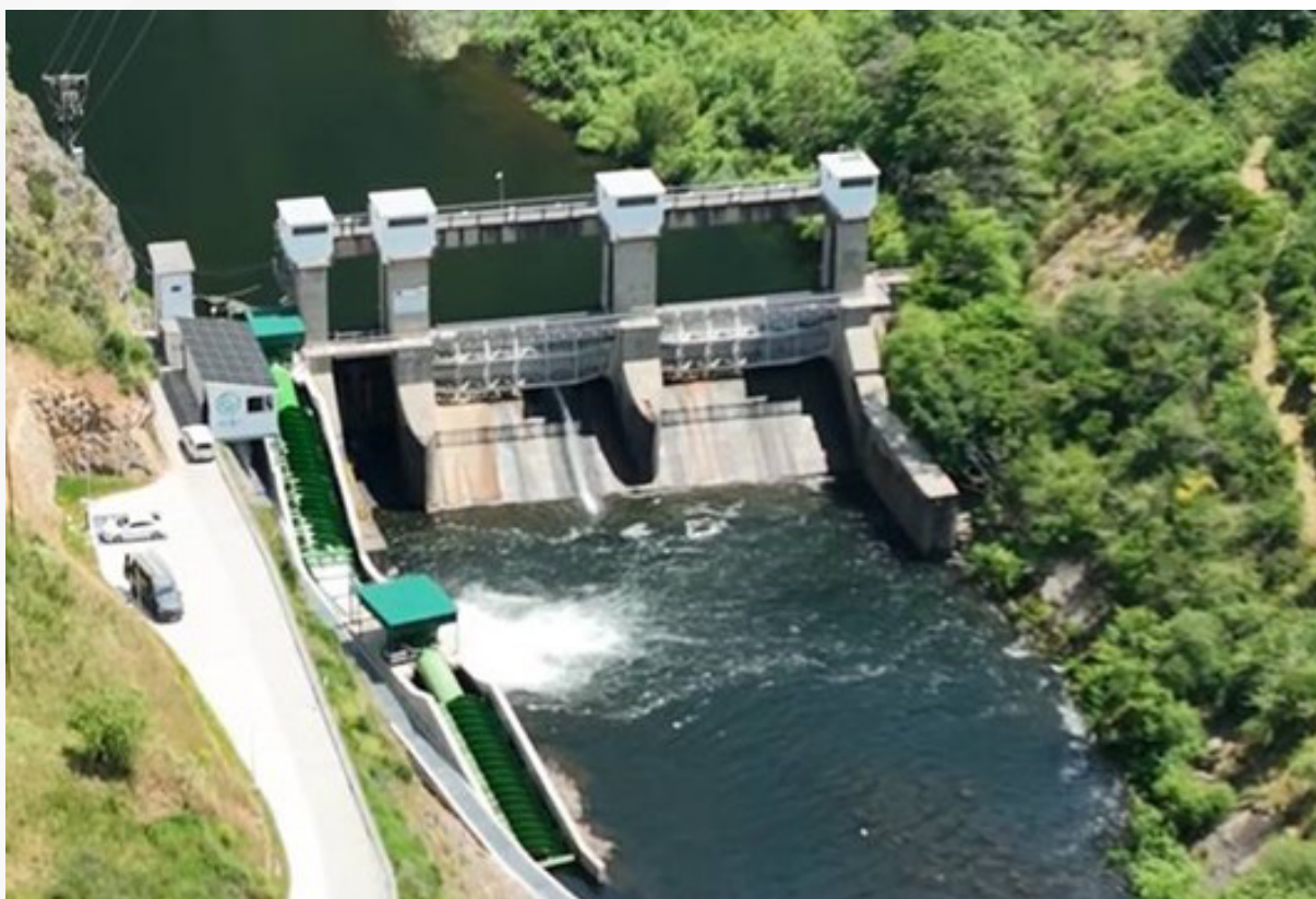
Figura CA.3 Liberación de caudales ecológicos a través de hidrotornillos. Presa La Florida. Río Narcea. Asturias.
