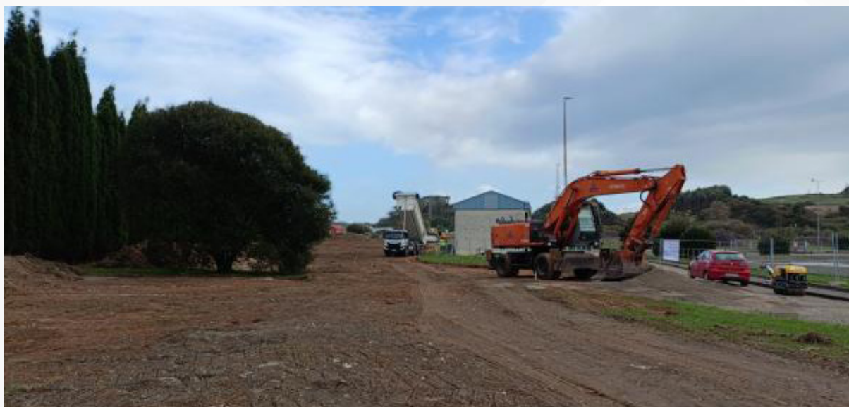
Ejecución de las obras de mejora en la EDAR de Maqua.
