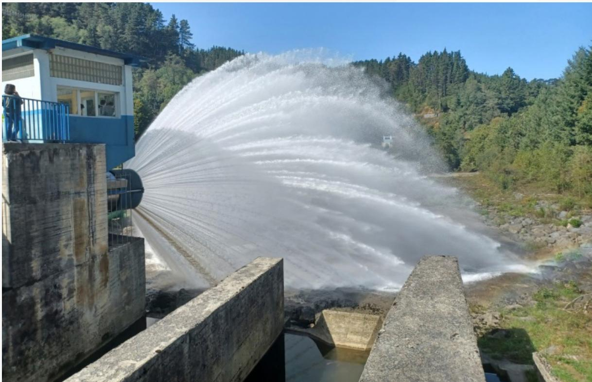
FIGURA CA 3. Accionamiento desagüe de fondo embalse de Undúrraga. Río Arratia. Bizkaia
