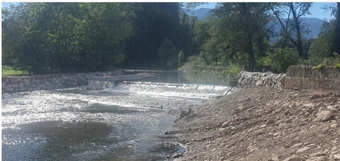
FIGURA CA 12. Permeabilización del azud de la Cobrera río Besaya en Sta. Cruz de Iguña, Molledo (Cantabria)
