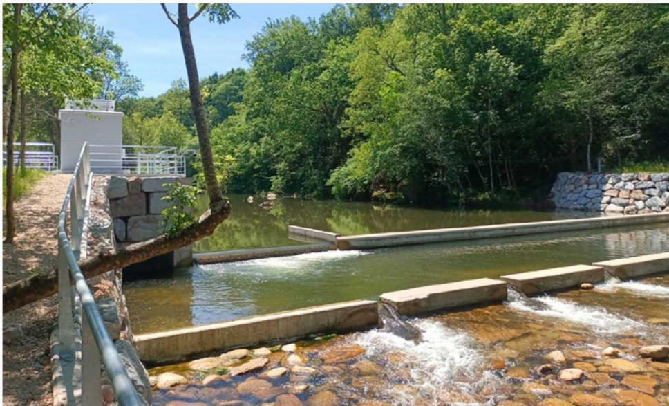
FIGURA CA 8. Estación 1256 del río Nansa en Rábago ☒ sección de control
