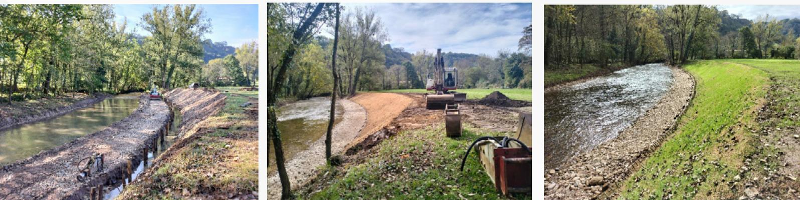
FIGURA CA 11. Recuperación de orilla erosionada y de la vegetación de ribera Río Güeña en Susierra, Cangas de Onis (Asturias)
