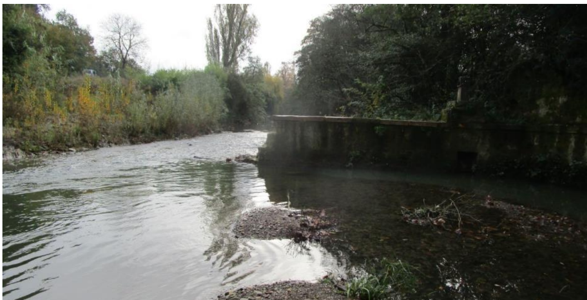
Figura 23. Estado del azud de Arripauseta después de su demolición parcial.
