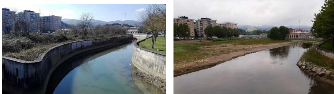
Figura 31. Recuperación ambiental de la regata Iñurritza en Zarautz: antes de la actuación (izquierda) y después de la retirada del muro de hormigón y acondicionamiento de las márgenes (derecha).
