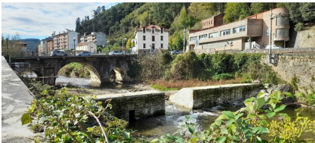
Figura 15. Aspecto actual del río Cadagua en la presa de La Conchita, tras la apertura de un vano central.
