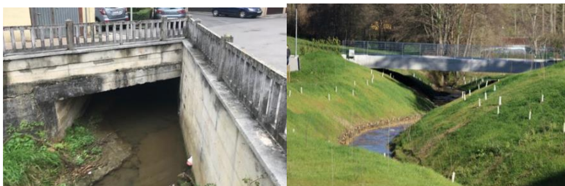
Figura 25. Entrada en cobertura del arroyo Toloto antes de las obras (izquierda) y aspecto actual del cauce a cielo abierto (derecha).
