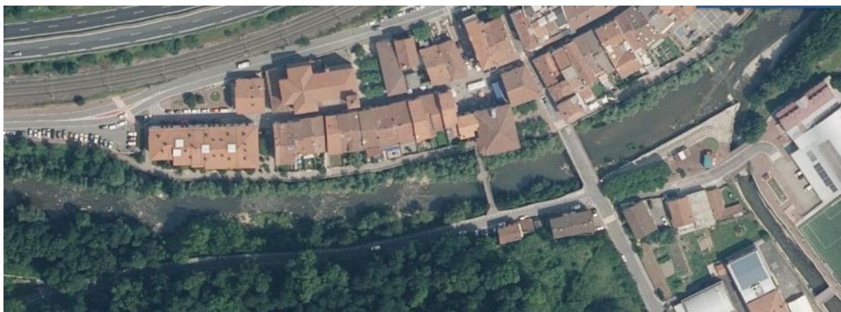
Figura 34. Río Oria a su paso por el ARPSI ES017-GIP-14-3 antes y después de la retirada de los azudes (arriba y abajo, respectivamente). La ubicación de los azudes se muestra mediante círculos blancos en la imagen previa a la demolición.
