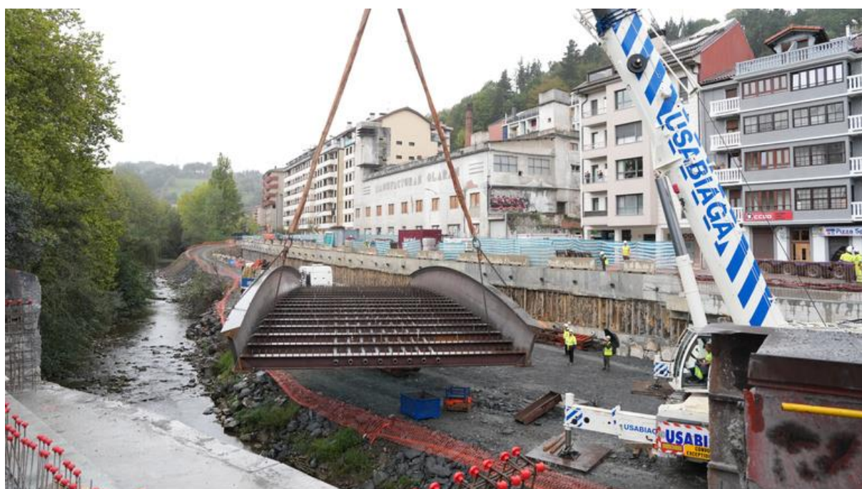
Figura 32. Colocación del nuevo puente sobre el río Oria como parte del «Proyecto de prevención de inundaciones en la cuenca del río Oria, en el término municipal de Beasain».
