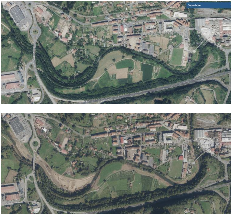
Figura 14. Tramo del río Cadagua objeto de las obras del «Proyecto de defensa contra inundaciones del río Cadagua a su paso por Aranguren en el municipio de Zalla (Bizkaia)». Comparación de la fotografía aérea del año 2023, anterior al inicio de las obras (arriba) y del año 2024, con las obras en marcha (abajo).
