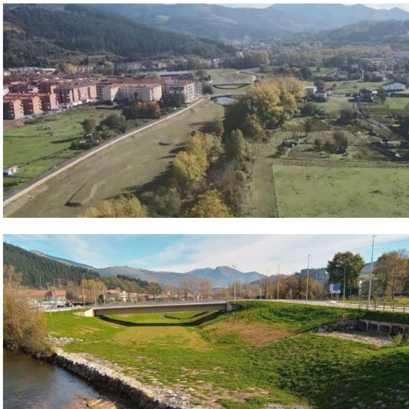
Figura 12. Actuaciones del «Proyecto de defensa contra inundaciones del río Cadagua a su paso por Mimetiz, en el municipio de Zalla (Bizkaia)». Arriba: berma lateral (primer plano) y corta de avenidas (al fondo). Abajo: detalle de la corta de avenidas y nuevo puente, vistos desde el cauce natural del río Cadagua.
