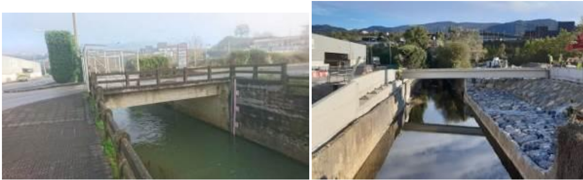
Figura 20. Comparación del puente de Trañapadura original (izquierda) y nuevo puente (derecha) tras las obras del proyecto «Puente en Trañapadura: acceso al polígono industrial desde la carretera N-634».
