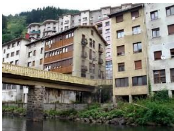
Figura 11. Ejemplo de edificios de Soraluze con plantas de edificación en zona inundable y plantas altas fuera de zona inundable. A efectos de cálculo de habitantes afectados por inundación, también han de considerarse los habitantes de las plantas altas, que también experimentan las consecuencias de las inundaciones.
