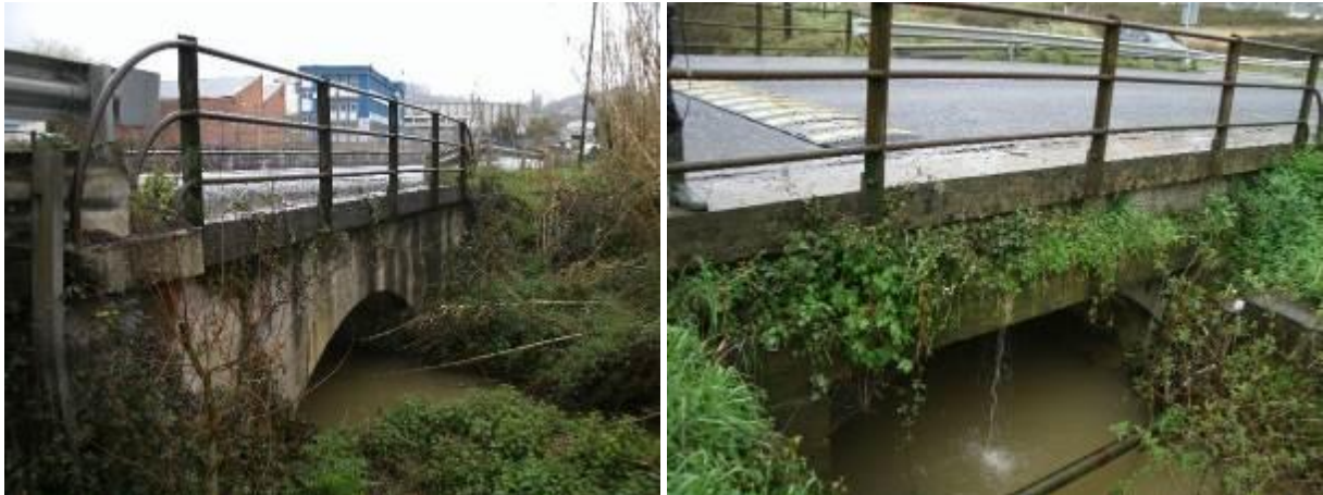
Figura 4. Puente de Bermeo bidea sobre el arroyo Totoriko, visto desde aguas arriba (izquierda) y aguas abajo (derecha).
