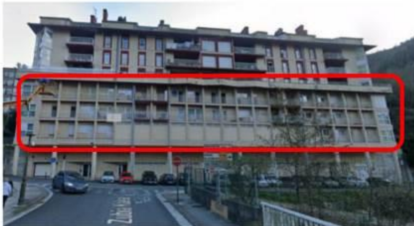
Viviendas emplazadas en sótanos de la Avenida de Gipuzkoa, a 25 metros del río
