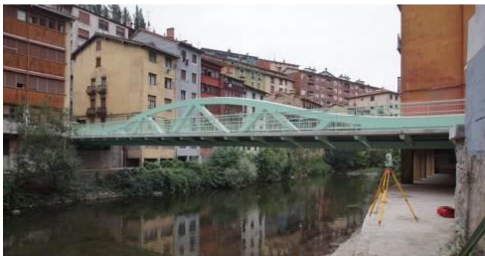
Figura 13. Comparación entre la pasarela Gabolats antes de las obras (arriba) y nuevo puente (abajo).
