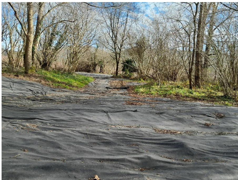
Ilustración 9. Instalación de malla antihierbas biodegradable sobre las zonas tratadas previamente.
