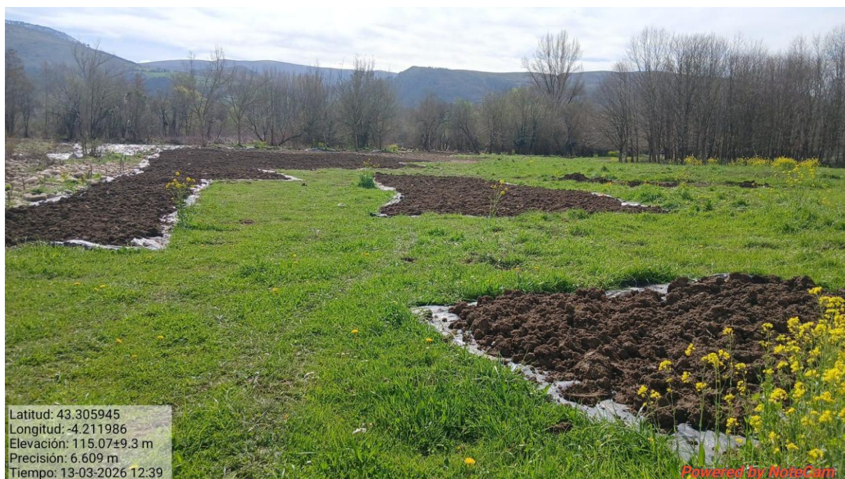
Ilustración 10. Extendido de tierra sobre las mallas biodegradables previamente instaladas, manteniendo un margen en el perímetro de la malla.
