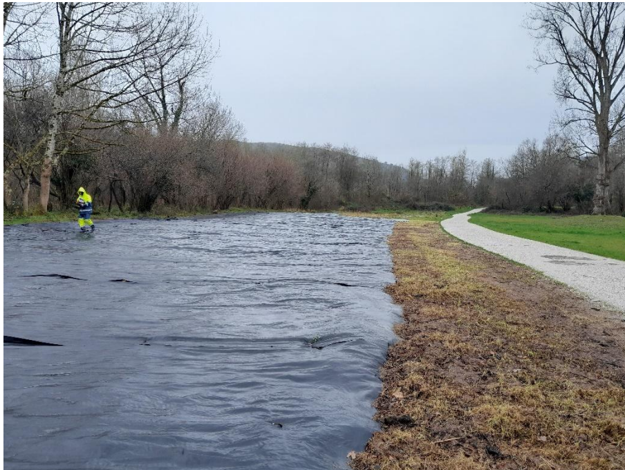
Ilustración 8. Instalación de malla antihierbas biodegradable sobre las zonas tratadas previamente.
