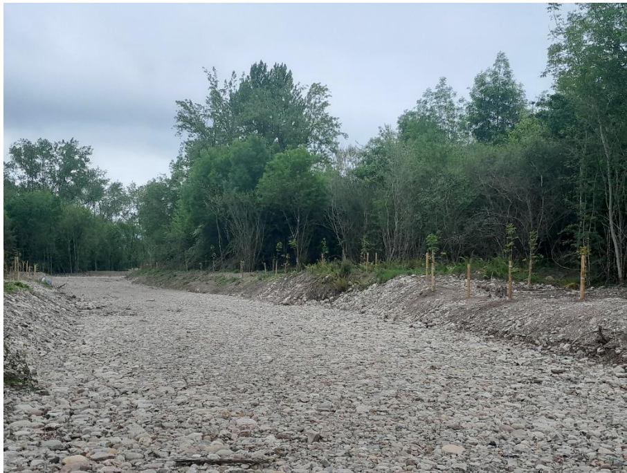
Foto 8. Estado final del canal en su tramo intermedio.
