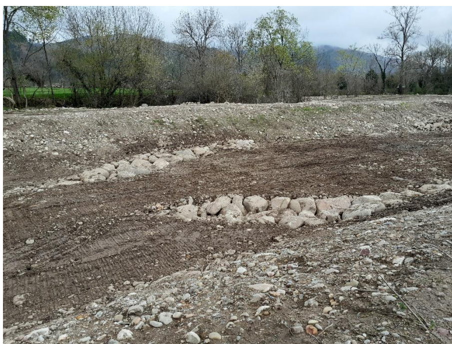
Foto 11. Travesas ejecutadas a lo largo del canal.
