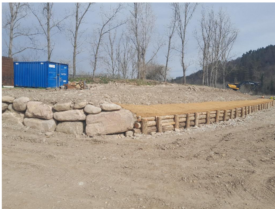
Foto 10. Escollera y empalizada del tramo intermedio del canal en la zona del badén.
