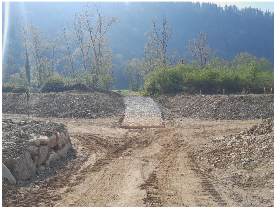
Foto 9. Ejecución del encachado del badén.
