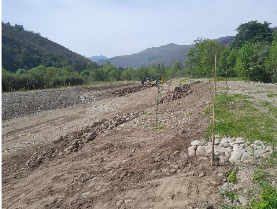
Foto 12. Reperfilado de los taludes del canal.
