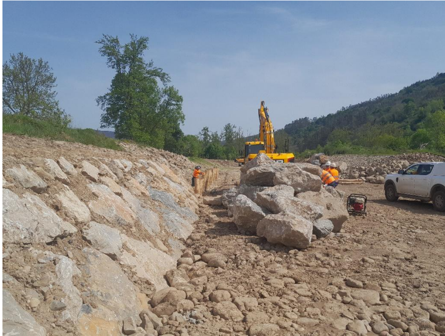
Foto 6. Ejecución de la escollera ubicada en el tramo inicial del canal.
