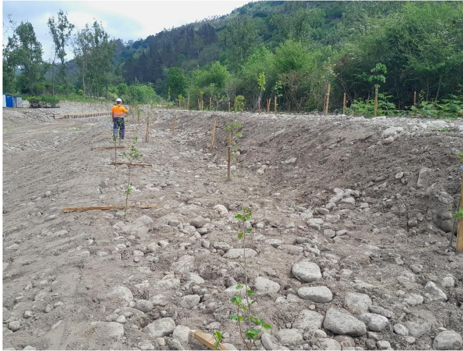
Foto 14. Realización de la revegetación y plantaciones.
