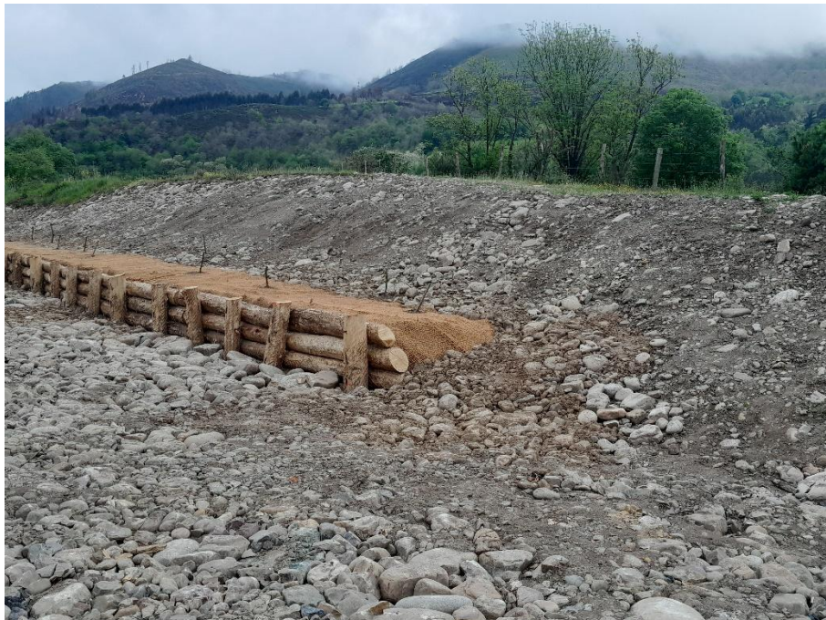
Foto 7. Empalizada de la parte inicial del canal.
