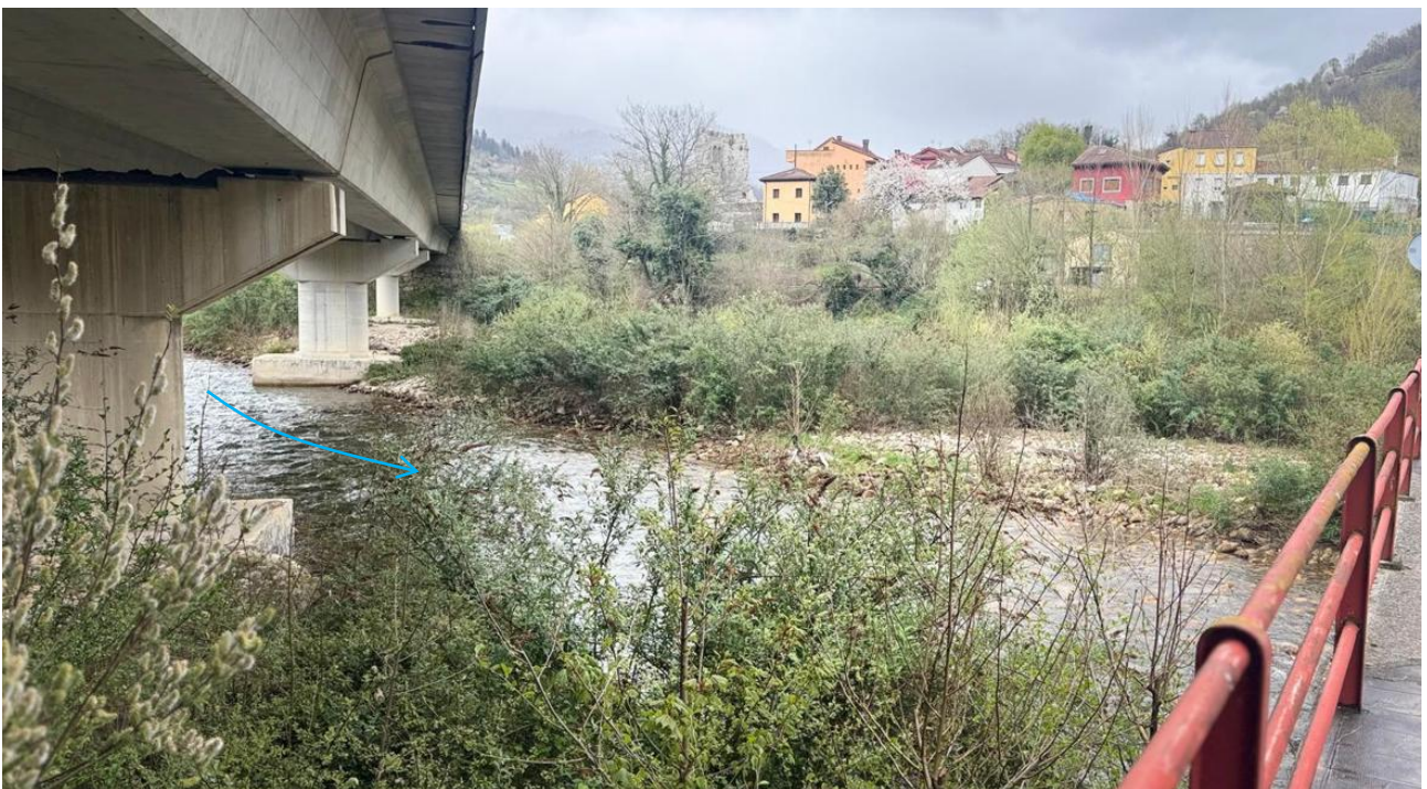
Fotografía nº 4.- Vista general del cauce del río Aller en la zona de actuación. Detalle de la vegetación que cubre las márgenes
