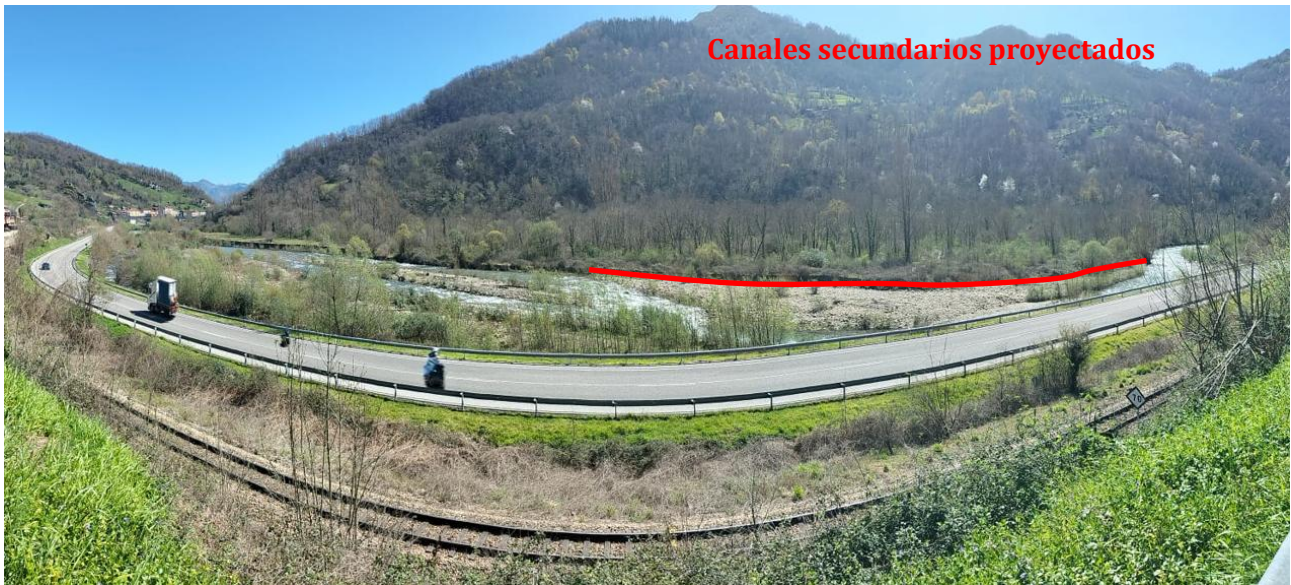
Fotografía nº 5.- Vista general de la zona de actuación
