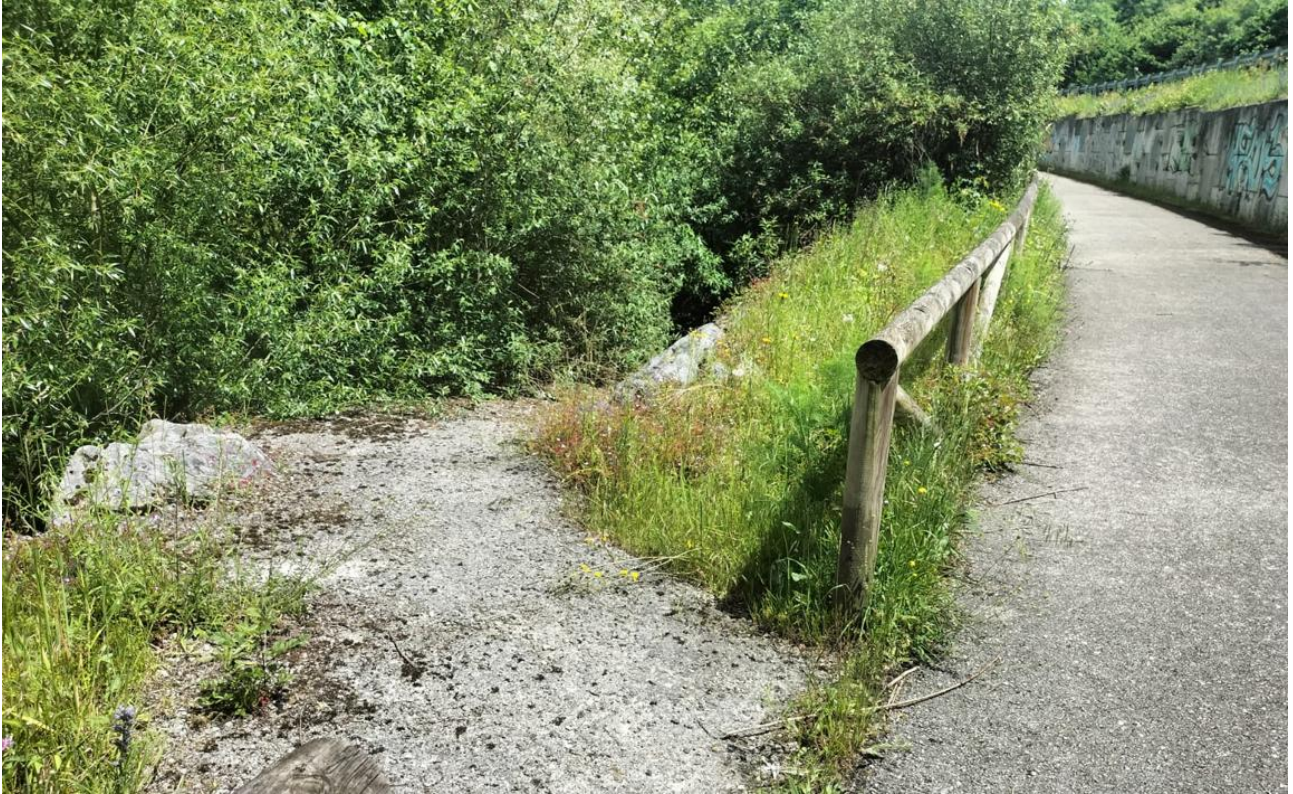
Fotografía nº 3.- Zona de acceso peatonal a la margen izquierda del río Aller desde la Senda Peatonal
