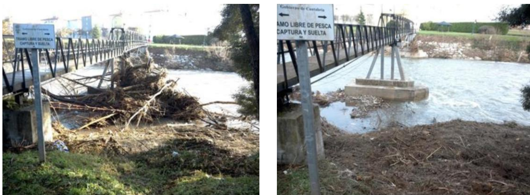
Figura 12.2. Recuperación de la sección hidráulica el Puente de Viesca (Cantabria, tras la avenida de enero de 2019). (Fuente: fondo documental de la CH Cantábrico).
