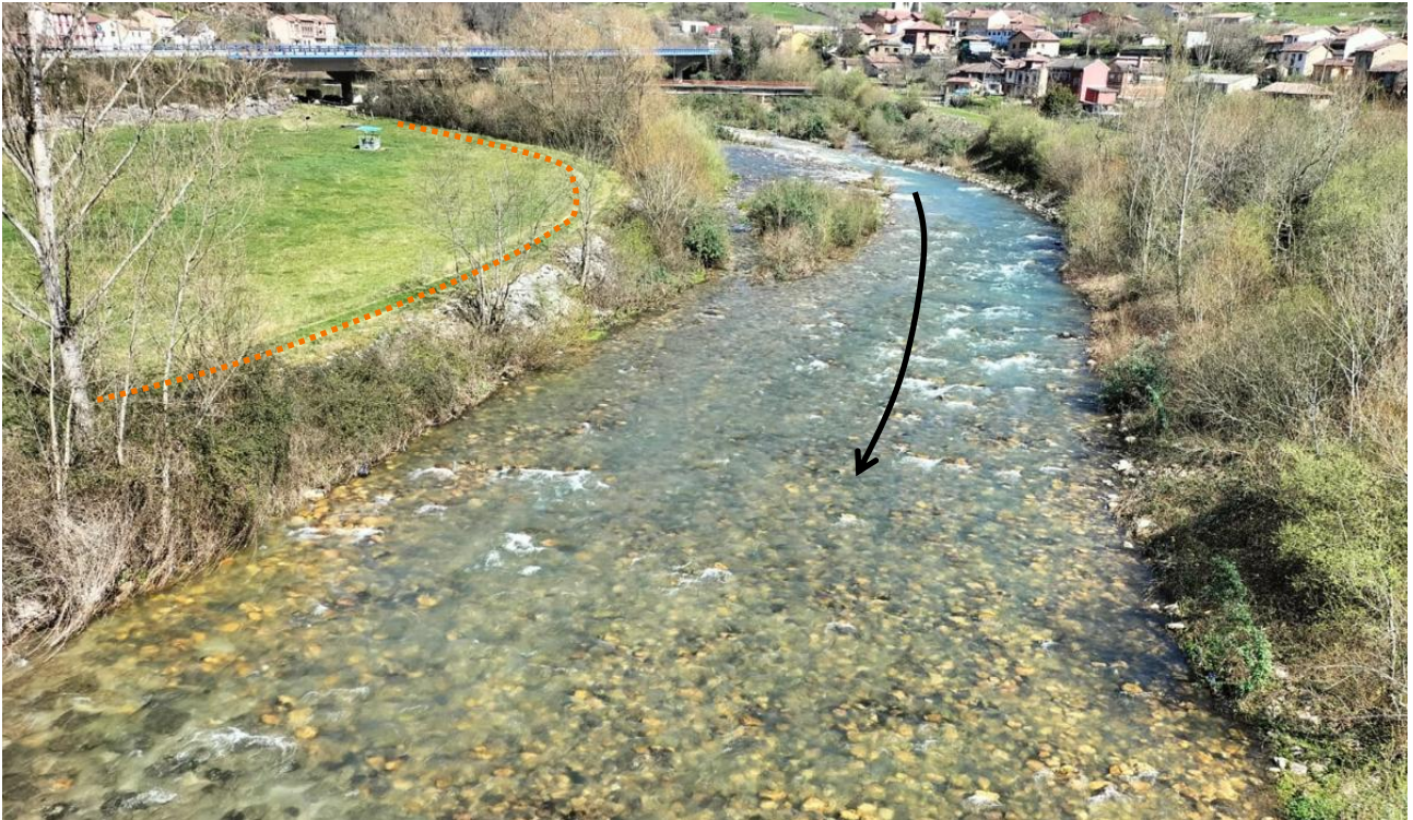
Fotografía nº 9- Detalle del estado del cauce aguas arriba de la zona de actuación. Vial existente por el que se trasladarán los áridos acumulados en la margen izquierda junto a la carretera
