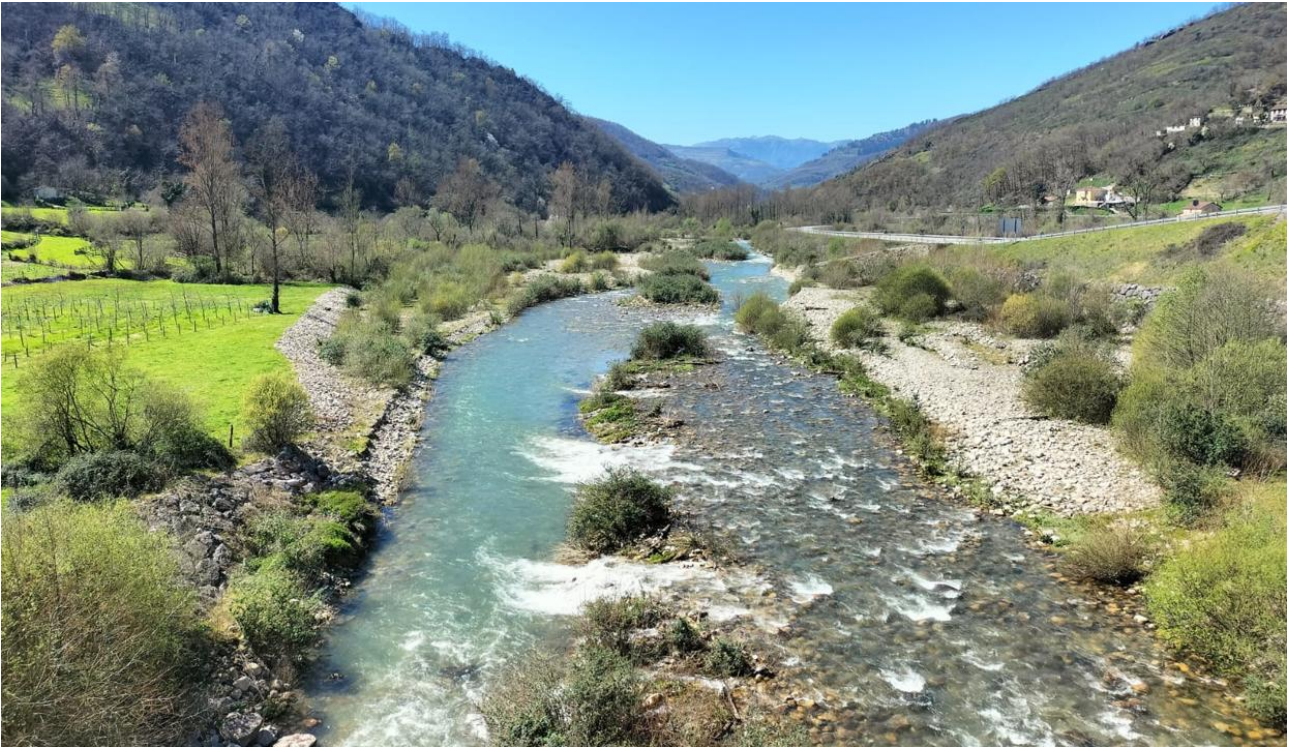
Fotografía nº 1.- Detalle del estado actual del río Aller en Soto de Aller
