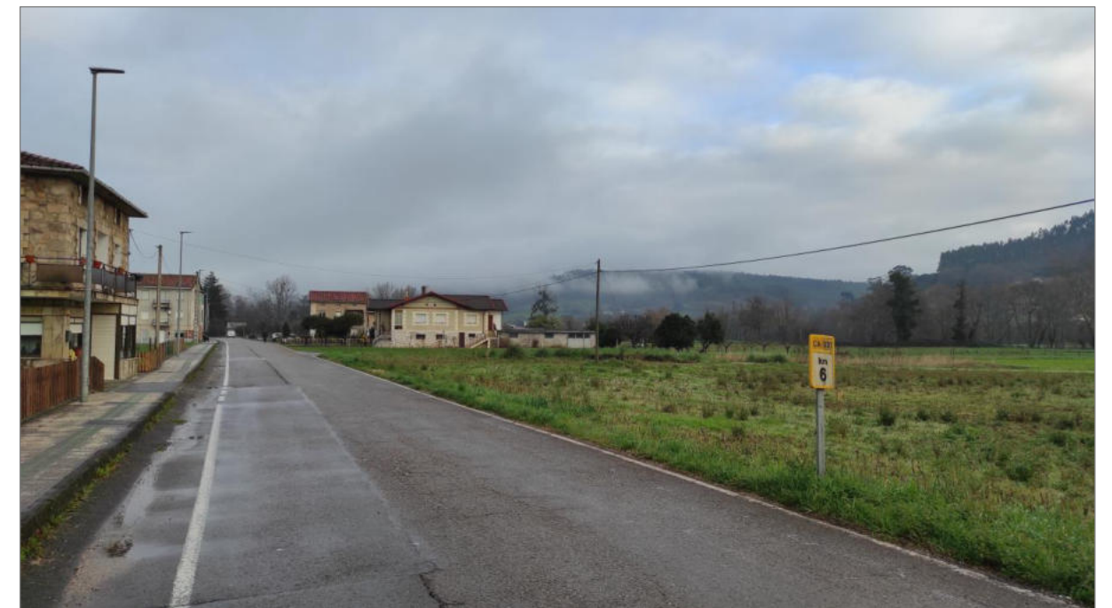
Fotografía 17. A la derecha de la carretera CA-321, vega de la margen izquierda del río Pas por la que discurrirá la nueva defensa de protección frente a inundaciones entre el puente de ferrocarril en Vioño y el barrio de Salcedo.
