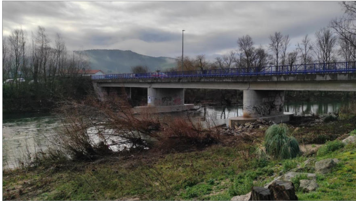
Fotografía 9. Puente sobre el río Pas en carretera CA-234 (vista desde aguas abajo).
