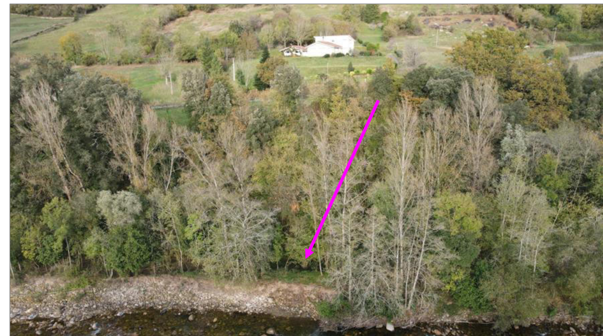
Fotografía 1. Detalle de la sobreelevación de la mota de la margen derecha respecto al cauce del río Pas y a la parcela contigua cartografiada como DPH (flecha magenta).
