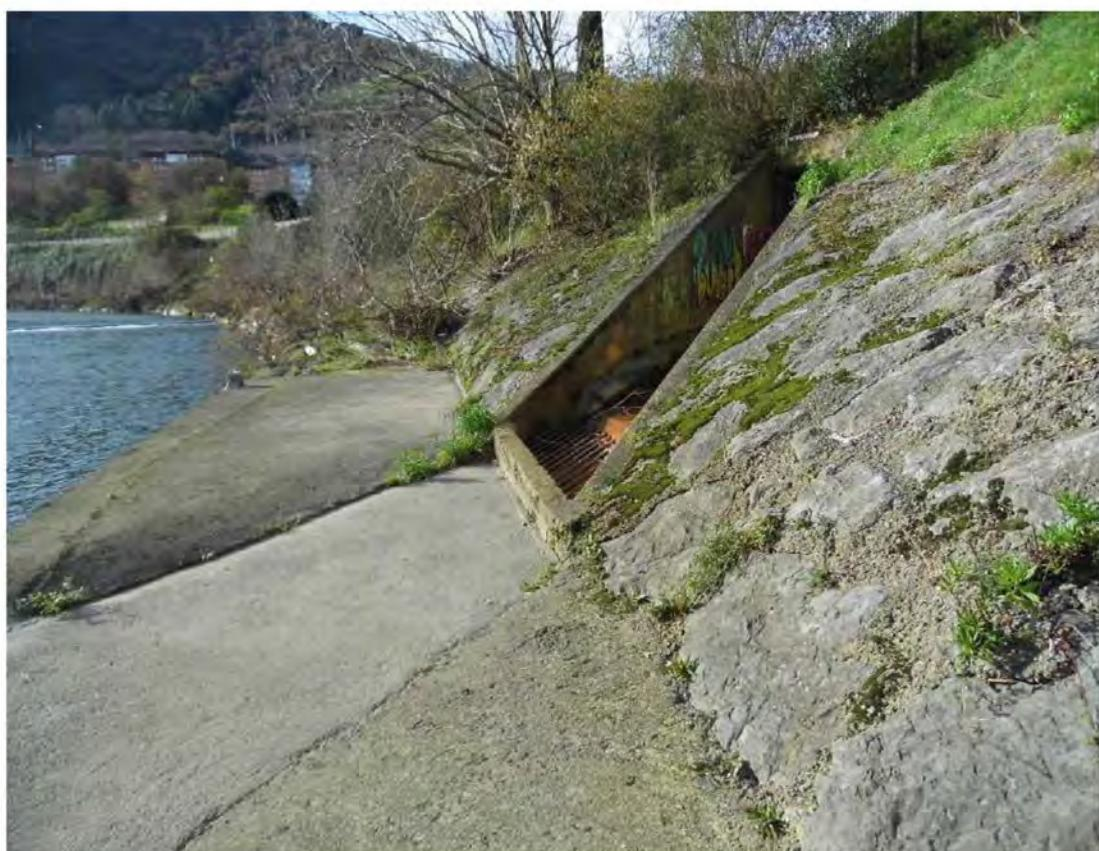
Fotografía nº 34. Margen izquierda. Salida de pluviales. Se propone demoler el hormigón y sustituirlo por alguna solución más natural. También demoler el hormigón que configura al orilla en estos metros finales.
