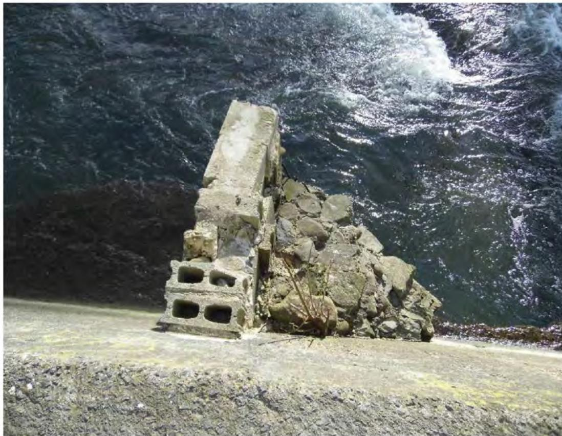
Fotografía nº 35. Estructuras ubicadas en las orillas que actúan como deflectores y son utilizadas por pescadores locales. Se propone retirar el añadido irregular superior.
