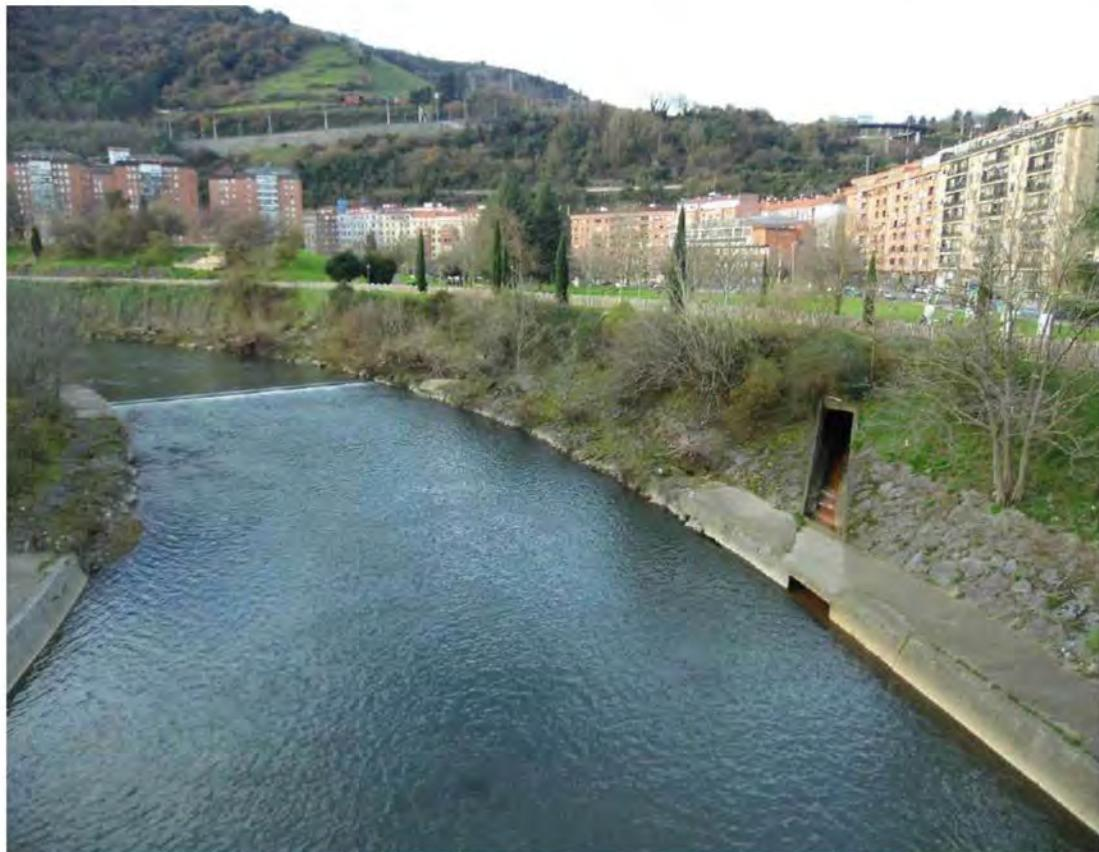
Fotografía nº 47. Vista desde pasarela peatonal hacia aguas arriba. Orilla con estructura de hormigón y salida de pluviales en margen izquierda.
