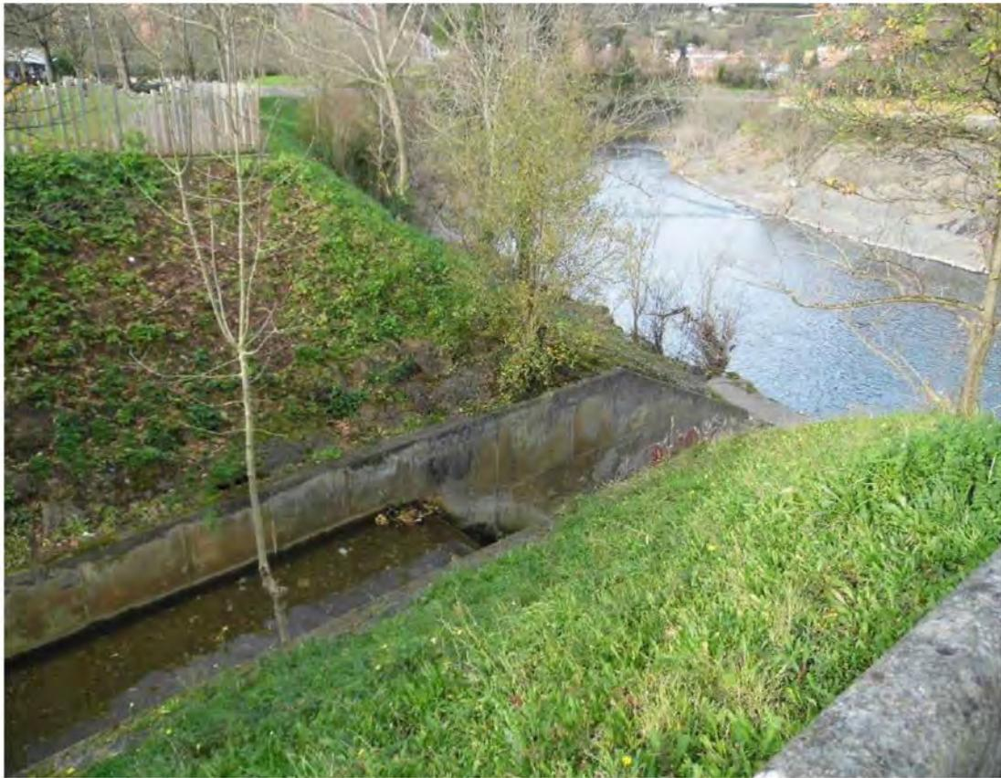
Fotografía nº 15. Margen izquierda. Confluencia del arroyo Bolintxu con el Nervión. Estructuras de obra que se propone demoler.
