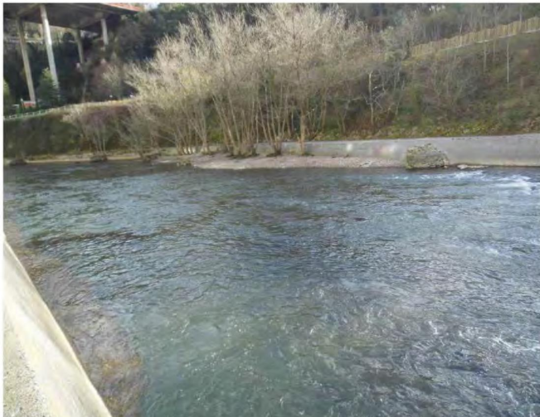
Fotografía nº 36. Estructura-deflector que ha generado pequeña playa de sedimentos en la que se ha asentado vegetación espontánea. Margen derecha.
