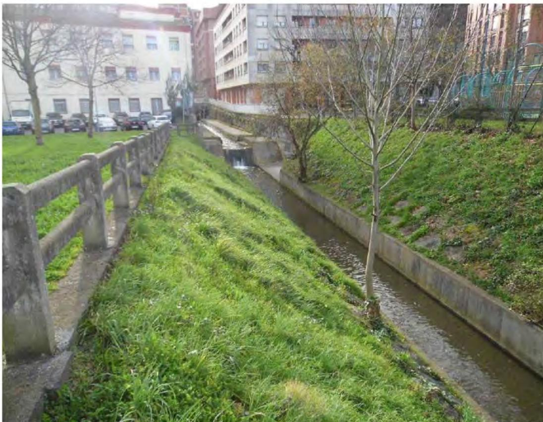
Fotografía nº 16. Margen izquierda. Confluencia del arroyo Bolintxu con el Nervión. Estructuras de obra que se propone demoler.
