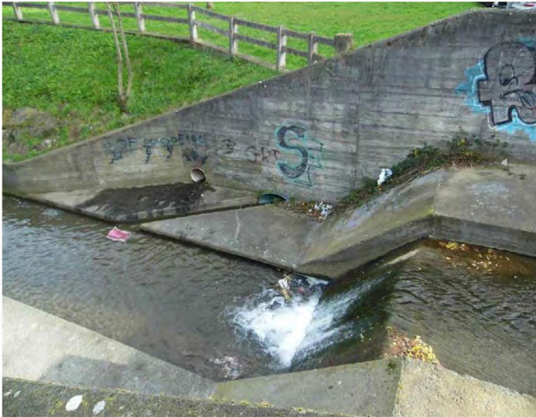
Fotografía nº 21. Margen izquierda. Confluencia del arroyo Bolintx con el Nervión. Estructuras de obra que se propone demoler.
