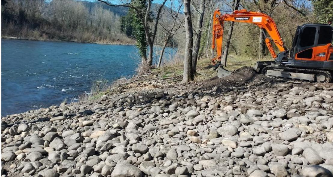
Figura 61. Trabajos de reubicación de sedimento en el emplazamiento de Valduno.
