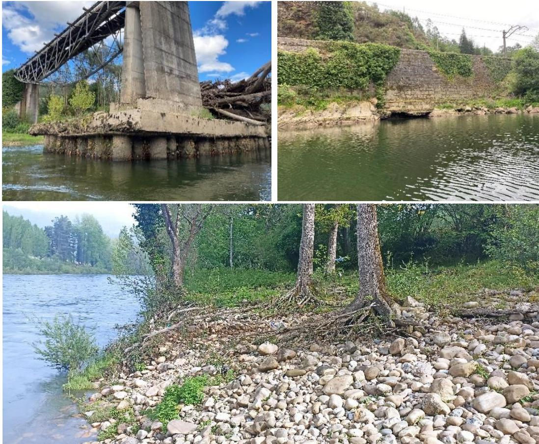
Figura 15. Ejemplos de procesos de encajamiento e incisión del cauce en el área de estudio: a) en el pilar del puente de San Román (arriba izquierda), b) socavación en la base del muro del ferrocarril en el entorno de la localidad de Peñaflores (arriba derecha) y c) árboles con las raíces descubiertas cerca del embalse de Valduno II (abajo).
