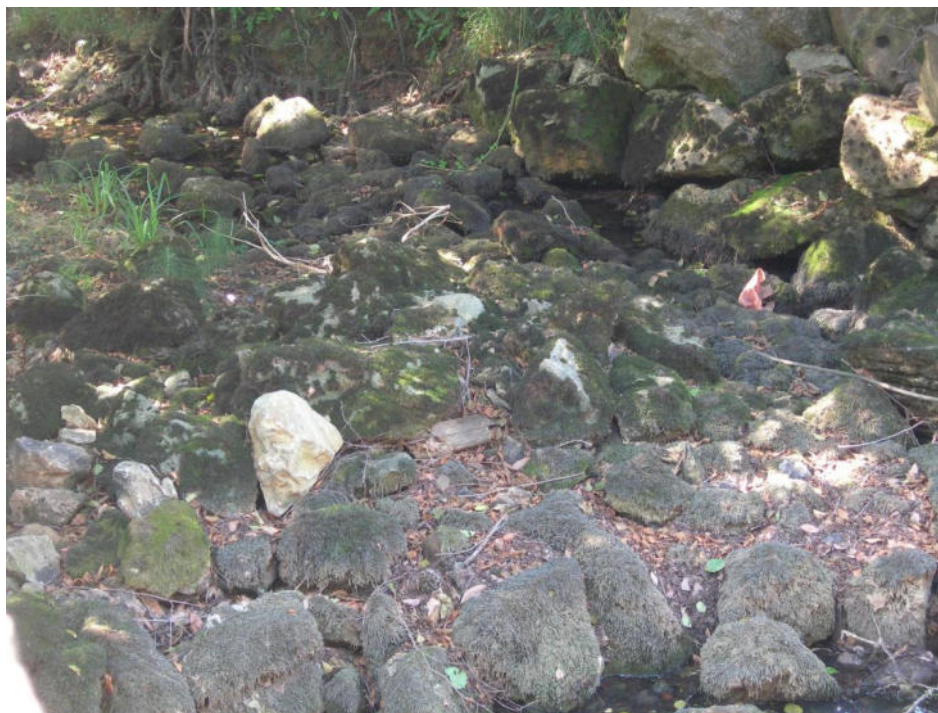
Figura 8. Regata Olalde afectada por el bombeo del pozo Olalde-B.
