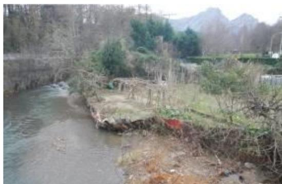
Foto 6. Margen izquierda aguas arriba del puente con evidencias de erosión.
