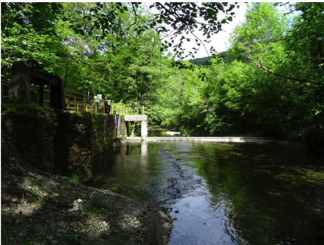
Azud para captación sin escala de peces
