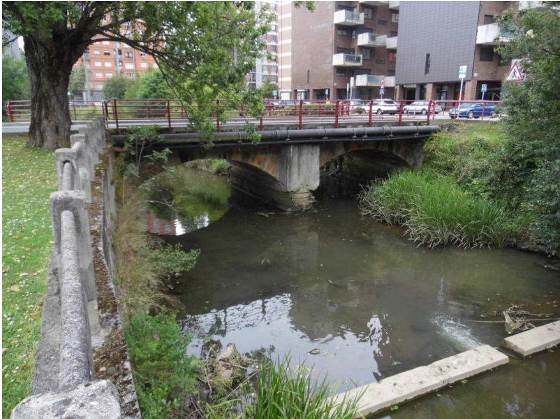
Fotografía nº 2.11. Aguas arriba del cruce con la carretera N-634. Dique transversal a la corriente.
