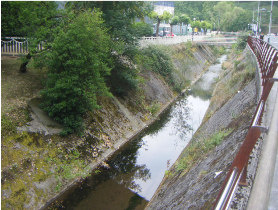
Situación actual del río Castaños en Gordaliza. Tramo encauzado en hormigón.
