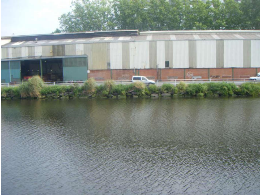
Situación actual del río Castaños en tramo final.
