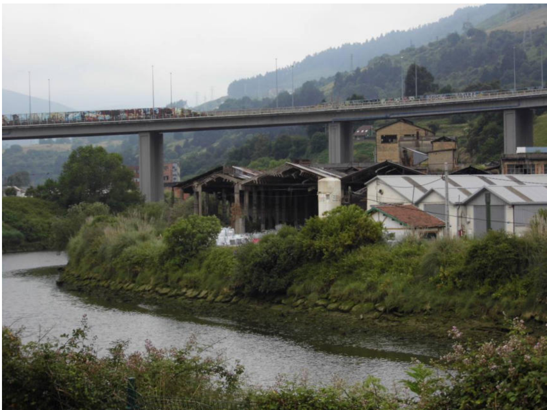
Fotografía nº 5.12. Río Cadagua aguas arriba del puente de la carretera N-634. En la margen izquierda, sector Calero. Al fondo, viaducto de la autovía E-70.
