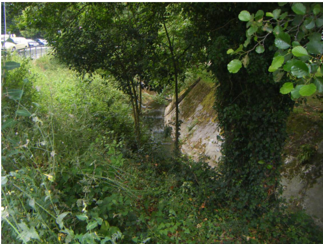
Fotografía nº 4.9. Tramo encajado en estructura de hormigón a la altura del polideportivo Gorostiza.
