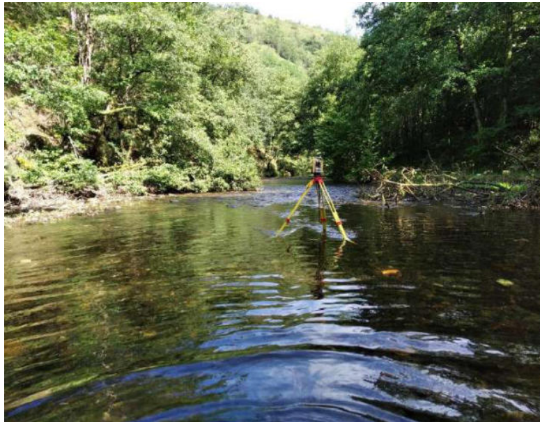
Figura 37. Trabajos de topografía en zona superior del tramo.
