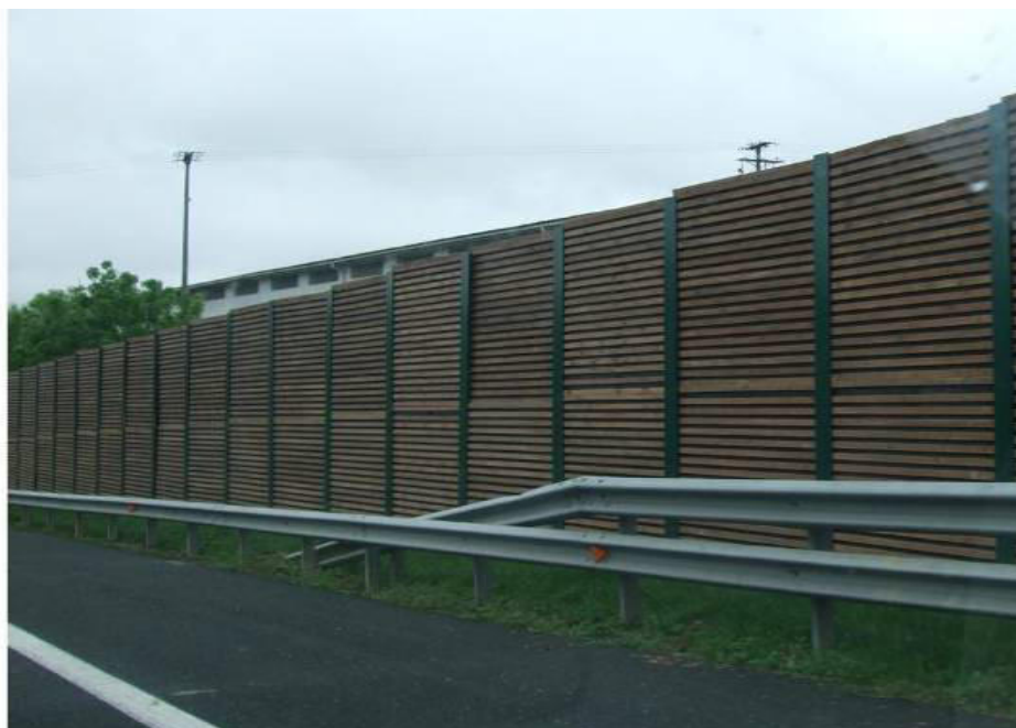
Gráfico 28. Pantalla acústica de madera. A-8, pk. 81
