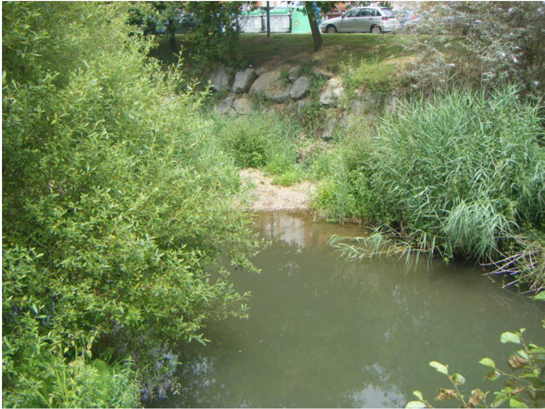
Fotografía nº 2.15. Aguas arriba del cruce con la carretera N-634. Defensa de escollera.
