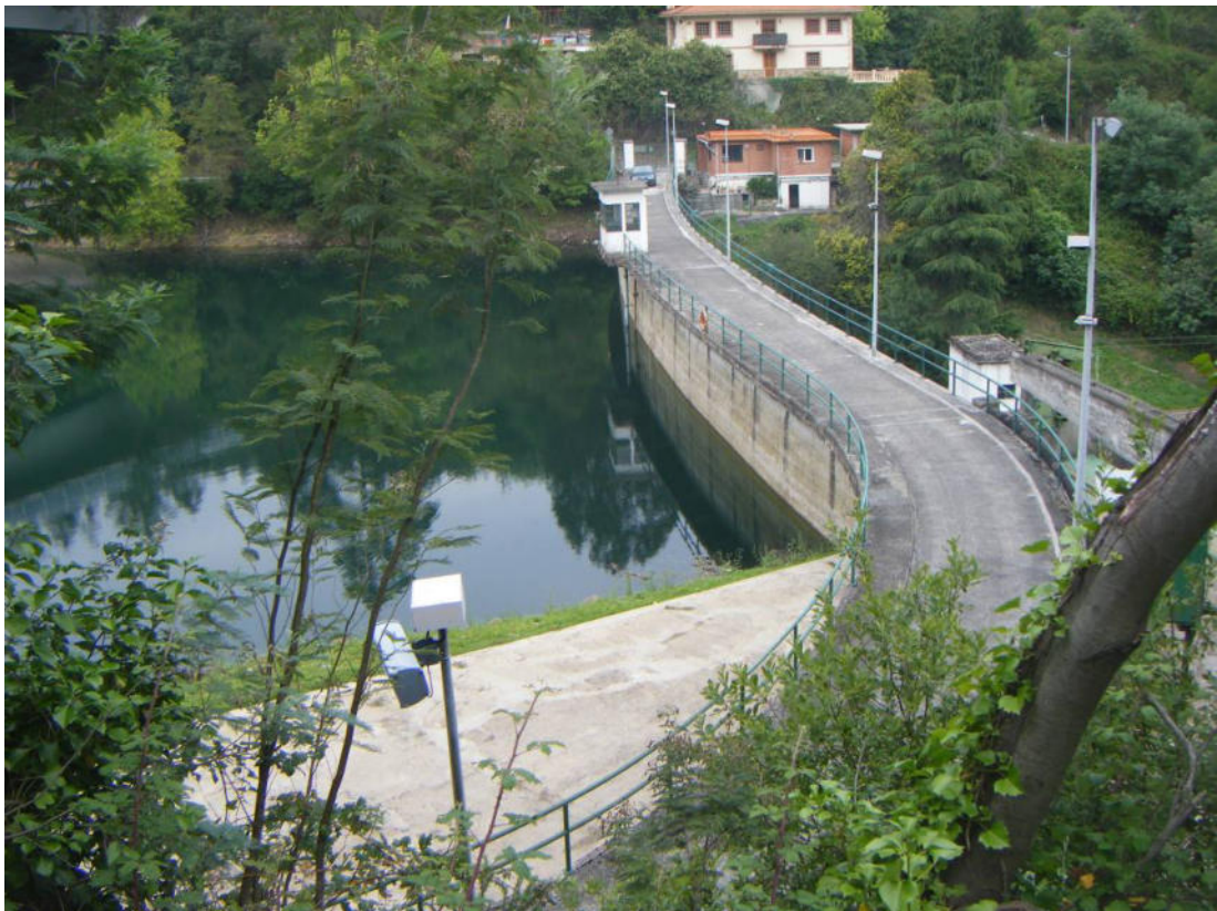
Fotografía nº 4.20. Presa de Gorostiza.
