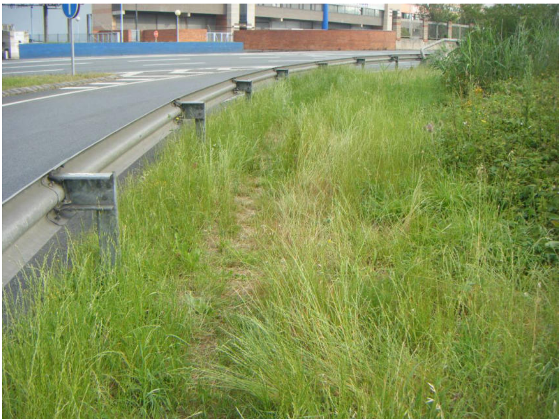
Fotografía nº 1.20. Borde del espacio de ribera y carril de incorporación a la carretera BI-644.
