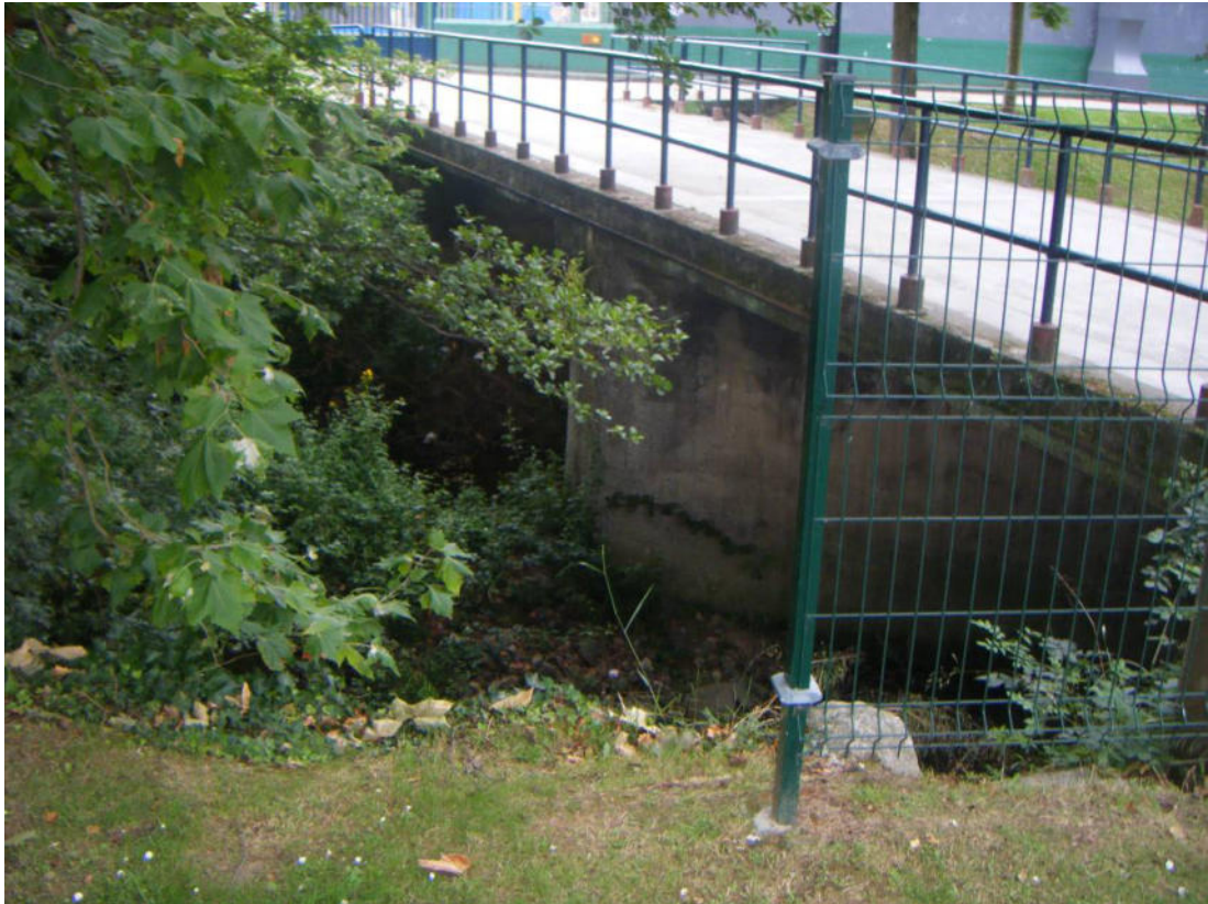
Fotografía nº 4.1. Pasarela sobre el Castaños a la altura del polideportivo Gorostiza.
