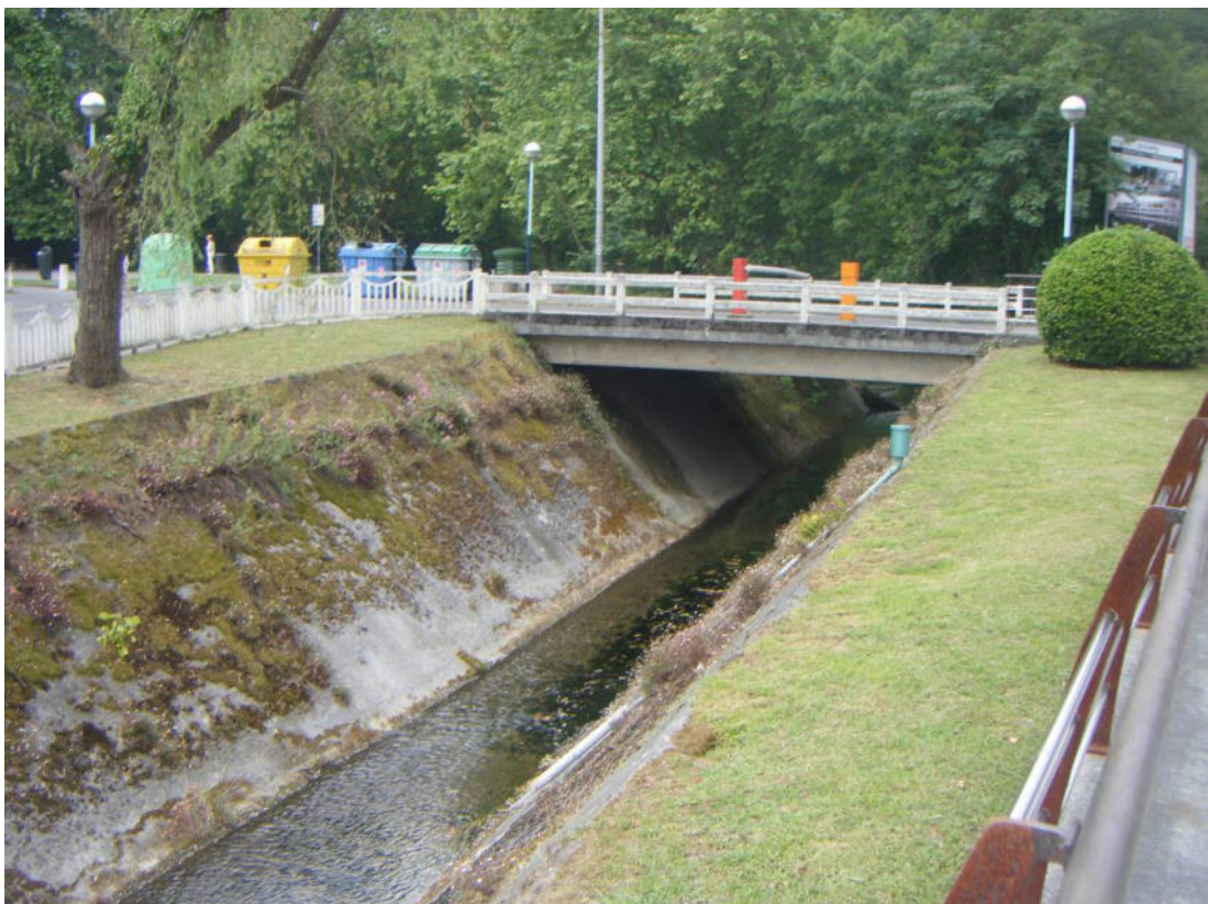
Fotografía nº 4.8. Tramo encajado en estructura de hormigón a la altura del polideportivo Gorostiza.
