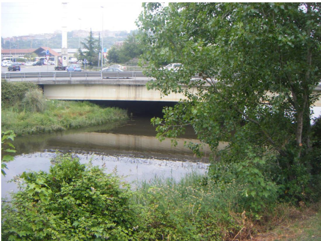
Fotografía nº 1.26. Ribera del Castaños. Puente de la carretera BI-745.
