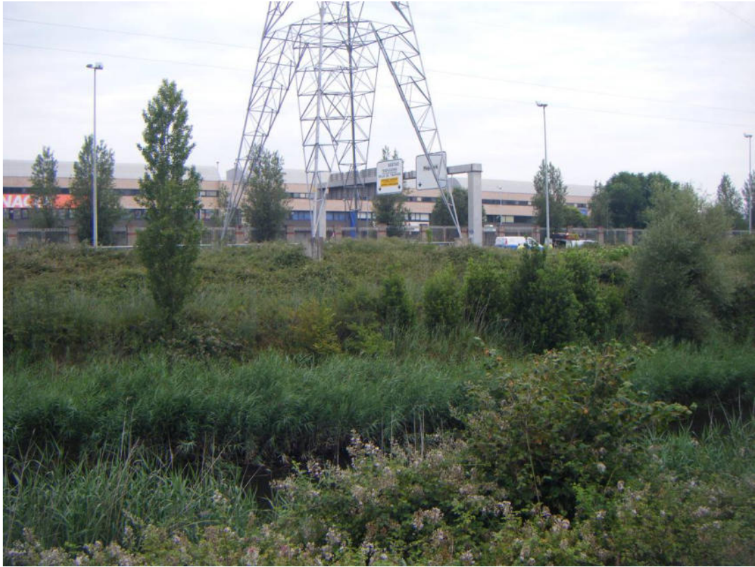
Fotografía nº 3.1. Ribera del Castaños. Apoyo de tendido eléctrico en margen izquierda.
