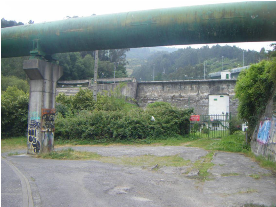
Fotografía nº 4.19. Presa de Gorostiza.
