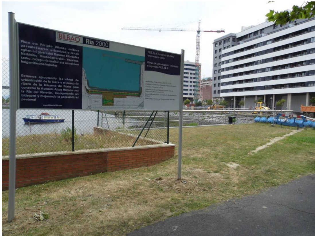
Fotografía nº 6.3. Margen izquierda de la Ría del Nervión. Cartel informativo de las actuales obras.
