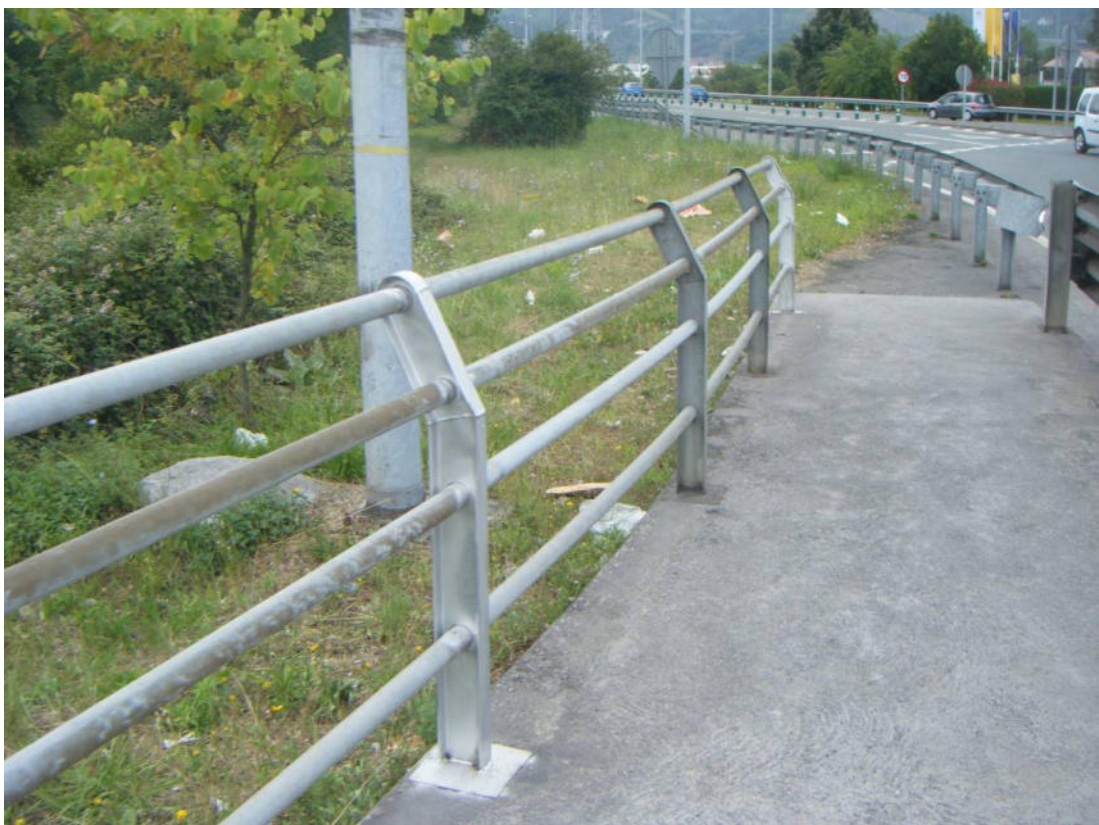
Fotografía nº 1.22. Puente de la carretera BI-745. Residuos.
