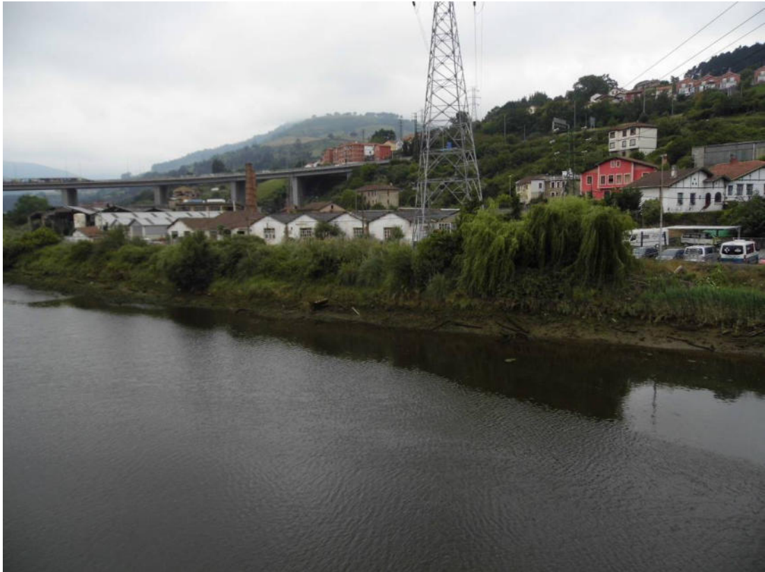
Fotografía nº 5.11. Río Cadagua aguas arriba del puente de la carretera N-634. En la margen izquierda, sector Calero. Al fondo, viaducto de la autovía E-70.
