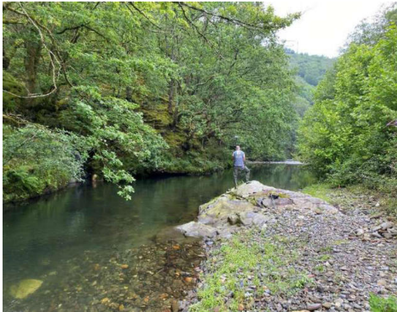
Figura 31. Trabajos de topografía (toma de punto de georreferenciación) en zona superior del tramo, con presencia de aguas profundas.
