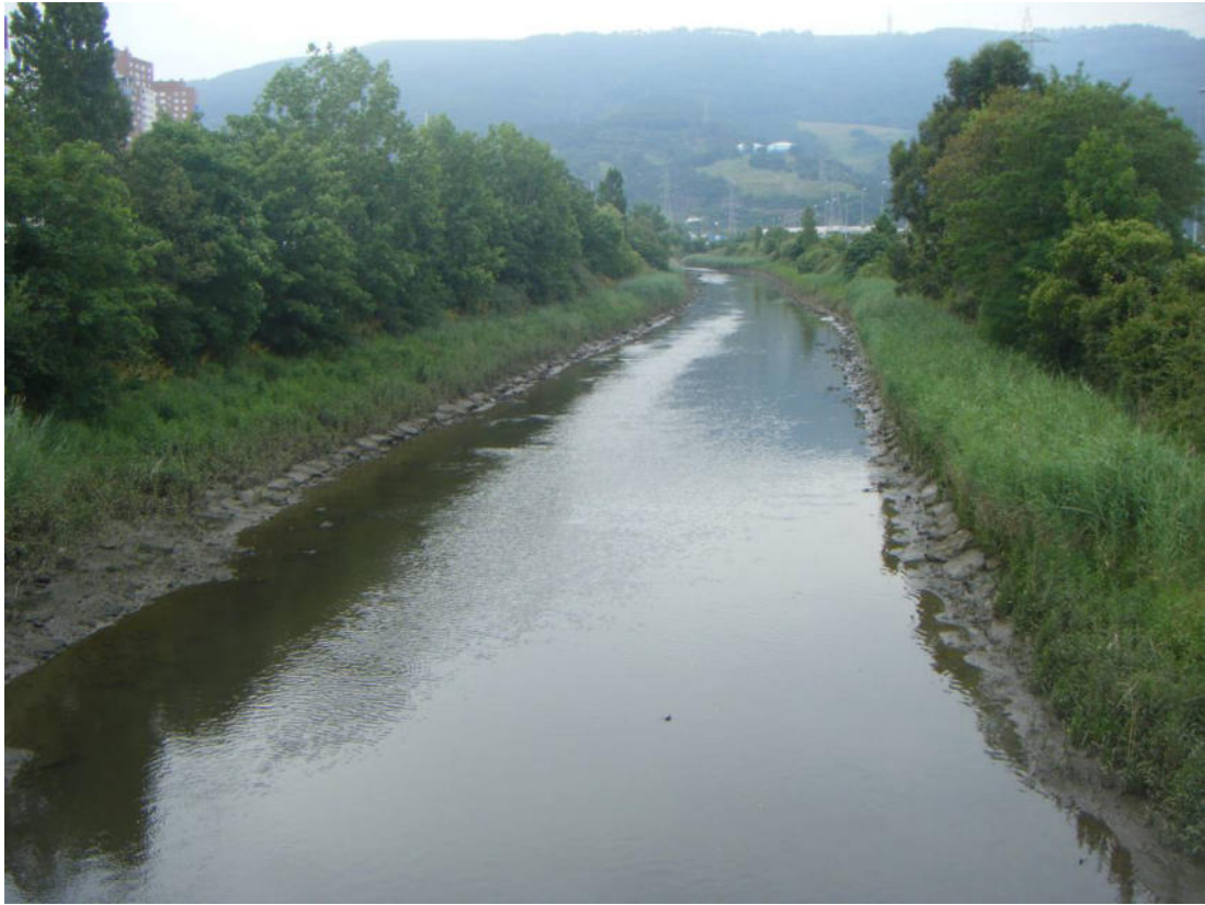
Fotografía nº 1.27. Ribera del Castaños. Desde el puente de la carretera BI-745, hacia aguas arriba.
