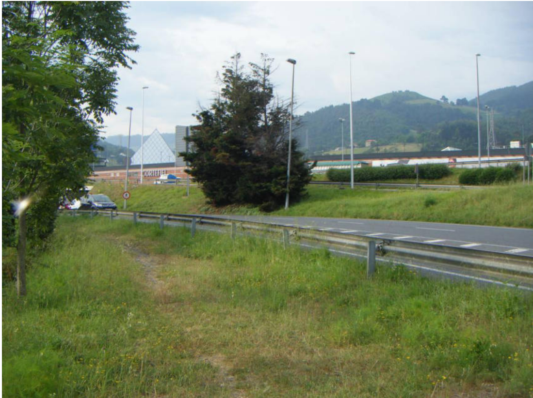
Fotografía nº 1.19. Borde del espacio de ribera y carril de incorporación a la carretera BI-644.
