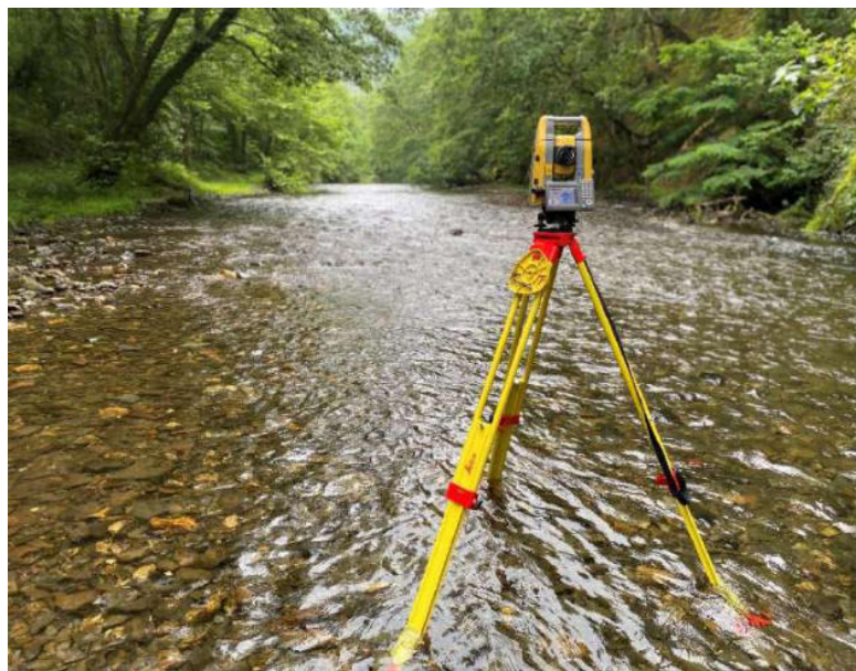
Figura 38. Trabajos de topografía en zona de tablas.
