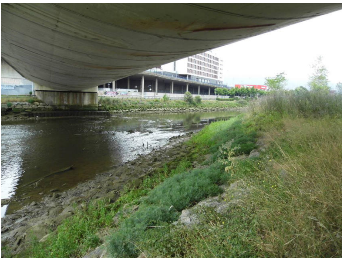
Fotografía nº 3.26. Cruce del río Castaños con vía de ferrocarril.
