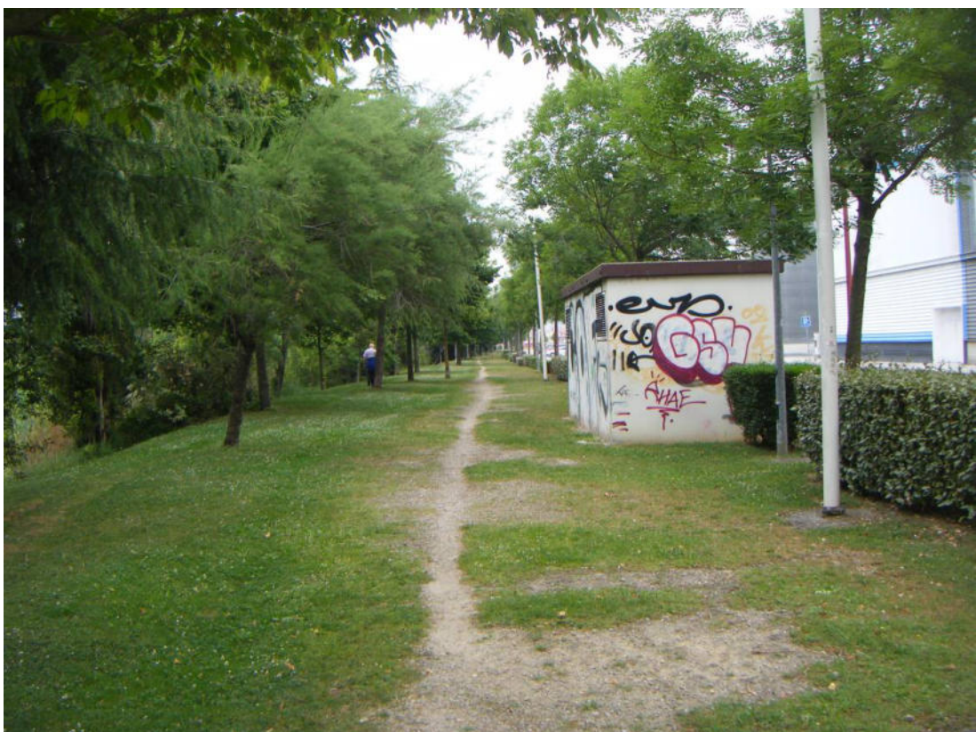
Fotografía nº 1.8. Banda ajardinada. Postes y centro de transformación.
