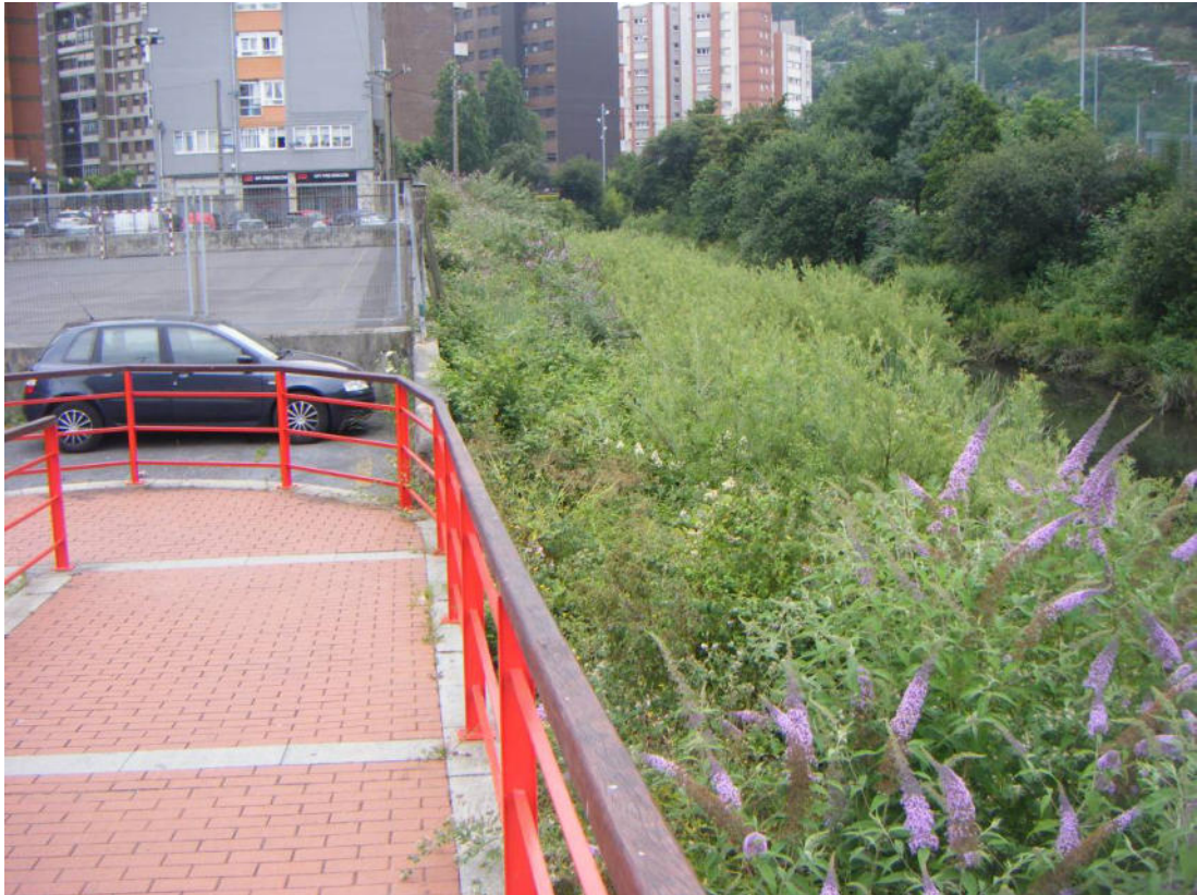
Fotografía nº 2.5. Muro y construcciones en margen derecha. Acceso a pasarela peatonal. Buddleia ( Buddleja davidii ) entre vegetación de ribera.
