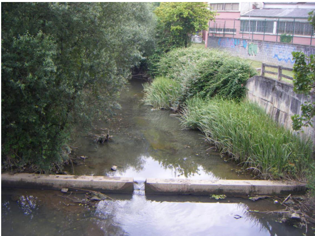
Fotografía nº 2.10. Aguas arriba del cruce con la carretera N-634. Muro y construcciones en margen izquierda. Dique transversal a la corriente.
