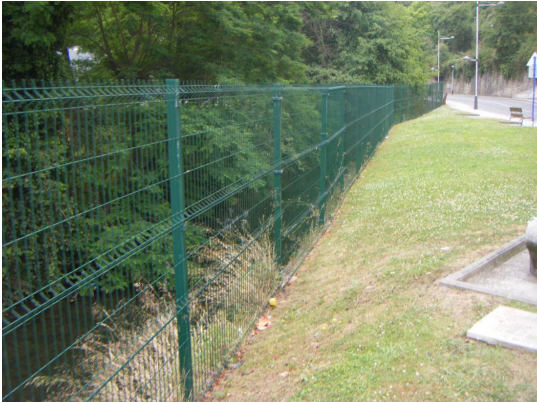
Fotografía nº 4.3. Muro y ribera a la altura del polideportivo Gorostiza. Carretera BI-4743.
