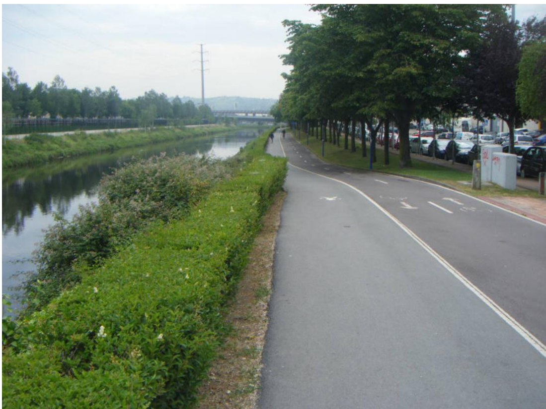
Fotografía nº 3.16. Río Castaños. Camino peatonal y carril bici en margen derecha. Seto-jardín. En la margen izquierda, EDAR de Galindo.
