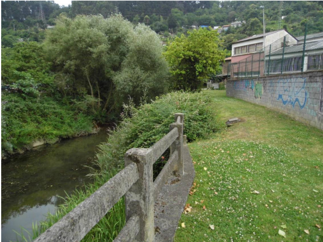
Fotografía nº 2.17. Aguas arriba del cruce con la carretera N-634. Muro y construcciones en margen izquierda.
