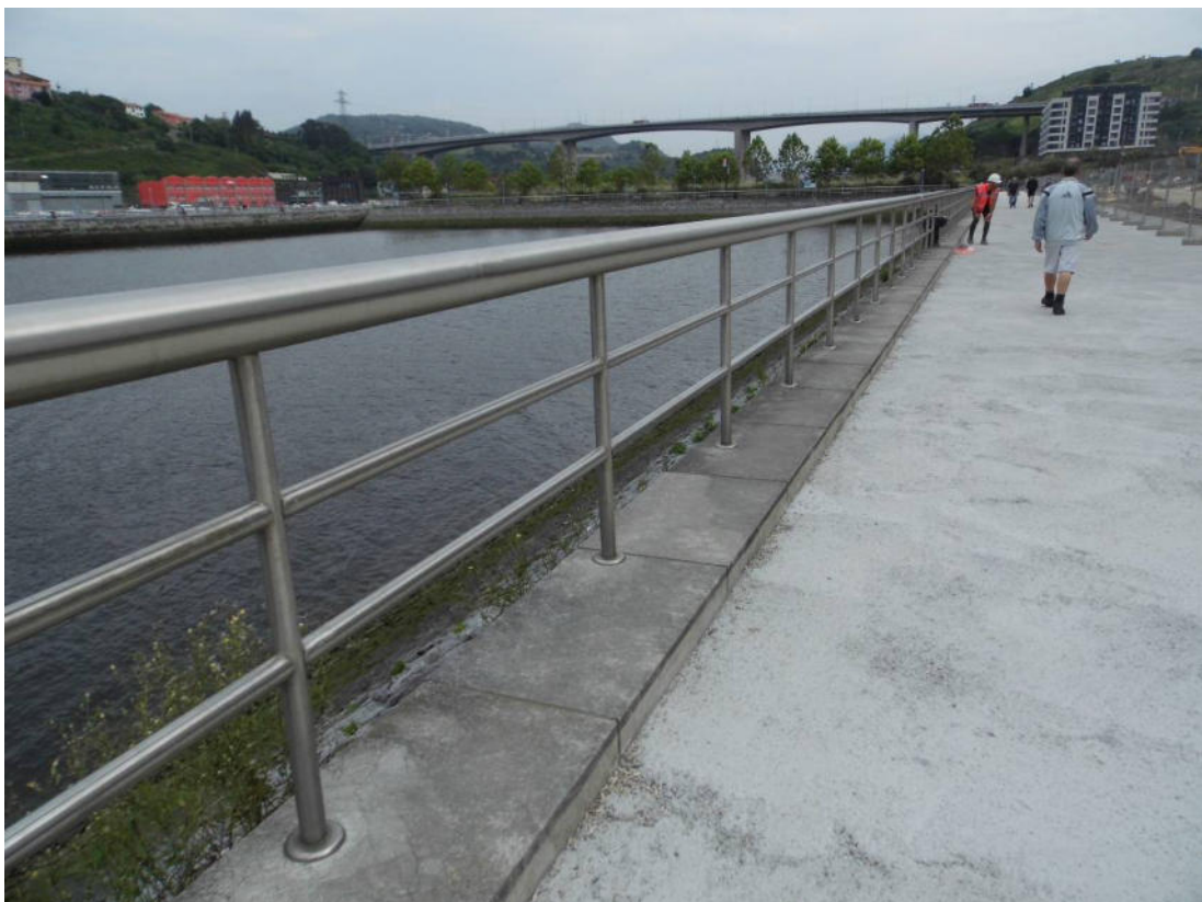
Fotografía nº 6.4. Margen izquierda de la Ría del Nervión. Obras de urbanización.
