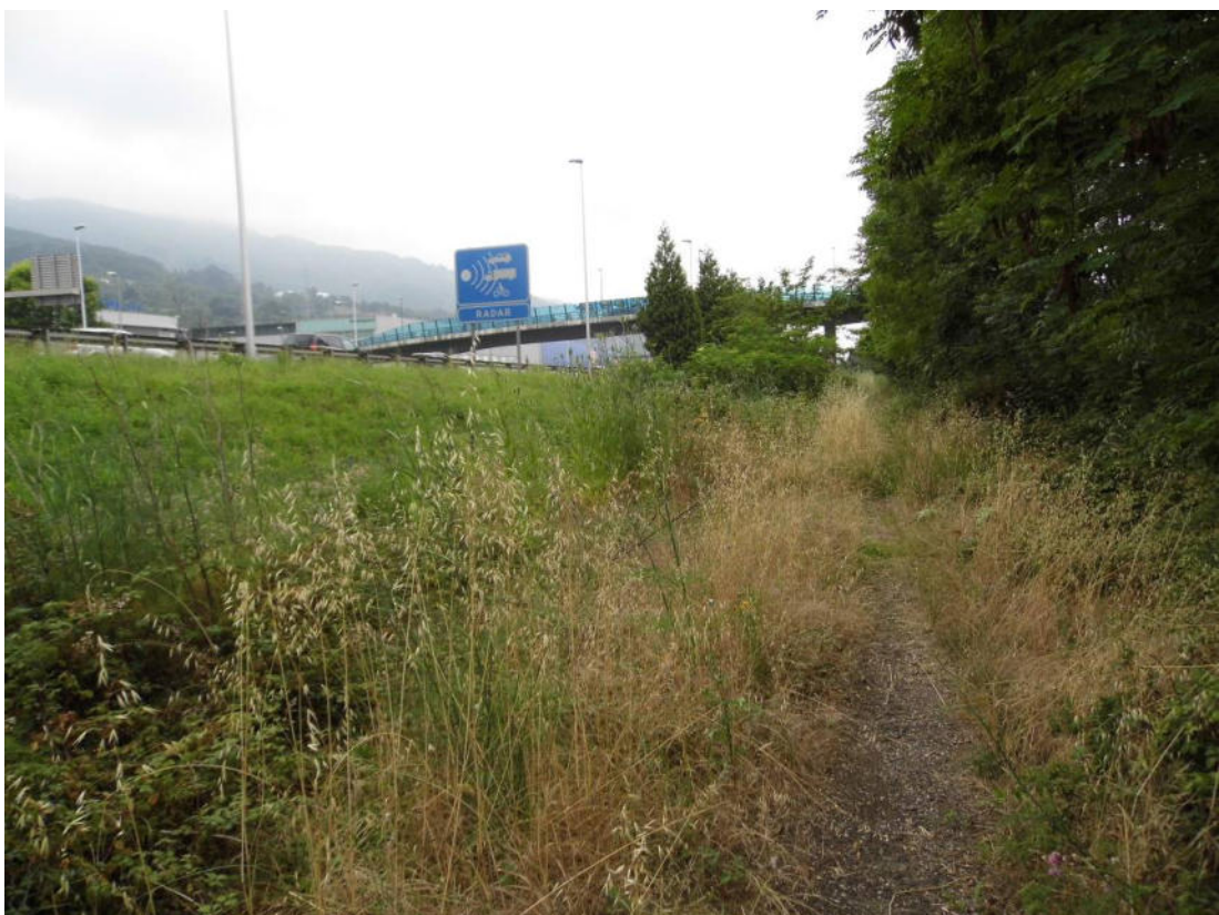
Fotografía nº 1.14. Margen izquierda del río Castaños. Autovía A-8.
