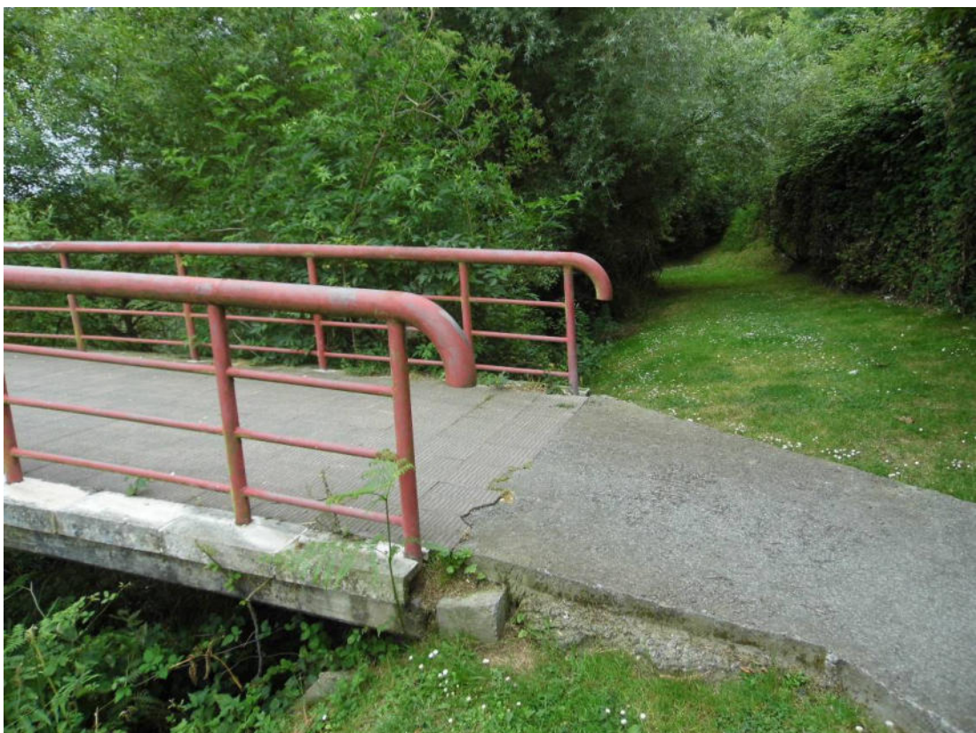
Fotografía nº 2.18. Aguas arriba del cruce con la carretera N-634. Pasarela peatonal.
