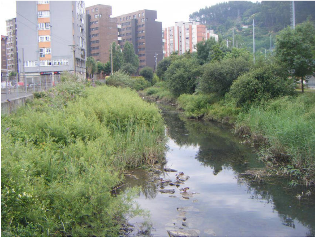
Fotografía nº 2.7. Muro y construcciones en margen derecha.
