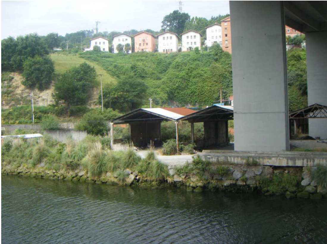
Fotografía nº 5.3. Construcciones del sector Calero, en la margen izquierda del río Cadagua.
