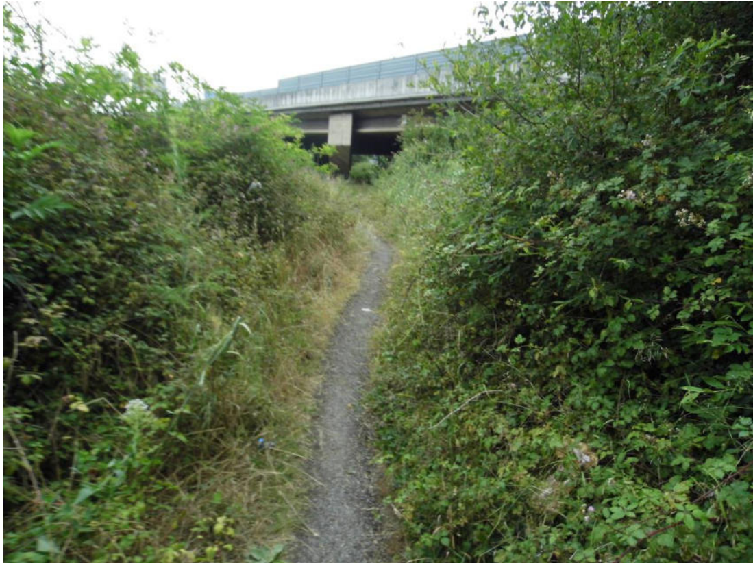
Fotografía nº 2.3. Sendero por la margen izquierda. Cruce con la Autovía A-8.
