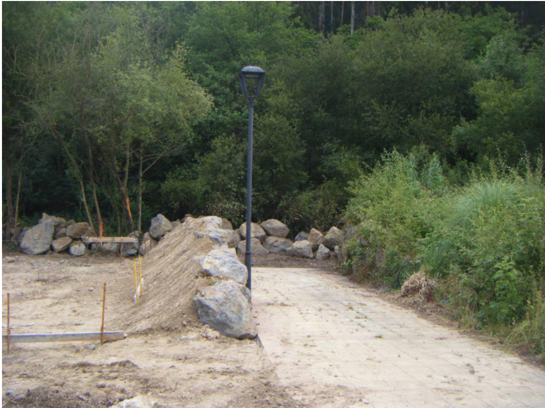
Fotografía nº 4.11. Obras en la ribera en la Urbanizacion Iguliz-Gorostiza.
