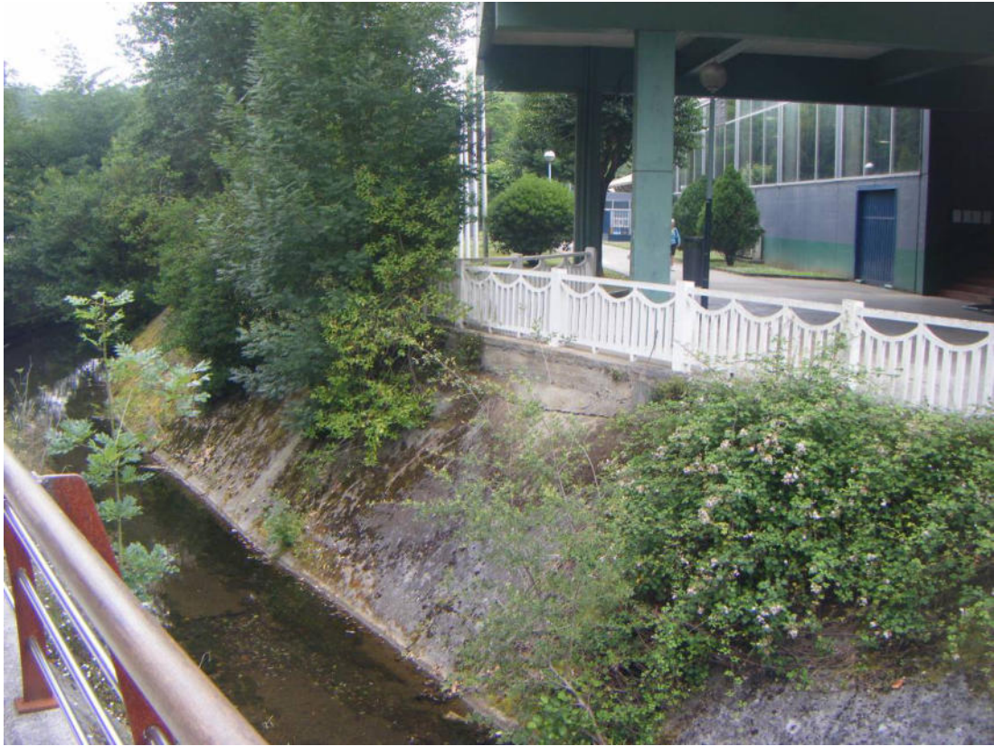
Fotografía nº 4.7. Tramo encajado en estructura de hormigón a la altura del polideportivo Gorostiza.
