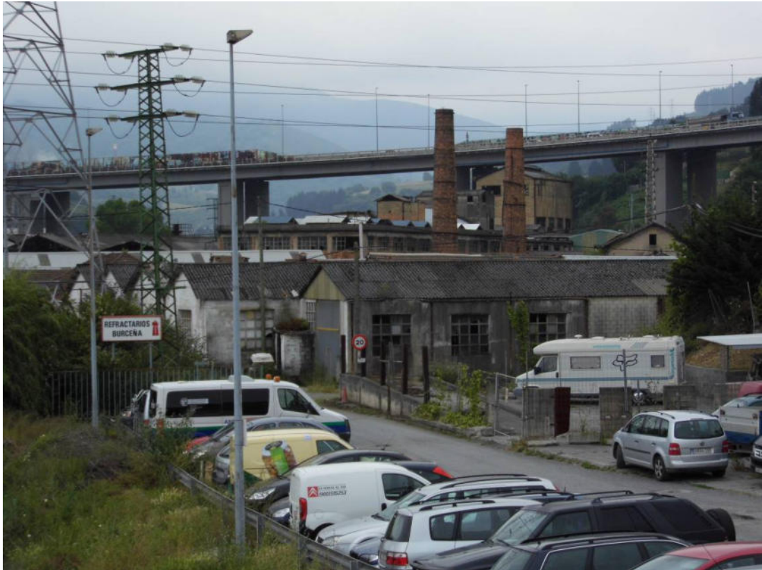
Fotografía nº 5.9. Construcciones del sector Calero, en la margen izquierda del río Cadagua.
