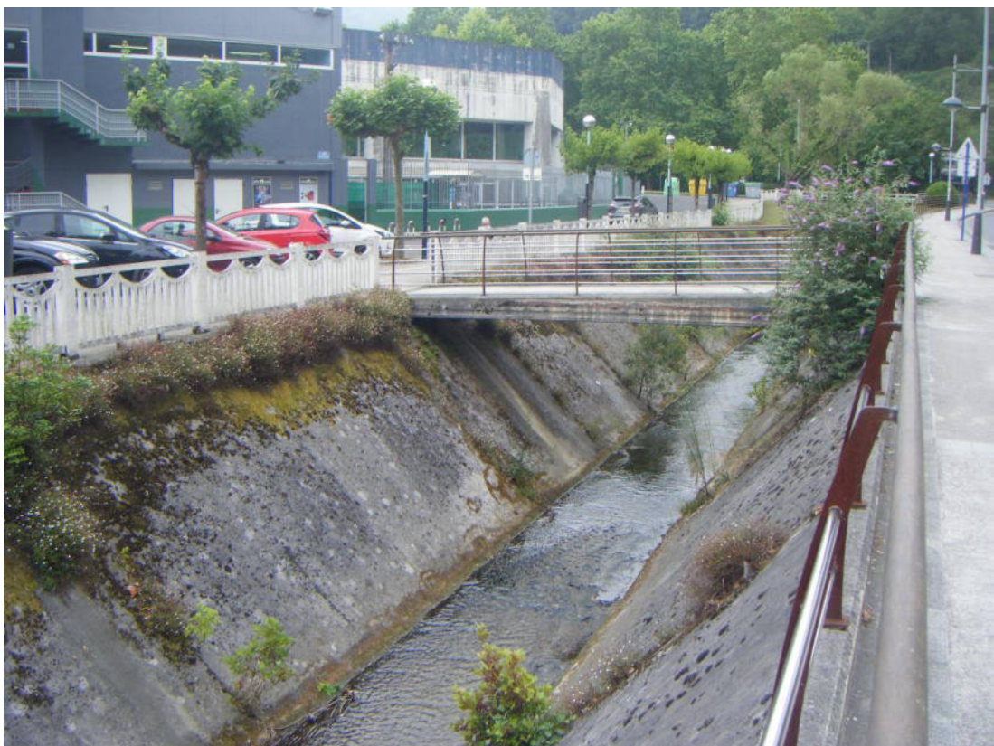
Fotografía nº 4.6. Tramo encajado en estructura de hormigón a la altura del polideportivo Gorostiza.
