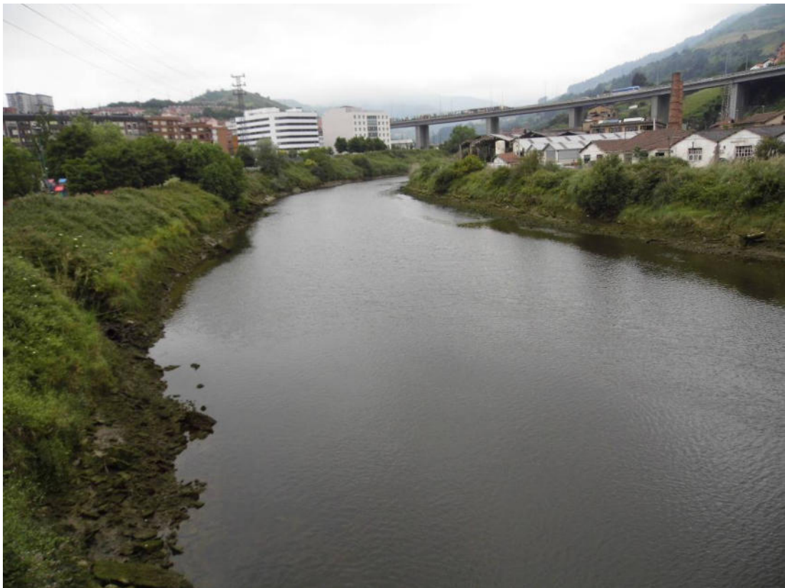
Fotografía nº 5.10. Río Cadagua aguas arriba del puente de la carretera N-634. En la margen izquierda, sector Calero. Al fondo, viaducto de la autovía E-70.
