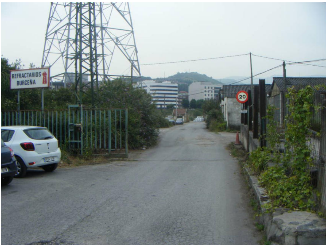
Fotografía nº 5.2. Construcciones del sector Calero, en la margen izquierda del río Cadagua.
