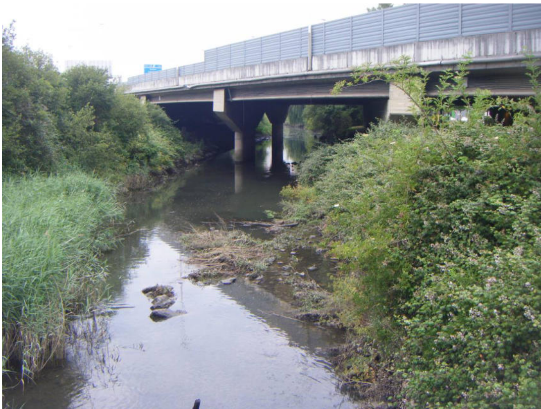
Fotografía nº 2.1. Cruce del río Castaños con la autovía A-8.
