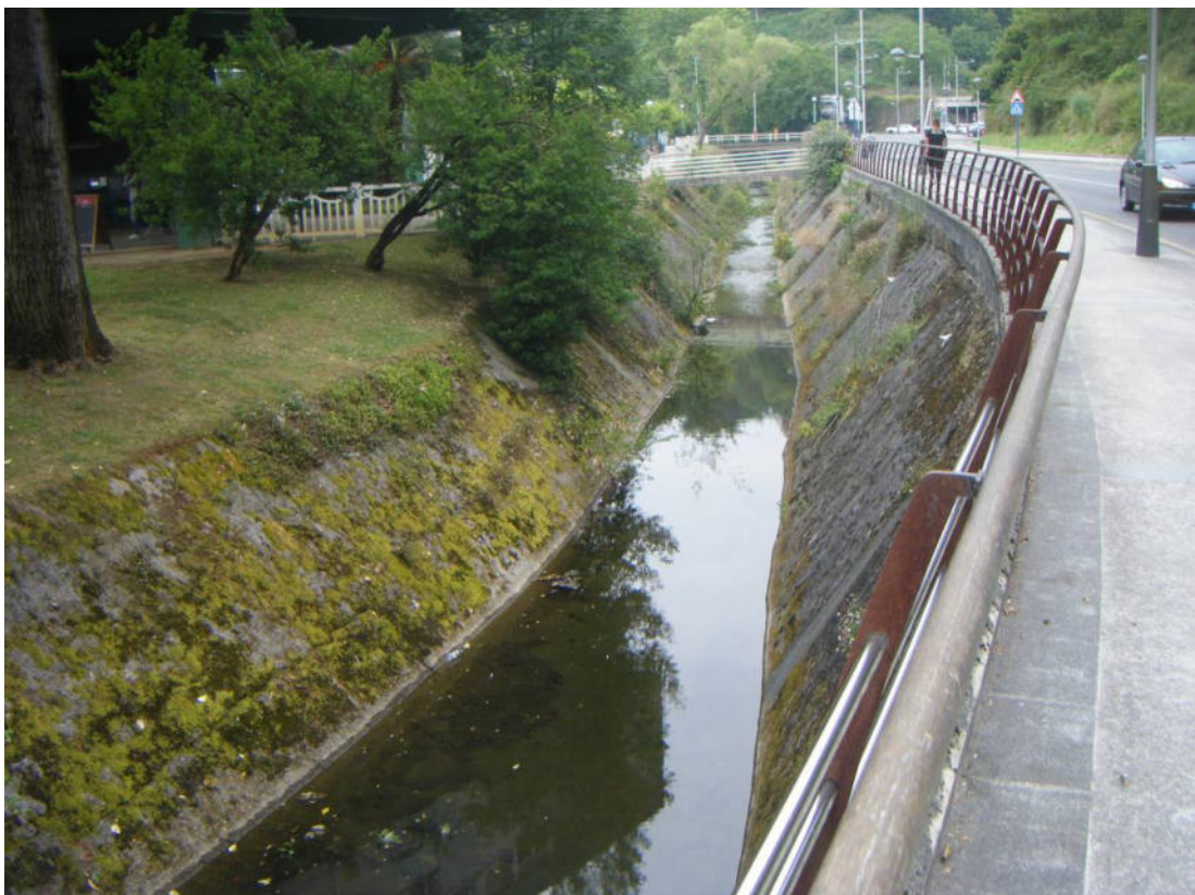
Fotografía nº 4.4. Tramo encajado en estructura de hormigón a la altura del polideportivo Gorostiza.
