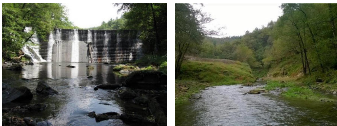
Figura 35. Fotografías de la presa de Inturia (río Leizaran) antes y después de su demolición. La presa tenía una altura de 12,5 metros y está ubicada en la ZEC Río Leizaran ES2120013.
