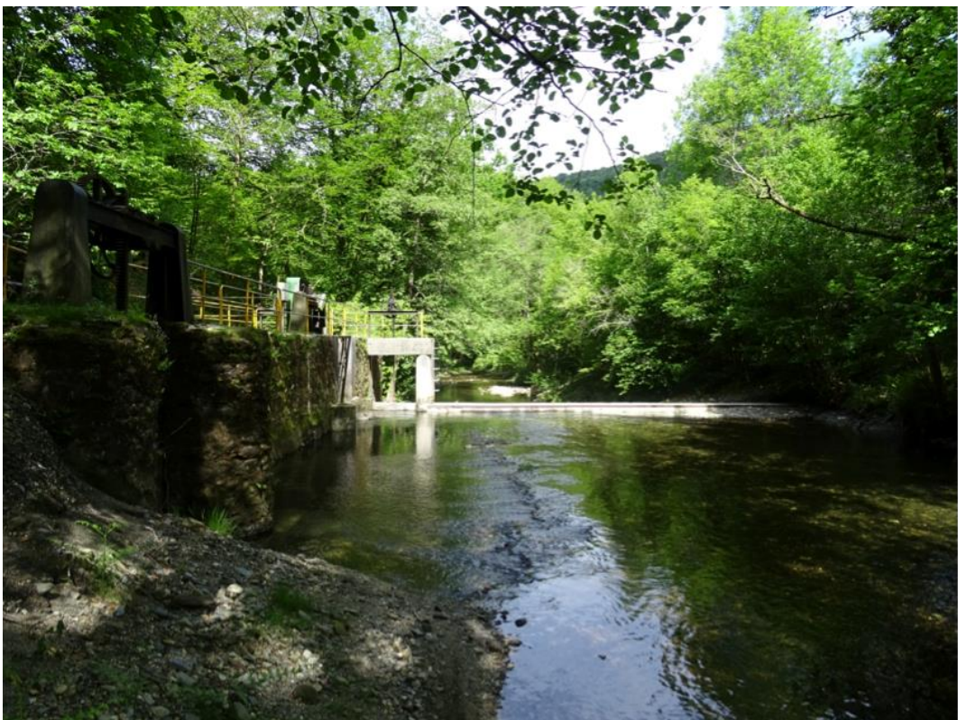
Azud para captación sin escala de peces
