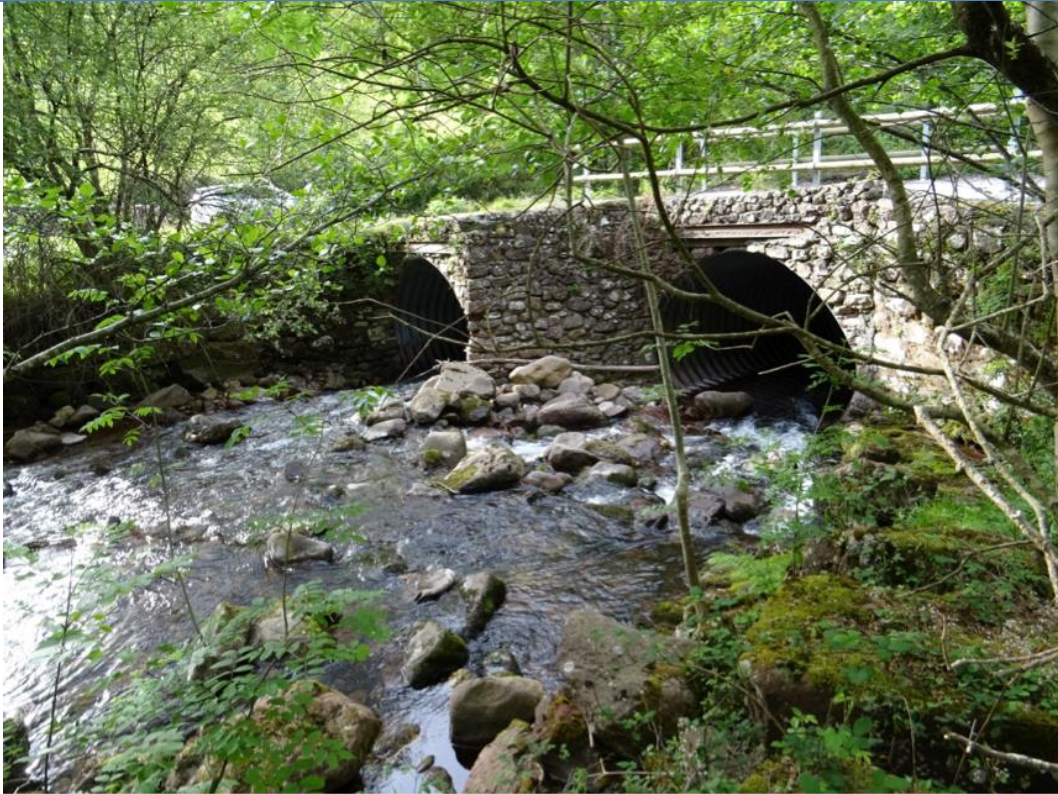
Doble paso entubado en el río Urrizate
