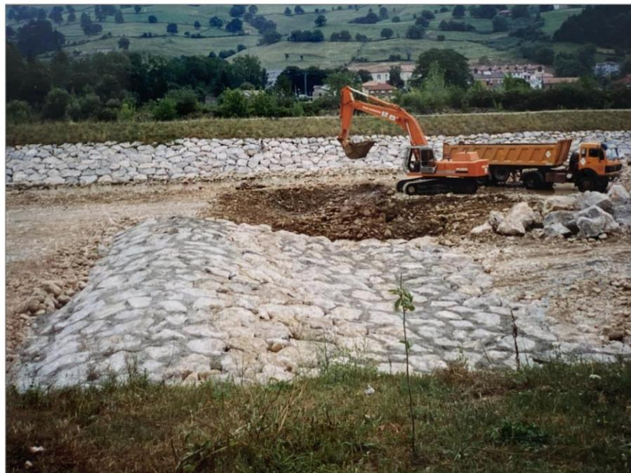
Fotografía 78. Proceso de ejecución de las obras del Proyecto de Defensas contra Avenidas en el tramo medio del río Pas (Tramo II: Puente de la Unión Deseada a Bárcena de Toranzo). Vista de la ejecución de uno de los resaltos para pérdida de energía.
