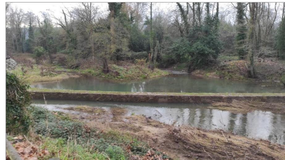
Fotografía 141. Azud sin datos aguas abajo del anterior, cuenta con canal de desvío a lo que parece ser una antigua central hidroeléctrica aguas arriba de Barcenilla.
