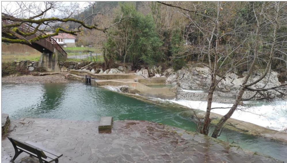
Fotografía 136. Azud de la central hidroeléctrica de Puente Viesgo.
