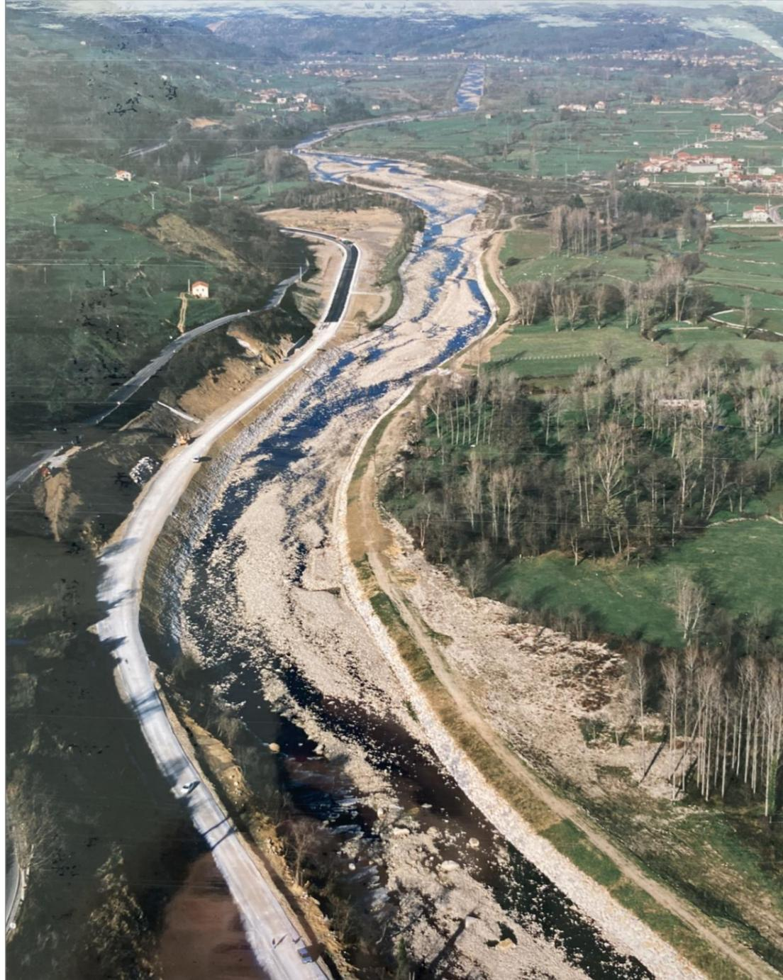
Fotografía 80. Proceso de ejecución de las obras del Proyecto de Defensas contra Avenidas en el tramo medio del río Pas (Tramo II: Puente de la Unión Deseada a Bárcena de Toranzo). Vista aérea de la ejecución de la canalización aguas arriba del puente de la Unión Deseada.
