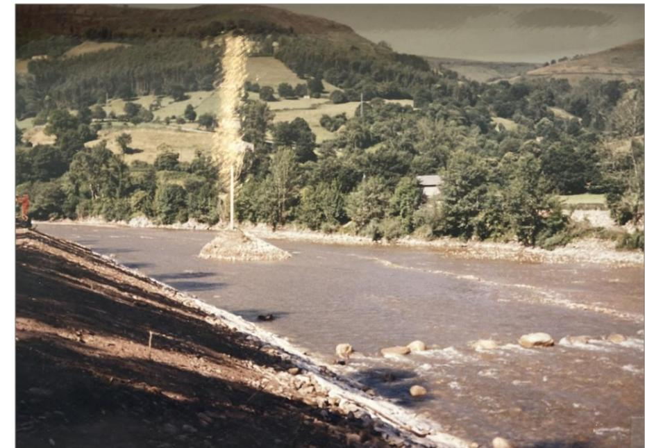
Fotografía 76. Proceso de ejecución de las obras del Proyecto de Defensas contra Avenidas en el tramo medio del río Pas (Tramo II: Puente de la Unión Deseada a Bárcena de Toranzo). Vista de un tramo de canalización en ejecución. Se observa la excavación sobre el nivel del terreno original que se mantiene en la isla por la existencia de un poste eléctrico a trasladar aún en ese momento. 10/7/95.
