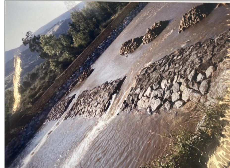
Fotografía 75. Proceso de ejecución de las obras del Proyecto de Defensas contra Avenidas en el tramo medio del río Pas (Tramo II: Puente de la Unión Deseada a Bárcena de Toranzo). Vista de uno de los resaltos para pérdida de energía. 10/7/95.
