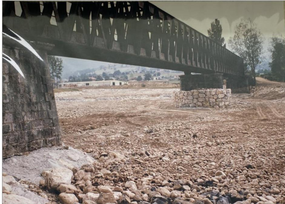
Fotografía 77. Proceso de ejecución de las obras del Proyecto de Defensas contra Avenidas en el tramo medio del río Pas (Tramo II: Puente de la Unión Deseada a Bárcena de Toranzo). Vista de las protecciones de las pilas del puente del antiguo FF.CC. Santander-Ontaneda.
