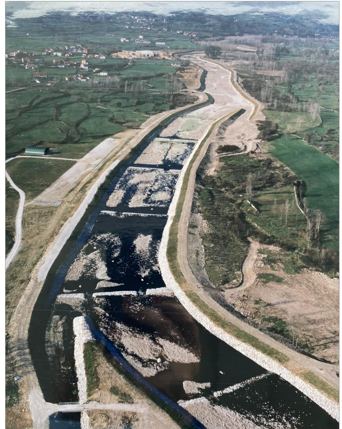
Fotografía 79. Proceso de ejecución de las obras del Proyecto de Defensas contra Avenidas en el tramo medio del río Pas (Tramo II: Puente de la Unión Deseada a Bárcena de Toranzo). Vista aérea de la ejecución de la canalización aguas abajo de Ontaneda.
