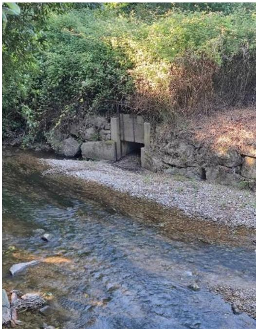
*Foto 8. Compuerta de canal de derivación situada en la margen derecha que aporta agua al humedal ornitológico Alfredo Noval, colmatado por aporte de sedimentos en avenidas. Coordenadas ETRS 89, Huso 30T, X:285556 Y:4820800.*
