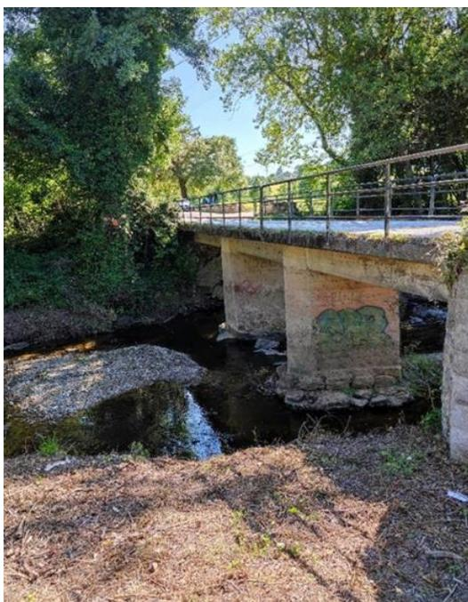
*Foto 7. Puente sobre el río Piles que da acceso al Parque de Granda. Presencia de sedimentación que evidencia el efecto azud. Coordenadas ETRS 89, Huso 30T, X:285565 Y:4820776.*
