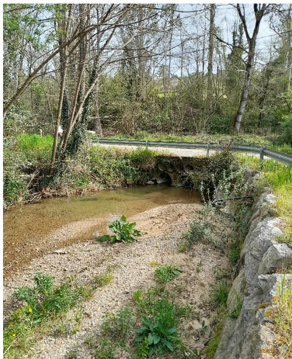
Foto 17. (990-17-41) Arroyo de San Tirso en la zona próxima a su confluencia con el río Pinzales. Reducción de la sección natural del cauce por pasos entubados. Coordenadas ETRS 89, Huso 30T, X:280297, Y:4814477.
