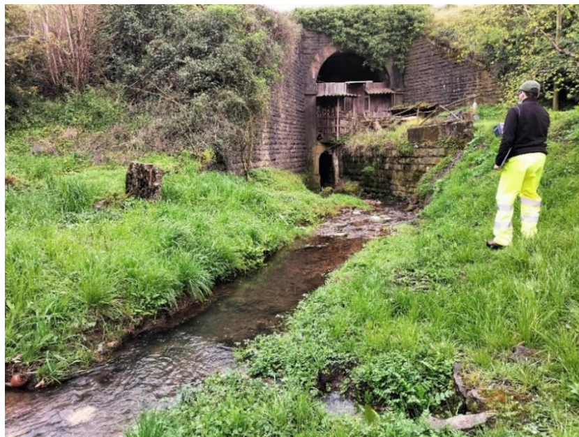
Foto 15. Inicio de la cobertura del Arroyo de Reguerón. Bajo una estructura de almacenamiento. Coordenadas ETRS 89, Huso 30T, X: 277533, Y: 4821687.
