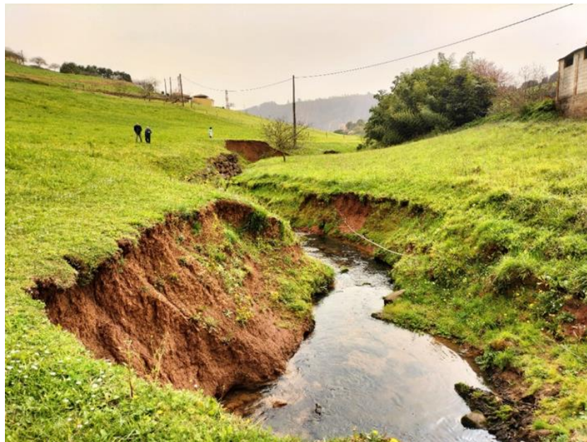
Foto 18: Erosión de márgenes en el Arroyo Reconco, a su paso por Barreres. Coordenadas ETRS 89, Huso 30T, X: 278586, Y: 4826344.
