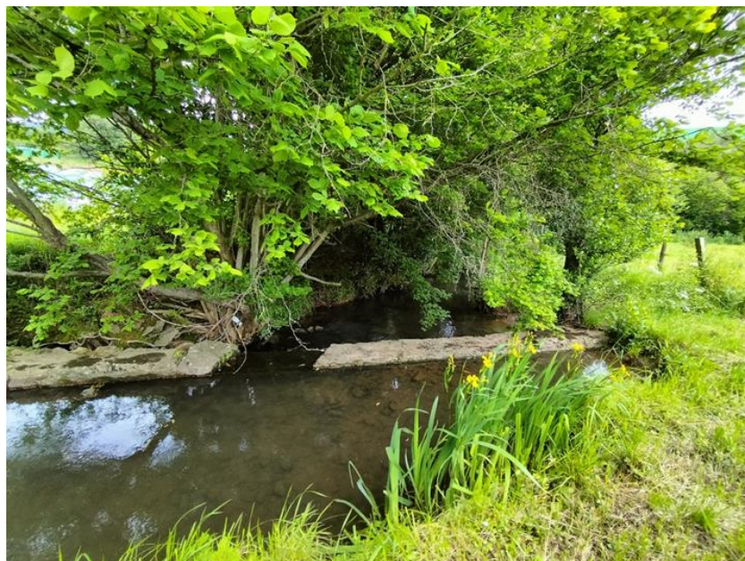
Foto 25. Obstáculo transversal en el río Pervera a su paso por la localidad de Manzaneda. Coordenadas ETRS 89, Huso 30 T, X: 277878, Y: 4825313.
