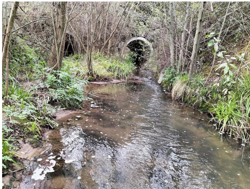
Foto 16. Confluencia de entubamientos de los Arroyos Vegona y Melendrera. Coordenadas ETRS 89, Huso 30T, X: 277561, Y: 4821666.
