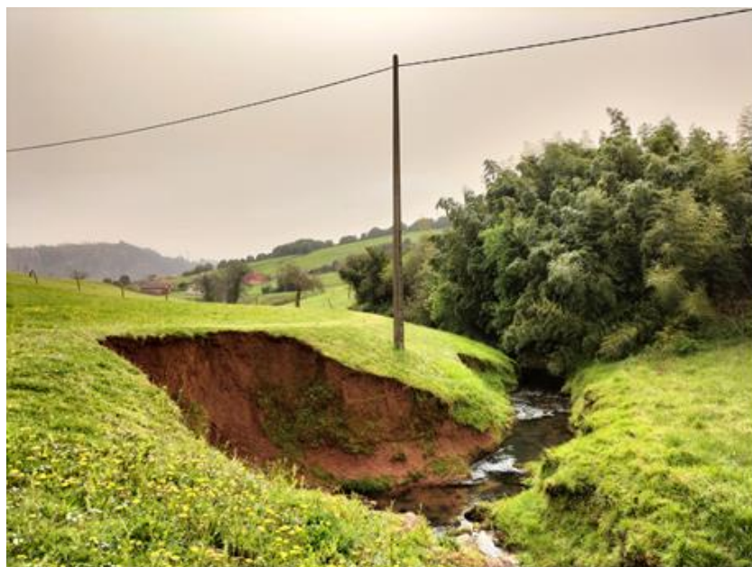
Foto 17. Erosión de márgenes en el Arroyo Reconco en la margen izquierda, a su paso por Barreres. Coordenadas ETRS 89, Huso 30T, X: 278639, Y: 4826309.
