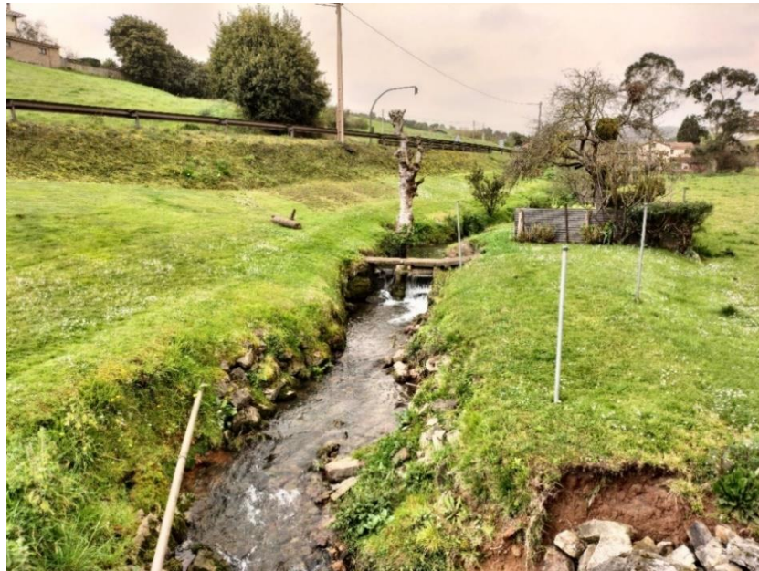
Foto 22. Obra de paso en el arroyo Reconco, a su paso por el restaurante el Empalme, coordenadas ETRS 89, Huso 30T, X: 279164, Y:4826015
