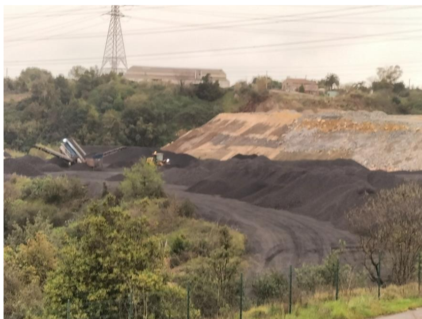
Foto 11. Escombrera zona de policía de la margen derecha del Río Pinzales. Coordenadas ETRS 89, Huso 30T, X: 279837, Y: 4822669.
