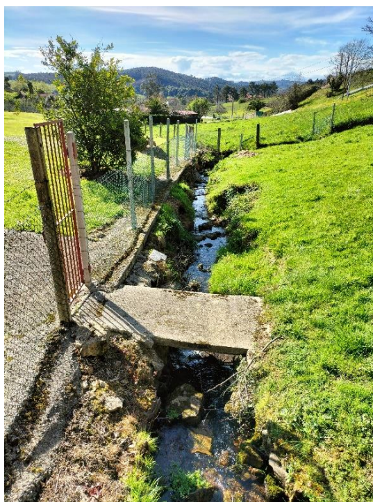
Foto 6. (861-6-17) Paso elevado sobre el el arroyo el Castro, ocupación de la zona de servidumbre y ausencia de vegetación, coordenadas ETRS 89, Huso 30 T, X: 274864, Y: 4820978.
