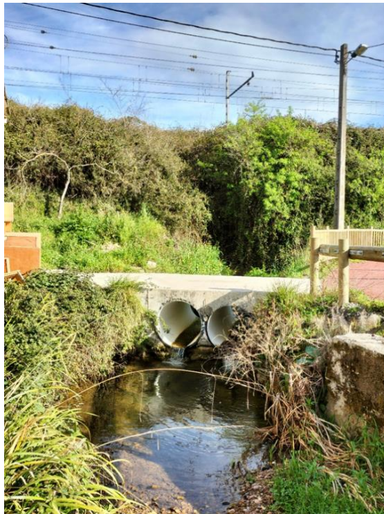
Foto 4. (861-6-15) Paso sobre el cauce del arroyo del Castro, tributario del río Aboño por la margen izquierda, mediante tubos paralelos coordenadas ETRS89, X: 274946, Y: 4820578.
