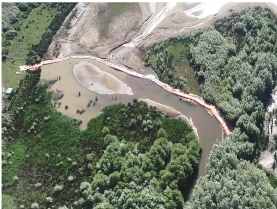
Foto 6. (861-5-10) Ataguía provisional de arcilla, en el embalse de San Andrés de los tacones, coordenadas ETRS 89, Huso 30T, X: 276336, Y: 4820104.
