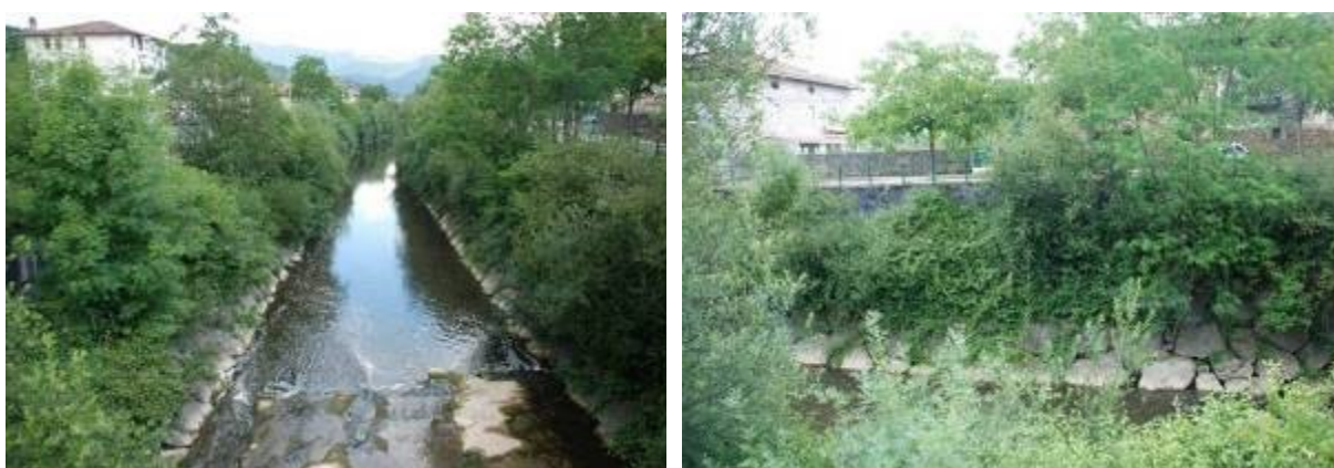
Foto 17 Nerbioi a su paso por barrio de Santa Cruz. Tramo modificado con taludes de escollera.
