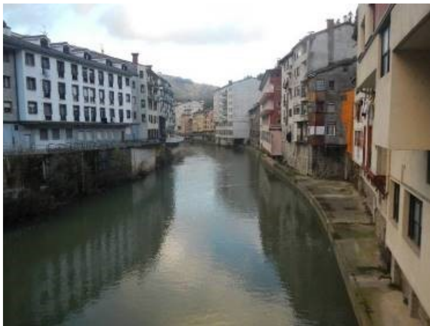
Foto 74 Núcleo urbano de Soraluze, edificaciones que flanquean el cauce.
