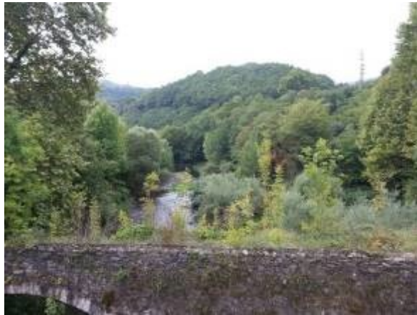
Foto 70 Vegetación de ribera en buen estado aguas arriba del puente Amillaga. En primer plano el puente viejo de Amillaga en desuso que se prevé demoler.
