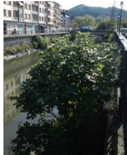
Foto 35 Higuera implantada en el muro lateral del tramo encauzado.
