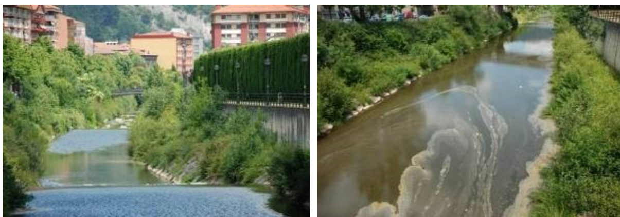
Foto 16 Nerbioi a su paso por el ámbito de la fase 2. Se observa la banqueta de aguas bajas y la escollera y muro de contención junto al paseo de la margen derecha. Detalle de problemas en la calidad del agua.
