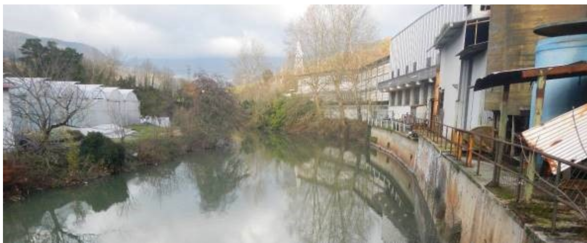
Foto 69 Zona agrícola en margen izquierda y pabellones sobre el cauce en margen derecha aguas abajo del puente de la calle Amillaga.
