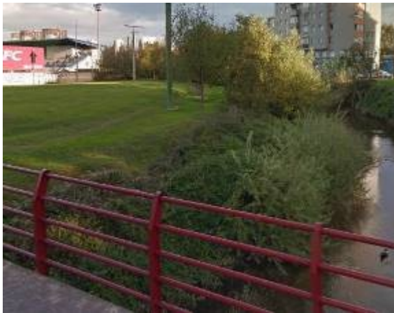
Foto 55 Zona a disponer mota hasta el encuentro con el puente de la N-634.
