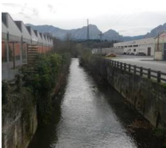
Foto 3. Encauzamiento del río Zaldu.
