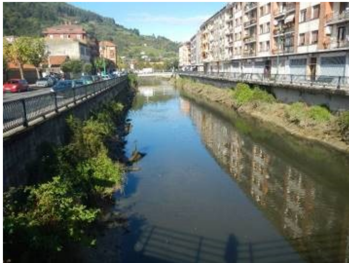
Foto 34 Tramo del río Oka encauzado a su paso por la zona urbana de Gernika.
