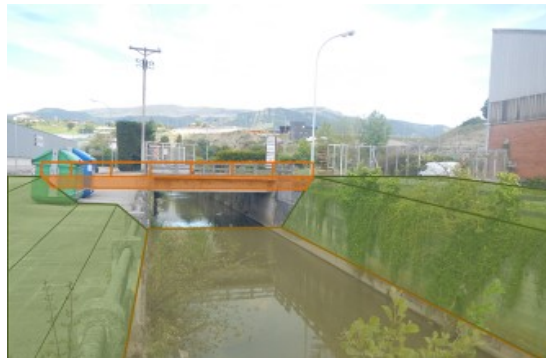
Foto 4. Paso a sustituir en zona industrial.
