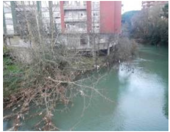
Foto 46 Presión urbana en margen derecha aguas arriba del puente de la calle Fray Juan de Zumarraga.
