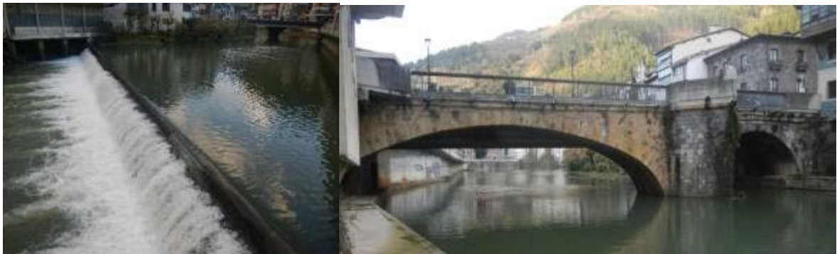
Foto 73 Azud de Igareta a rebajar la cota PK 2+228, ámbito de retirada de acarreo bajo Zubi Nagusia.
