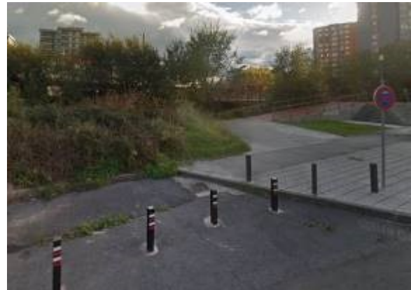
Foto 54 Zona de encuentro con la pasarela actual existente.
