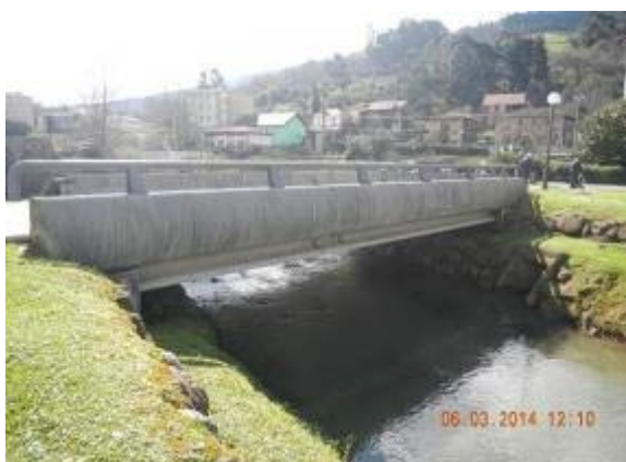
Foto 63 Pasarela del parque de Arkotxa vista desde aguas abajo.
