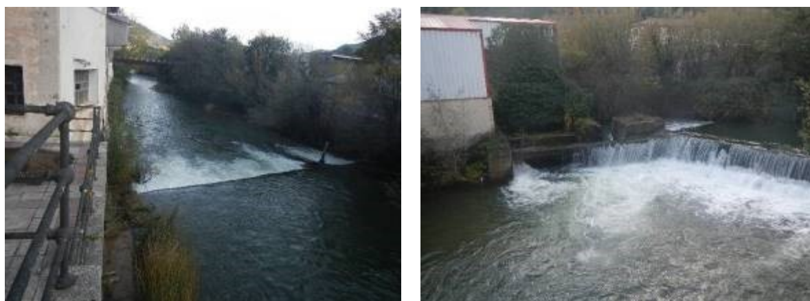
Foto 38 Azudes sucesivos de la ferrería de Laiseca. El azud de aguas abajo del PK 31+254 (izda.) se elimina, el azud de aguas arriba, se rebaja 1 m para mantener la derivación lateral donde se conserva la toma y vertido.
