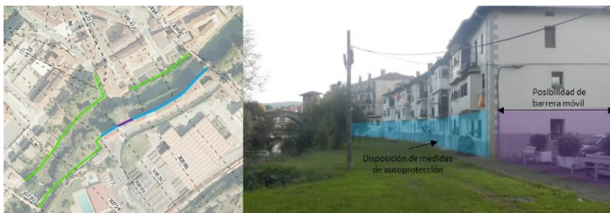
Figura 81 Vista desde aguas arriba del puente Viejo en Balmaseda; viviendas en margen derecha.
