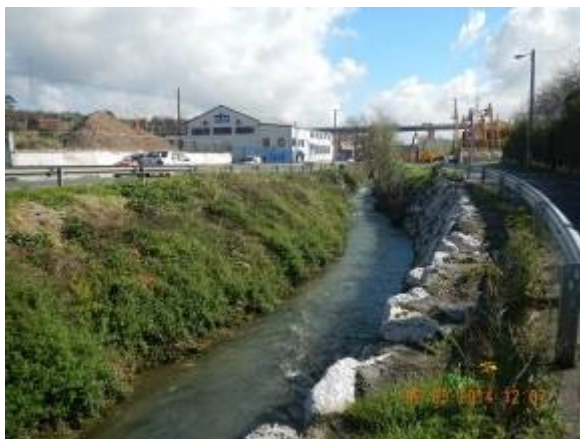
Foto 61 Zona de cauce a acondicionar.
