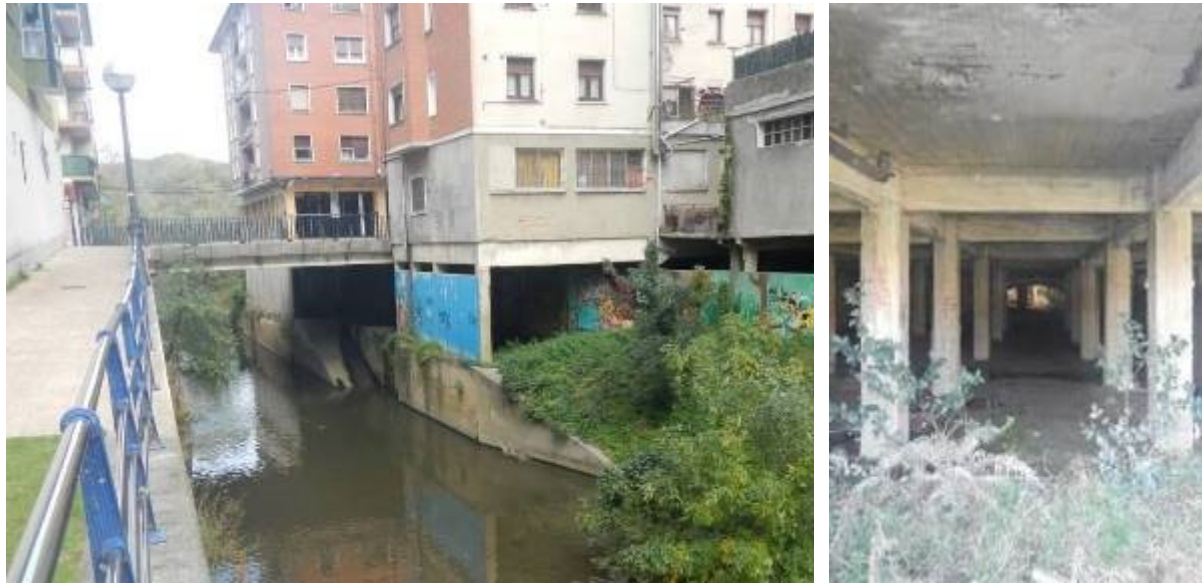
Foto 18 Edificios a demoler aguas arriba y aguas abajo del paso de la estación y bajos de dichos edificios.
