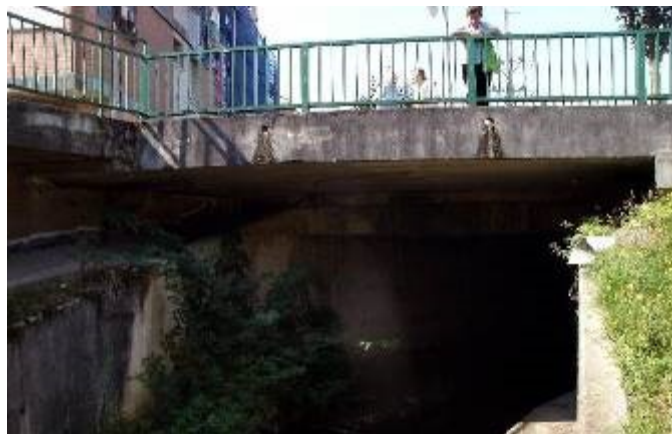
Foto 64 Salida de la cobertura.
