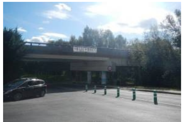
Foto 33 Zona de acceso del agua PK 4+800.
