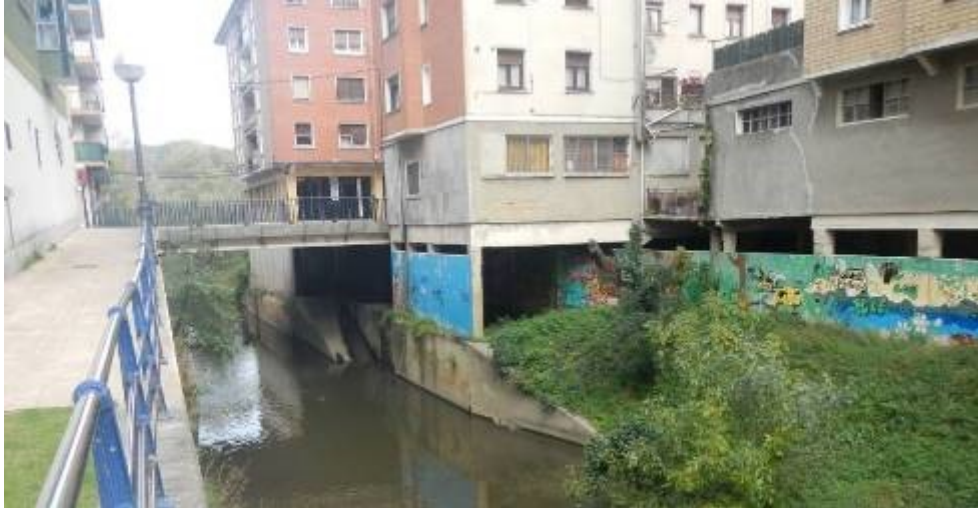
Foto 23 Tramo urbano en el que el río está limitado por un muro lateral de hormigón en margen izquierda y los paramentos de los edificios en margen derecha, estando dos edificios situados sobre el cauce.
