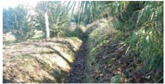
Foto 30 Canal paralelo al terraplén de la BI-635.
