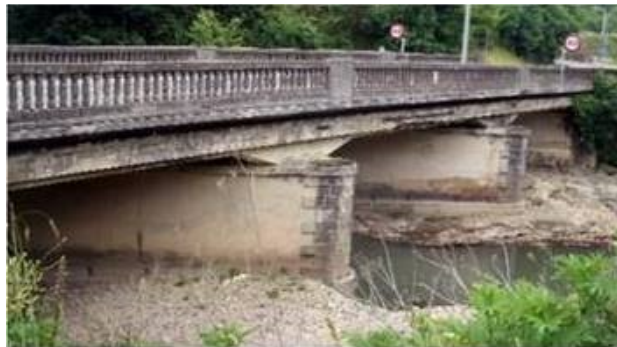
Foto 68 Puente de la GI-2632 a sustituir.
