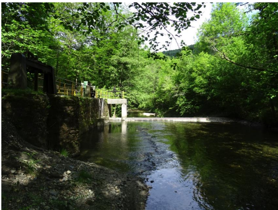
Azud para captación sin escala de peces
