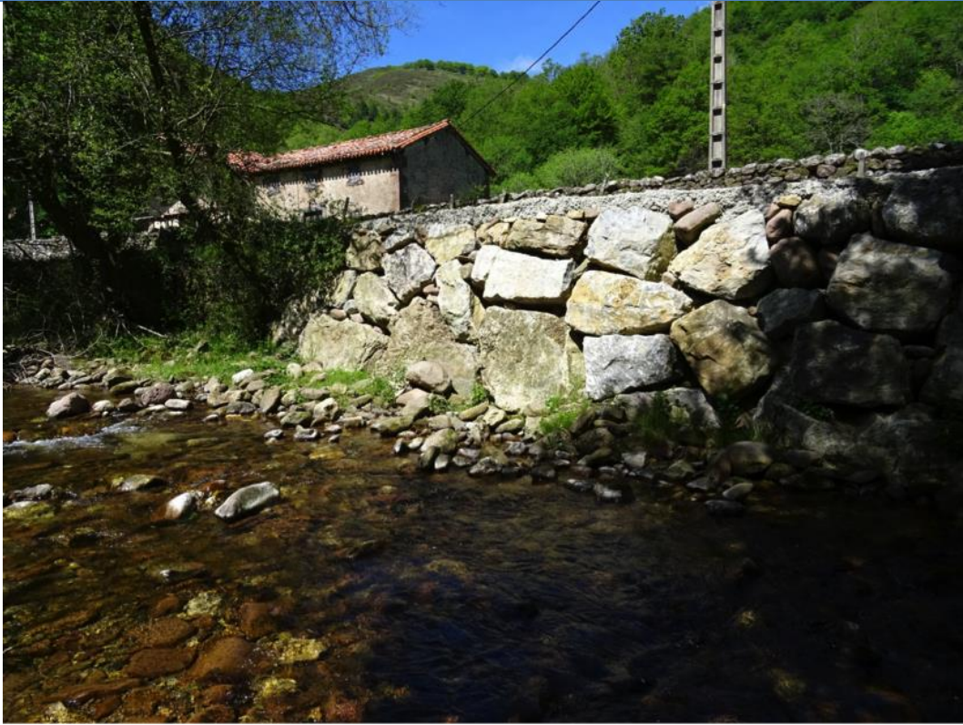
Muro de protección para pista
