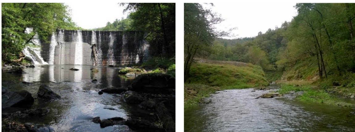
Figura 35. Fotografías de la presa de Inturia (río Leitzaran) antes y después de su demolición. La presa tenía una altura de 12,5 metros y está ubicada en la ZEC Río Leitzaran ES2120013.
