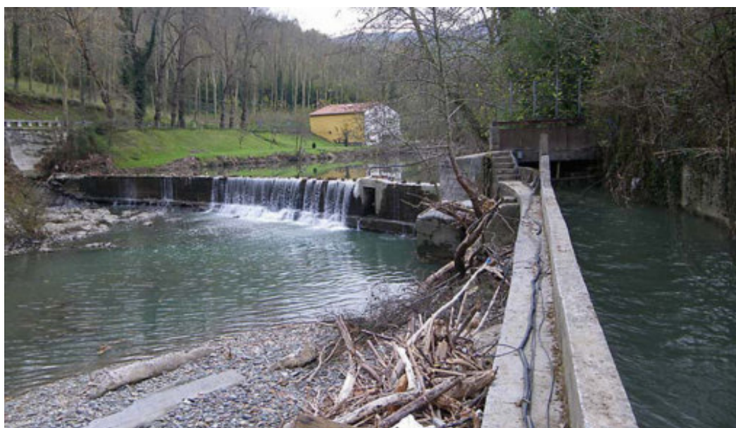
Figura 73. Desvío de agua para el salto hidroeléctrico de Altuna-Txiki en el río Urola (Gobierno Vasco).
