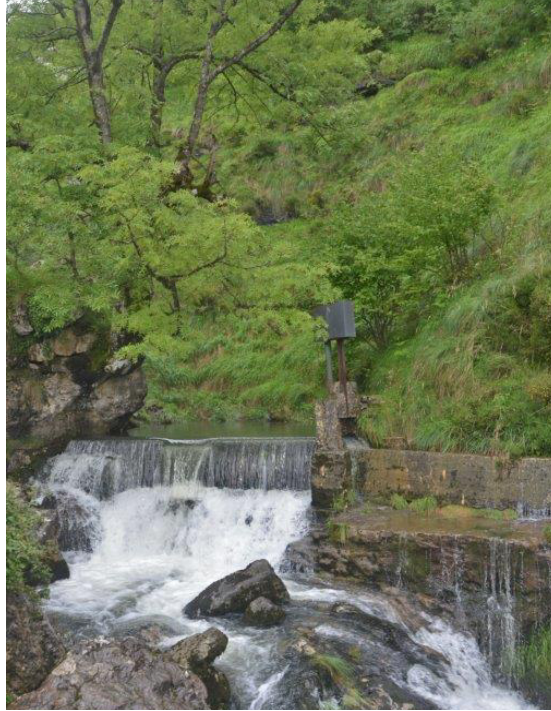
Figura 118. Captación del manantial Aldabide (macizo de Itxina) (Agencia Vasca del Agua).
