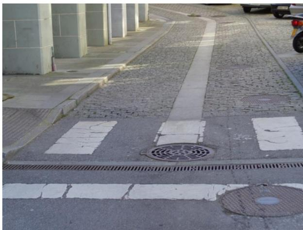
Figura 33.- Sistema de pluviales en el núcleo urbano de Vegadeo
