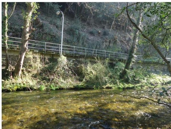
Figura 4.- Tramo de la AS-219 a proteger con escollera para evitar socavaciones
