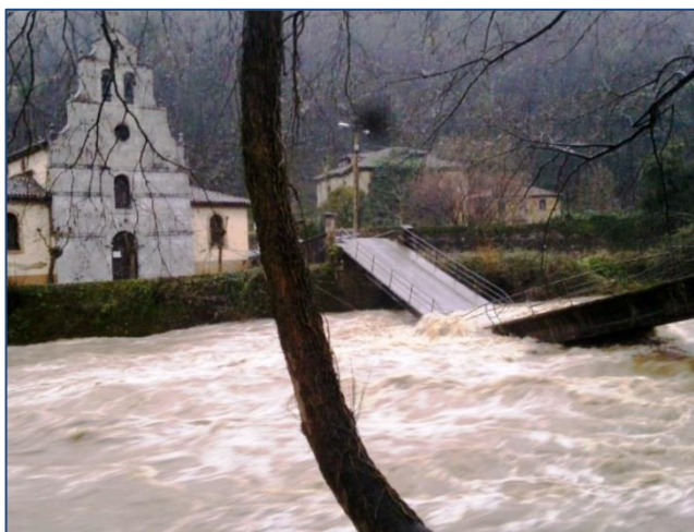
Figura 13.- Daños causados por inundaciones (Fuente: MAGRAMA)
