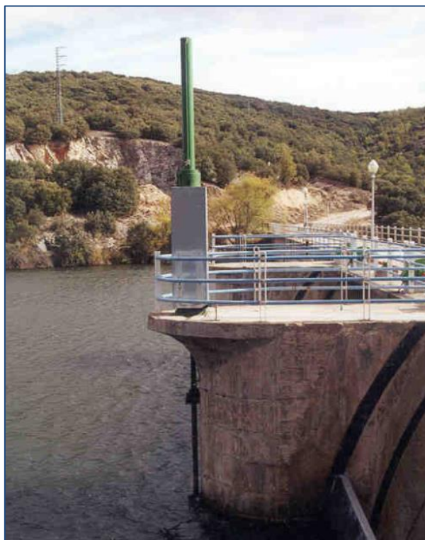
Figura 5.- Presa de La Cohilla (Fuente: SNCZI)
