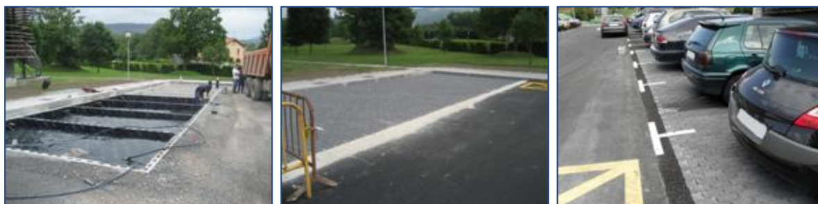
Figura 6.- Aparcamiento de firmes filtrantes ( http://www.giteco.unican.es )
