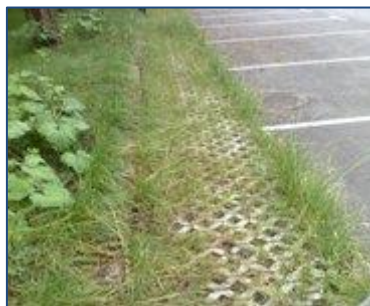
Figura 8.- Dren filtrante ( http://www.giteco.unican.es )
