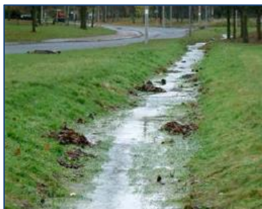
Figura 10.- Cuneta verde (Fuente: Universidad de Cantabria)
