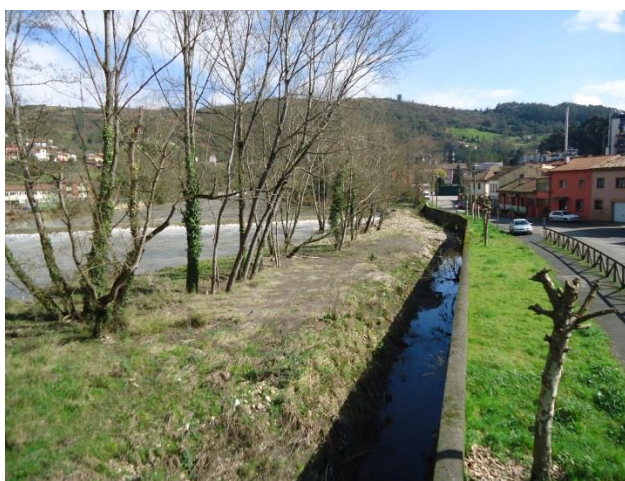
Figura 8.- Paseo y murete perimetral en margen izquierda del río Nalón
