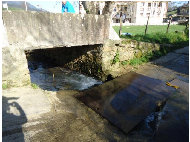
Figura 37.- Obra de paso sobre el arroyo Rocillo
