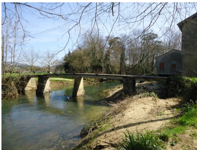
Figura 19.- Antigua pasarela de la panadería
