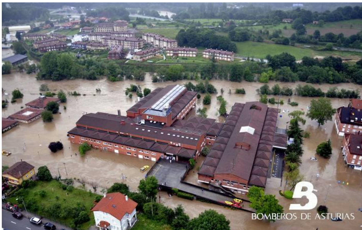
Figura 2: Inundaciones en 2010, casco urbano de Arriondas. Fuente: Bomberos de Asturias.
