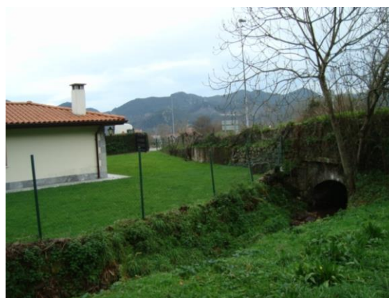
Figura 24.- Obra de paso bajo la N-634
