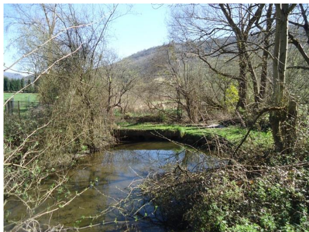
Figura 14.- Obra de paso sobre el arroyo de Vegalencia
