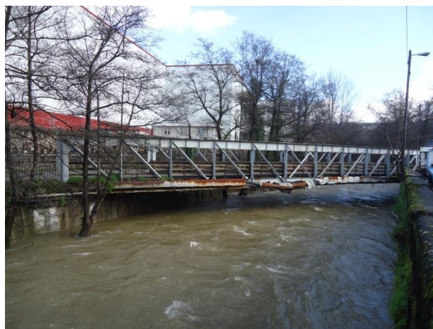
Figura 3.- Pasarela metálica del antiguo ferrocarril en el río Trubia
