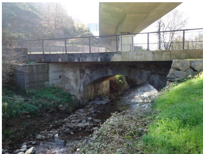
Figura 34.-Puente sobre el Río Bernales
