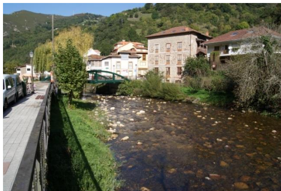
Figura 27.- Encauzamiento del río Pigüña en la localidad de Belmonte
