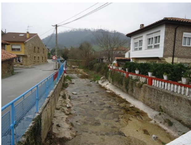
Figura 44.- Encauzamiento del arroyo Rebujas en San Mateo
