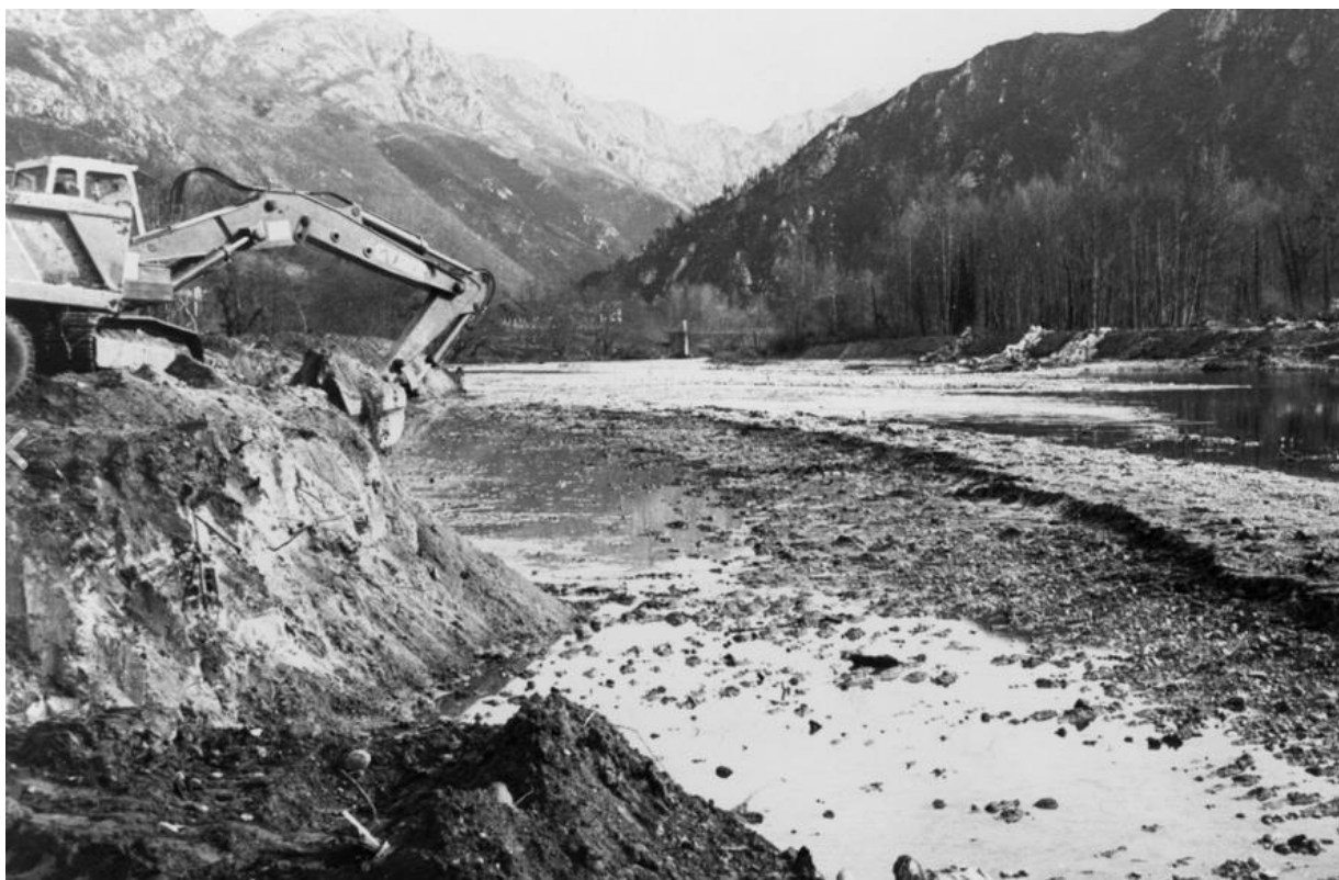
Figura 3: Obras de encauzamiento del río Sella a la altura de Arriondas. Fuente: La Nueva España 07/03/1985.
