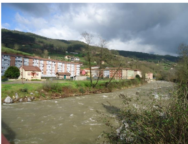
Figura 2.- Explanada en margen izquierda del río Trubia en la zona de “La Riera”
