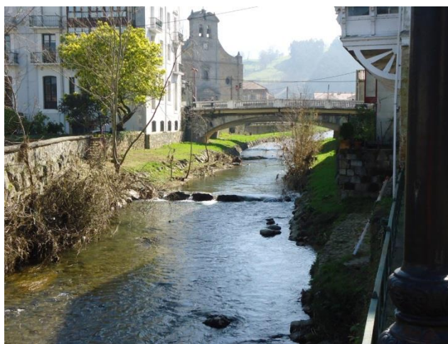
Figura 35.- Encauzamiento del río Bernales en Ampuero
