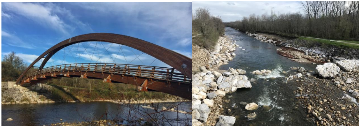
Figura 6: Pasarela e imagen de las protecciones aguas abajo de la misma, tras las avenidas de 2019.
