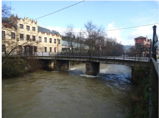
Figura 5.- Puente de 3 vanos sobre el río Trubia
