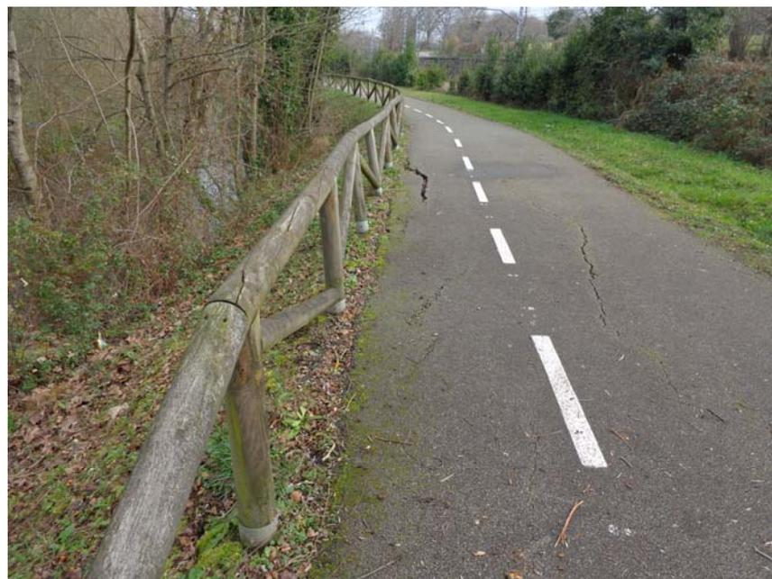
*Agrietamiento del firme por deslizamiento lateral del talud*
