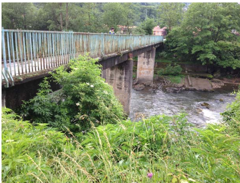
Puente sobre el Caudal con parte de la losa de aforo en la margen izquierda
