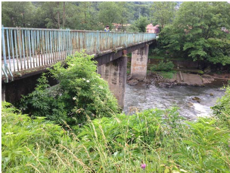
Puente sobre el Caudal con parte de la losa de aforo en la margen izquierda
