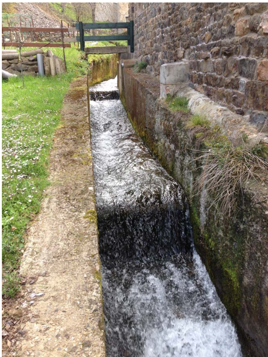
Tramo de canal con las distintas pendientes
