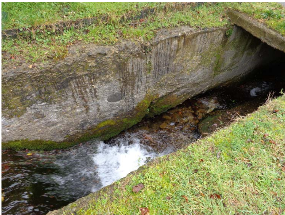
Embocadura del tramo cubierto
