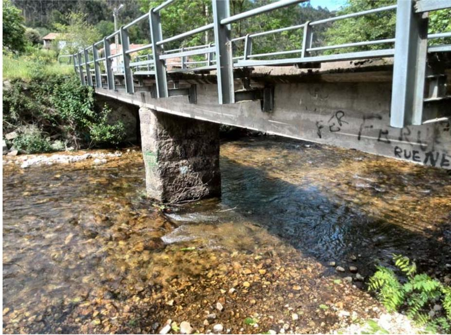
*Viga apoyada en el punto medio del cauce sobre pilastra de sillería*
