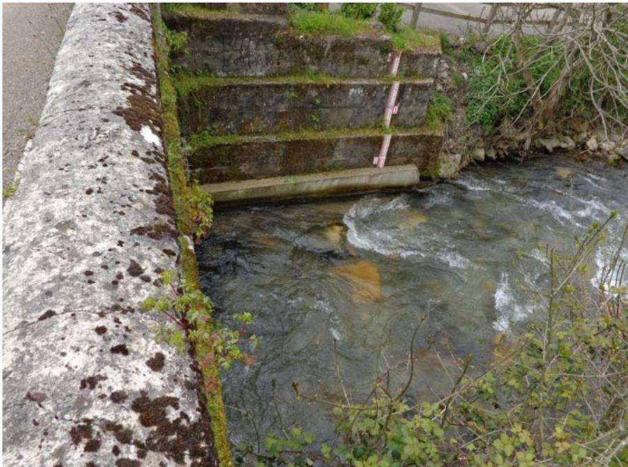
*Escala de control de aforo sobre la aleta del puente*
