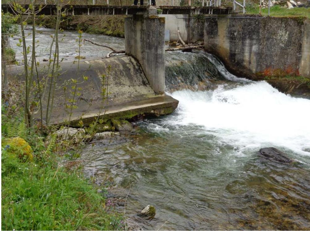
*Estructura socavada y losa arrastrada aguas abajo.*
