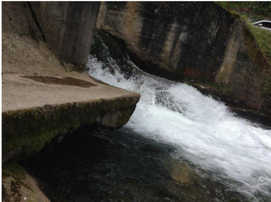
*Se aprecia la socavación de las losas y la rotura del apoyo del labio izquierdo.*
