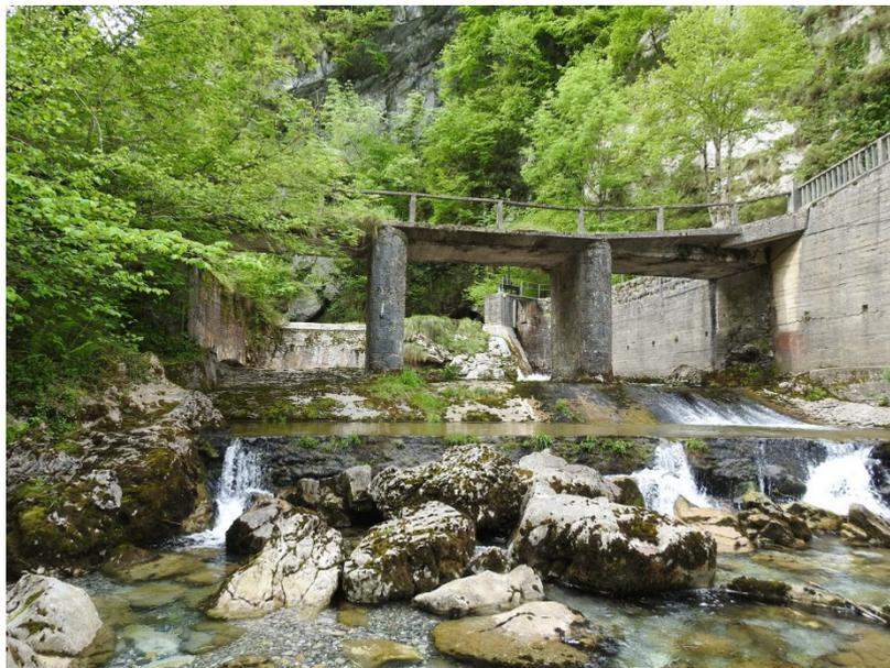
*Foto 11. Detalle del puente en el que se aprecia el tablero de hormigón y el cajeadado, también de hormigón, del cauce.*
