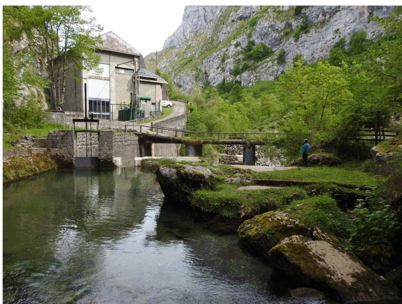
*Foto 9. Detalle del azud en el que se puede apreciar la compuerta tajadera y la arquitectura de la central hidroeléctrica.*
