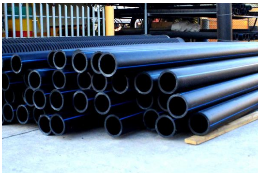
Imagen: Acopio de tuberías de PEAD
