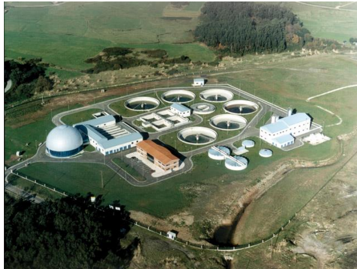
Estación depuradora de MAQUA
