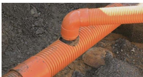
Imagen: Conexión acometida mediante codo
