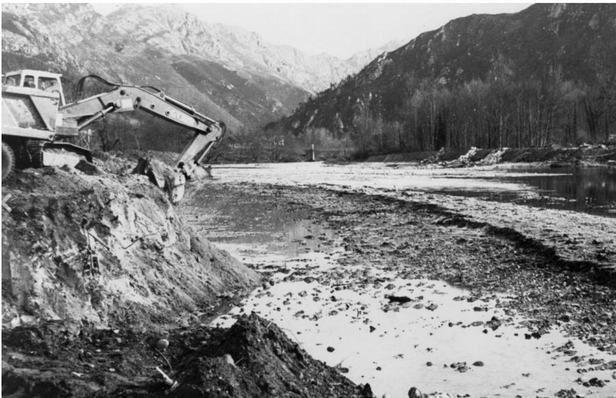
Figura 3: Obras de encauzamiento del río Sella a la altura de Arriondas. Fuente: La Nueva España 07/03/1985.
