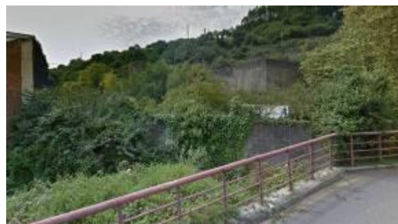
Foto 61 Pabellón y muro existente aguas arriba del puente de la calle Ametzaga.
