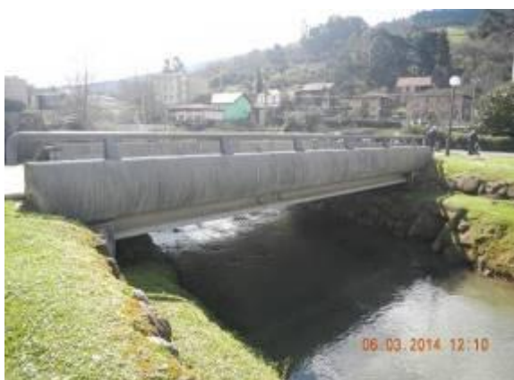
Foto 66 Pasarela del parque de Arkotxa vista desde aguas abajo.
