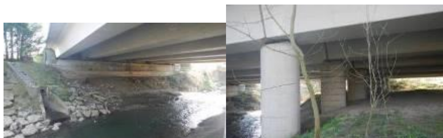
Foto 19 Condicionantes para la ampliación de sección bajo la BI-631.
