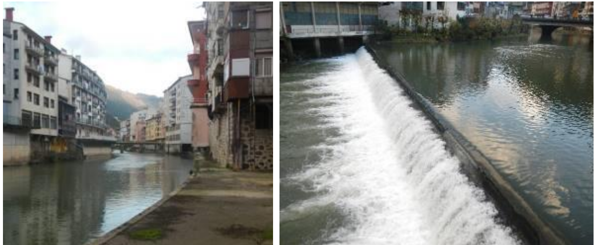
Foto 79 Edificios sobre el cauce (izquierda) y azud del Molino de Igareta (derecha).
