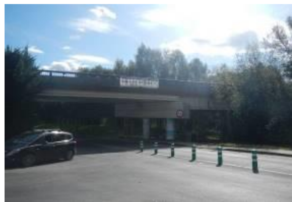
Foto 33 Zona de acceso del agua PK 4+800.
