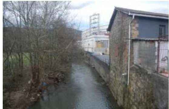
Foto 8. Pabellones aguas abajo de la BI-3333.
