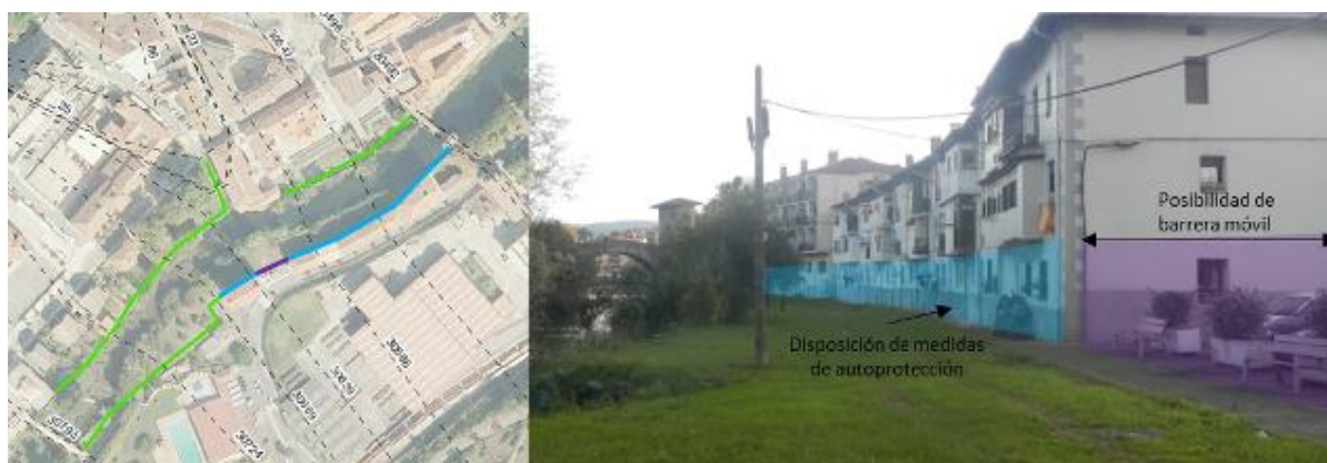
Figura 84 Vista desde aguas arriba del puente Viejo en Balmaseda; viviendas en margen derecha.
