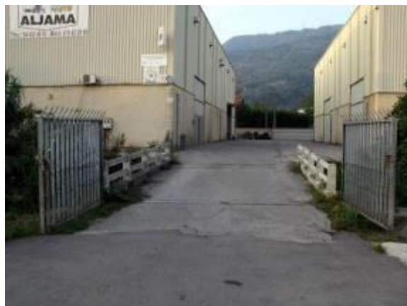
Foto 65 Pasarela de acceso al taller Aljama.
