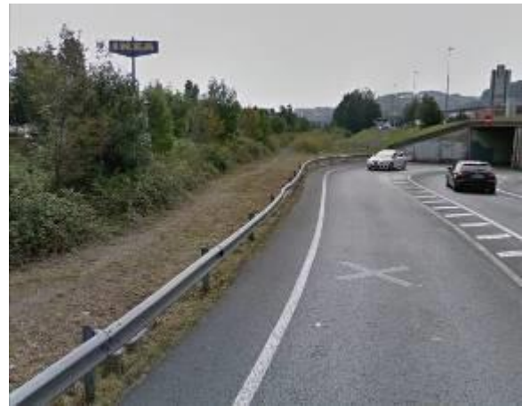
Foto 59 Enlace del Max Center, zona de cierre a la A-8. Posibilidad de barreras móviles.
