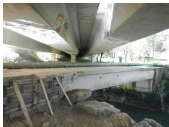
Foto 29 Zona de cierre del muro en MI bajo el paso de la BI-635.
