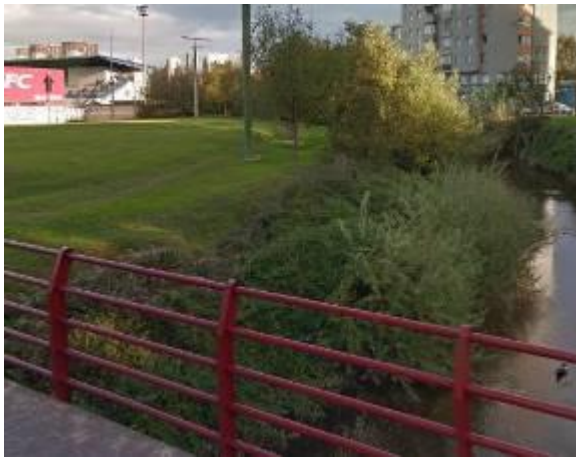
Foto 58 Zona a disponer mota hasta el encuentro con el puente de la N-634.
