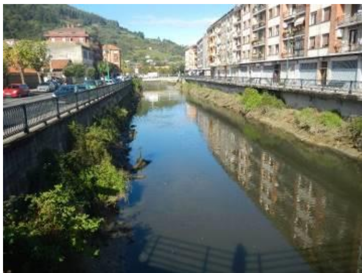
Foto 34 Tramo del río Oka encauzado a su paso por la zona urbana de Gernika.
