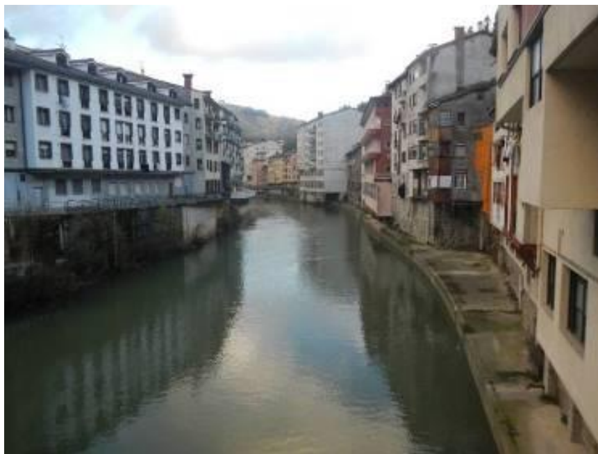
Foto 77 Núcleo urbano de Soraluze, edificaciones que flanquean el cauce.
