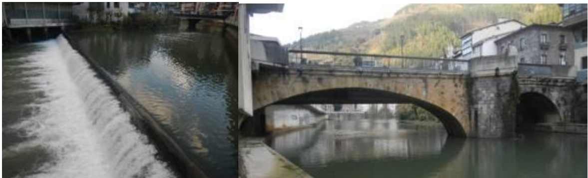
Foto 76 Azud de Igareta a rebajar la cota PK 2+228, ámbito de retirada de acarreos bajo Zubi Nagusia.
