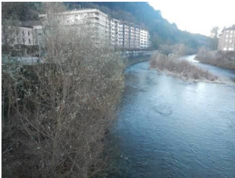
Foto 10 Ejemplar de sauce blanco ( Salix alba ) en barra de la margen izquierda, vegetación que ha colonizado una isla y una barra en margen derecha. Muro usado como zona de nidificación por el avión zapador.
