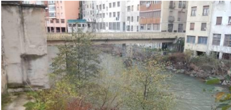
Foto 75 Pasarela a sustituir. PK 2+060.
