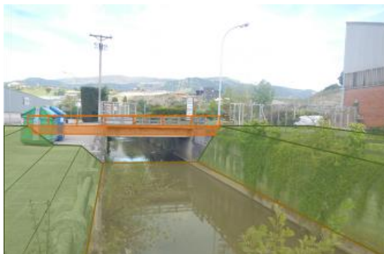
Foto 4. Paso a sustituir en zona industrial.
