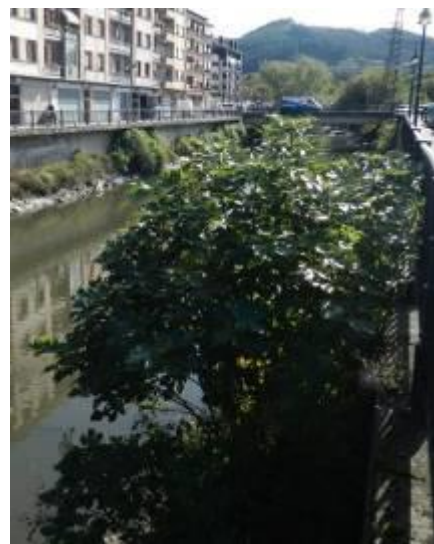
Foto 35 Higuera implantada en el muro lateral del tramo encauzado.
