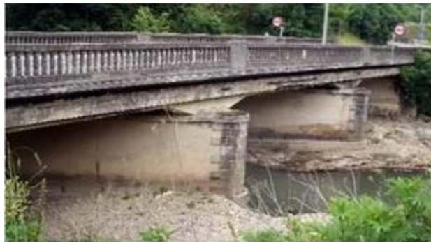
Foto 71 Puente de la GI-2632 a sustituir.
