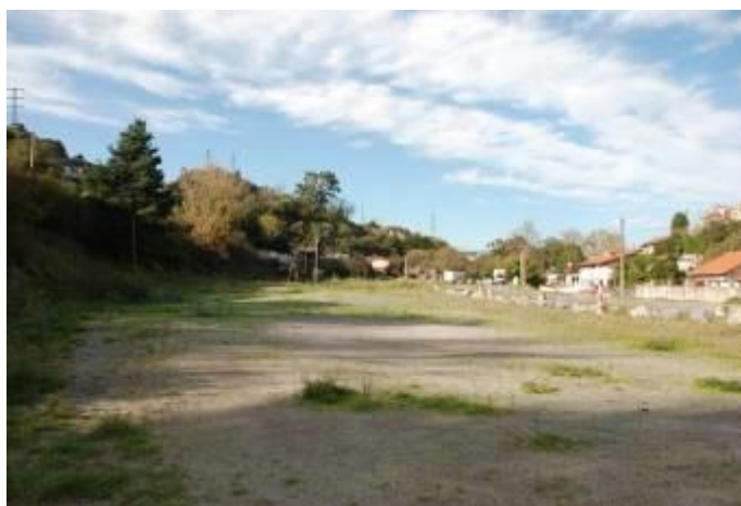
Foto 69 Estado actual de la explanada de la planta de cemento desmantelada.
