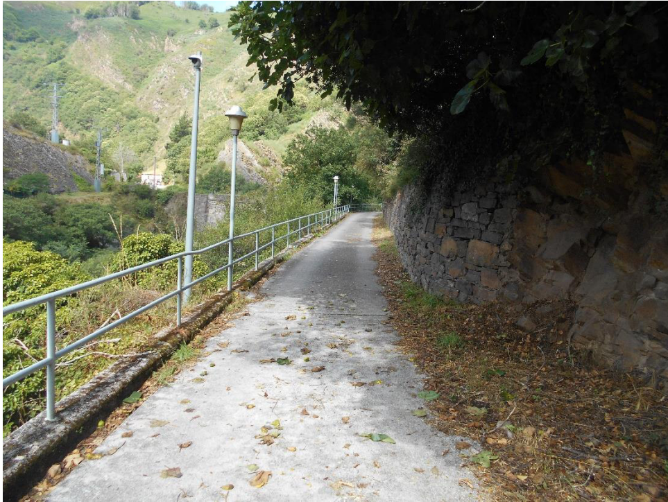
Imagen 4. Vista general del camino de acceso a la presa
