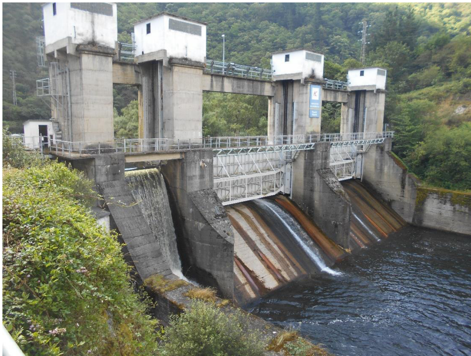
Imagen 3. Vista general de la presa de La Florida, aguas abajo.
