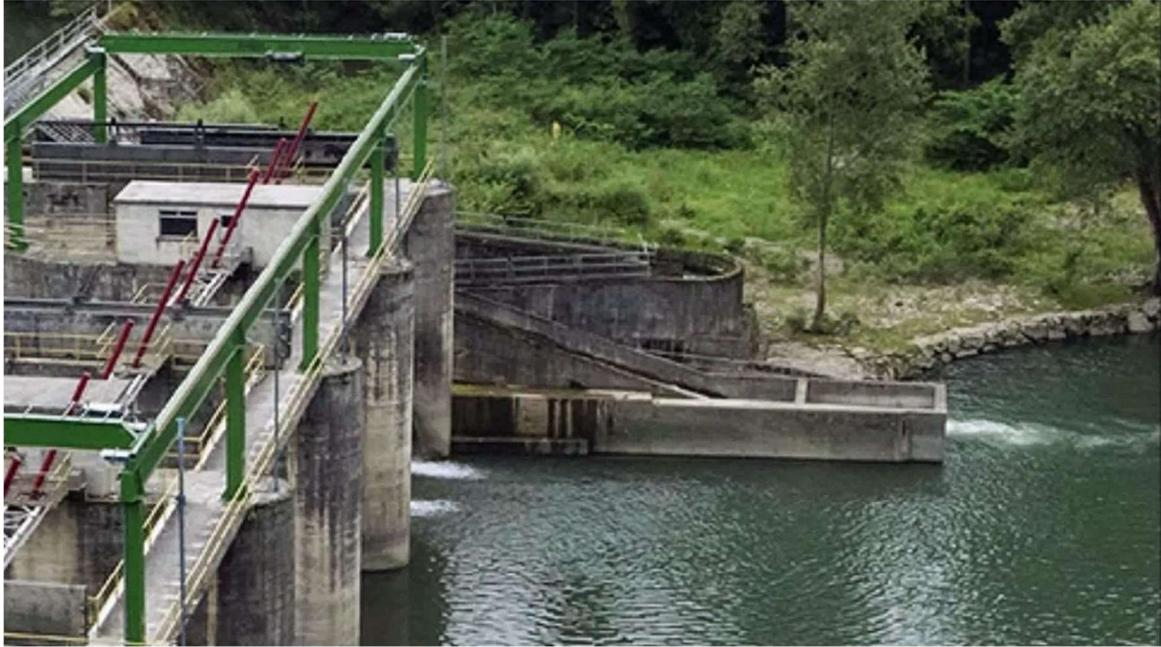
*Imagen 6. Vista general de la rampa y la escala de peces.*
