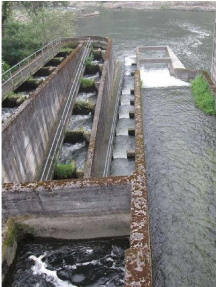
*Imagen 7. Vista detalle de la rampa y la escala de peces.*
