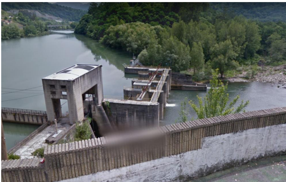
Imagen 3. Vista general de la presa del Furacón, aguas abajo.
