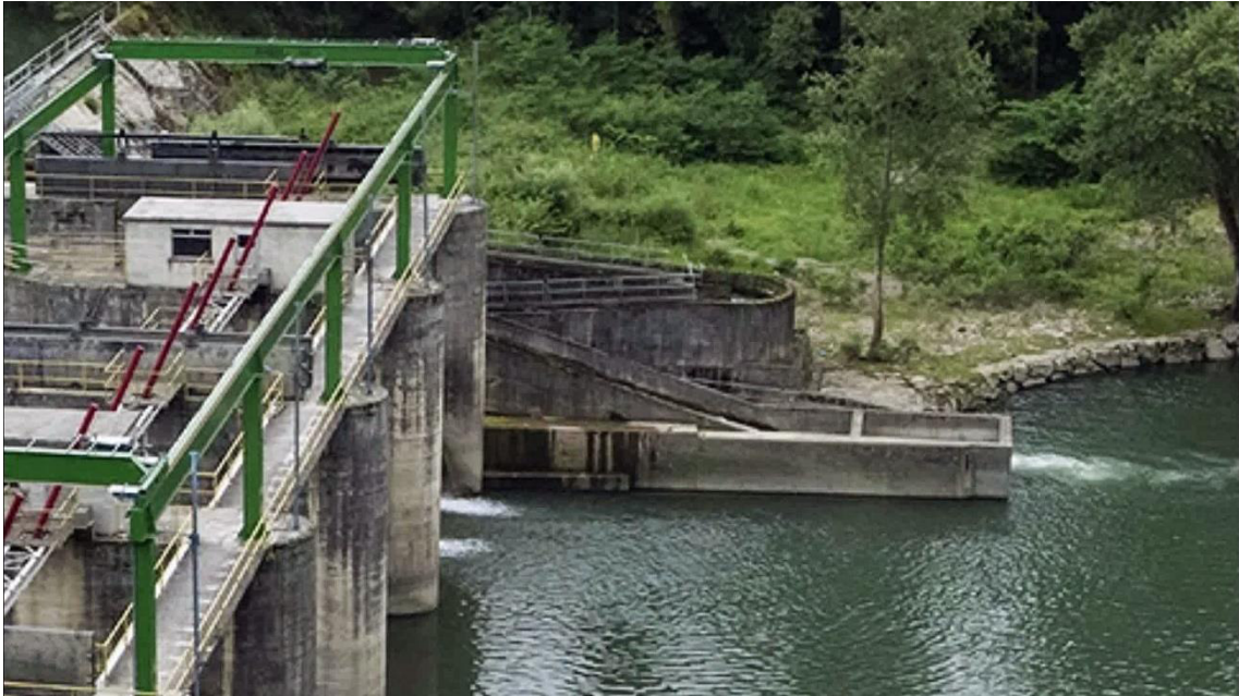
Imagen 4. Vista general de la rampa y la escala de peces.
