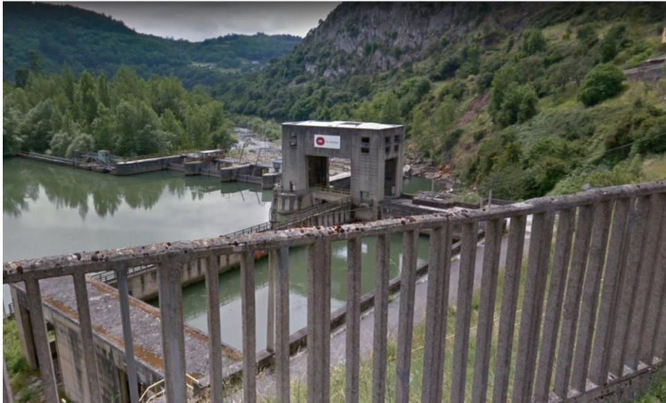
Imagen 2. Vista general de la presa del Furacón, aguas arriba.
