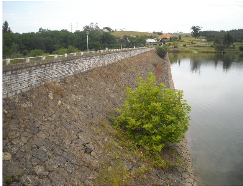
Fotografía 1. Vista del paramento de aguas arriba de la presa.
