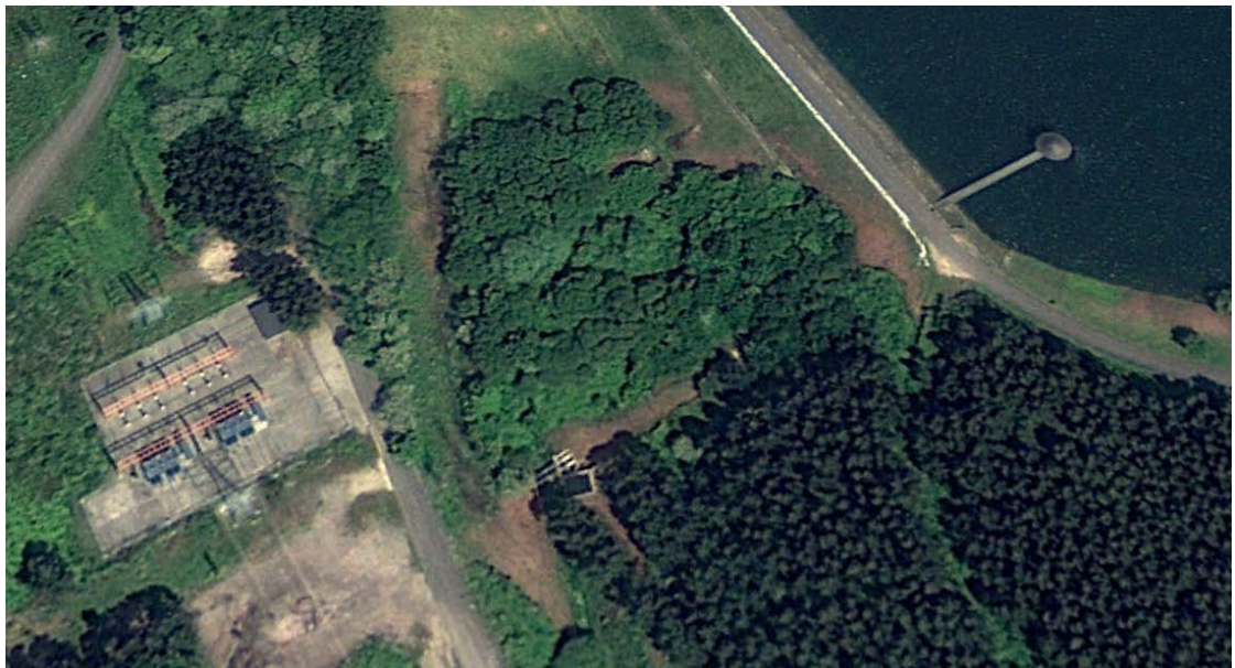
Fotografía 4. Vista aérea de las tres tuberías (dos tomas de agua y un desagüe de fondo) que salen en dirección suroeste desde la torre de mandos de la presa hacia la factoría, en la zona donde se llevarán a cabo los trabajos.
